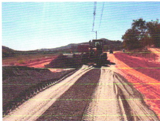
Foto 78 – Execução e compactação de sub-base.
