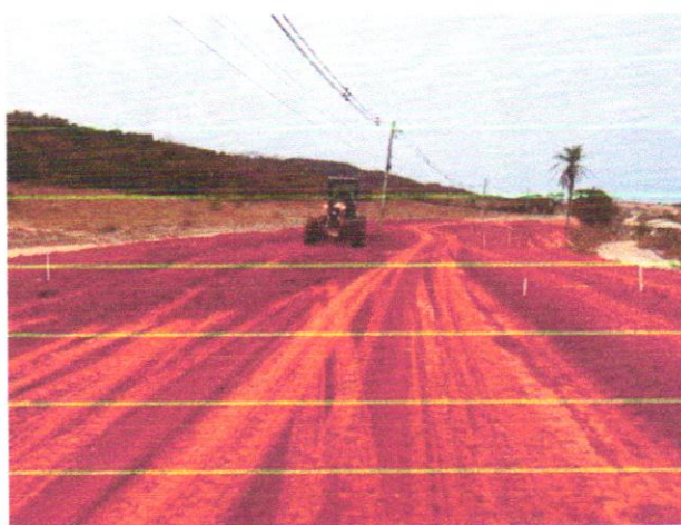
Foto 28 – Regularização e compactação de subleito.
