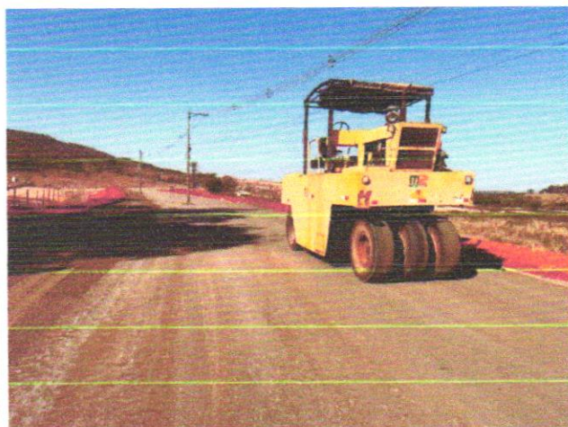
Foto 55 – Execução e compactação de sub-base.
