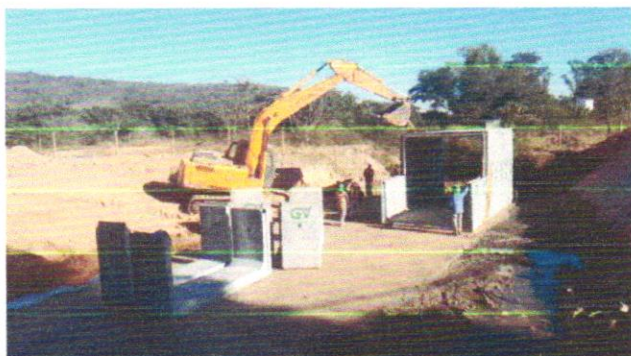
Foto 45 – Execução de bueiro duplo celular de concreto 3,00x3,00 m.
