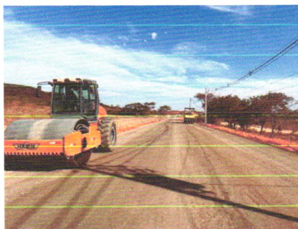
Foto 60 – Execução e compactação de base
