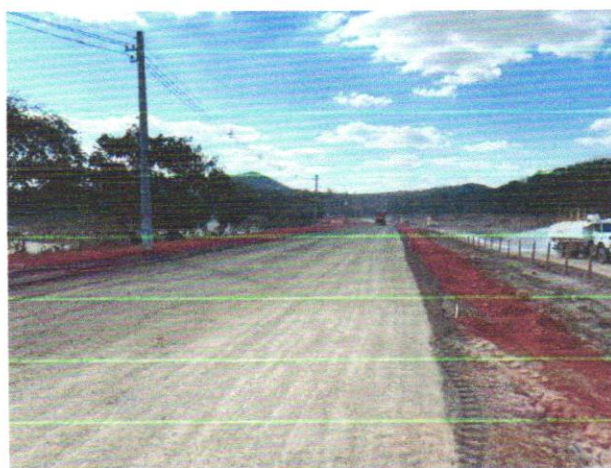
Foto 44 – Execução e compactação de sub-base.
