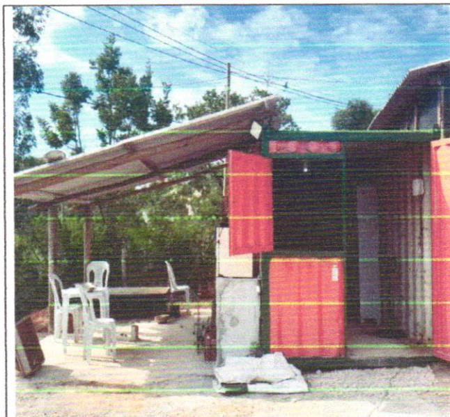
Foto 05 – Locação de Container.
