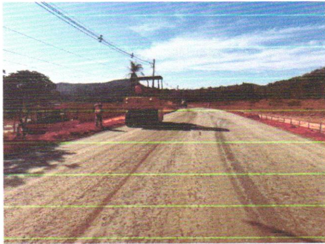
Foto 61 – Execução e compactação de base
