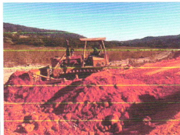
Foto 11 – Execução e compactação de aterro com solo predominantemente argiloso.
