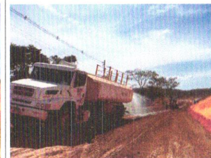
Foto 38 – Execução e compactação de sub- base.
