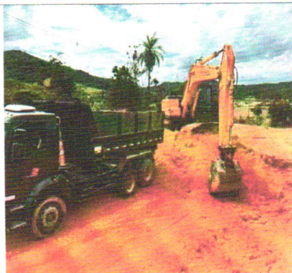
Foto 46 – Escavação vertical a céu aberto em solo de 1ª categoria.
