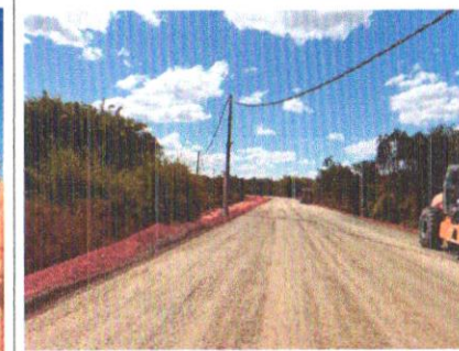
Foto 168 – Execução e compactação de base.
