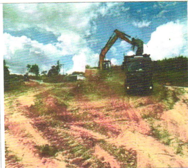
Foto 17 – Desmatamento, destocamento, limpeza de área.
