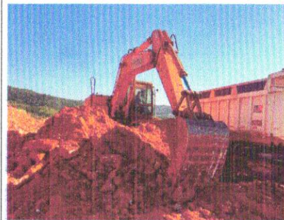
Foto 21 – Escavação, carga e transporte de material de 2ª categoria.
