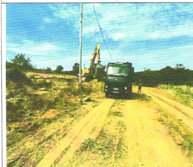
Foto 23 – Limpeza para bota fora.
