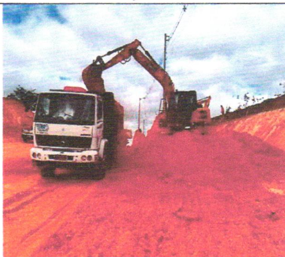
Foto 40 – Escavação vertical a céu aberto em material de 1ª categoria.
