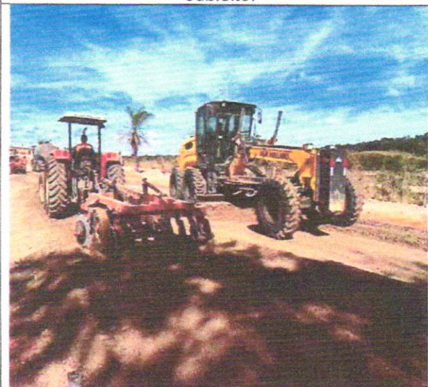
Foto 67 – Execução e compactação de sub-base.
