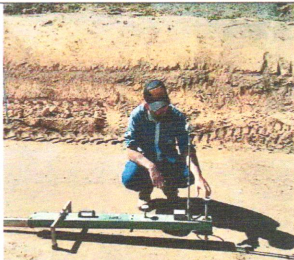
Foto 106 – Liberação camada de sub-base
