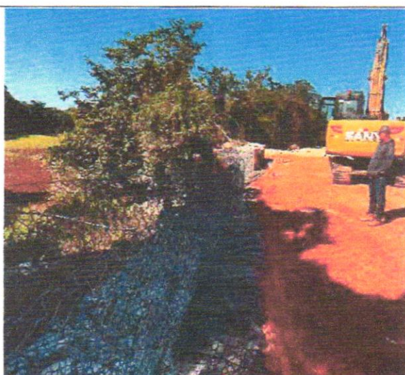
Foto 34 – Execução de arrimo em gabião tipo caixa.
