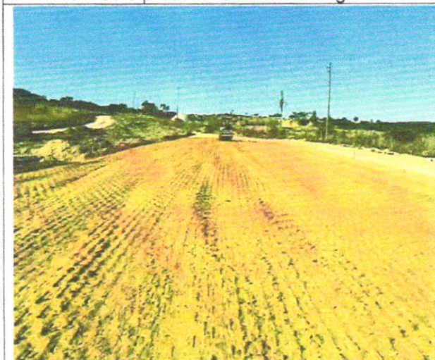
Foto 51 – Execução e compactação de aterro com solo predominantemente argiloso.
