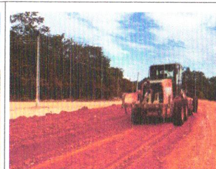
Foto 70 – Execução de camada final de aterro.
