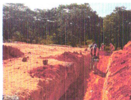
Foto 113 – Reaterro manual e compactação de vala.
