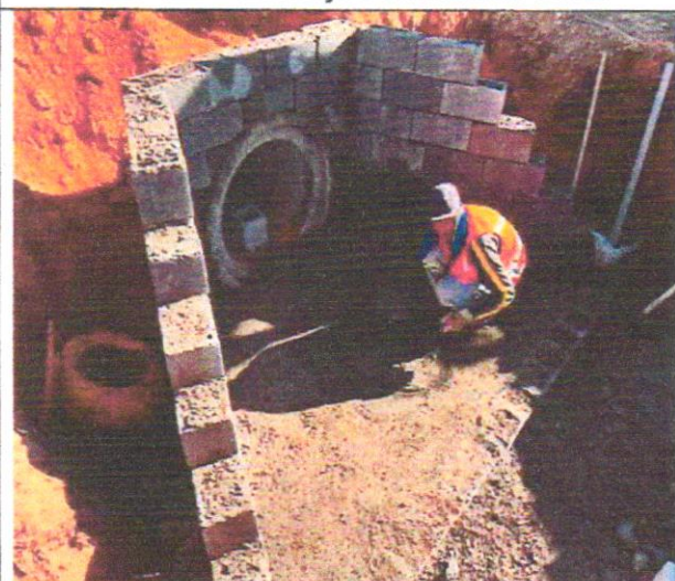
Foto 111 – Execução de ala.
