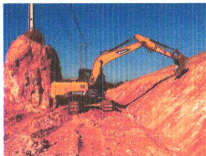
Foto 17 – Execução de rampa 1x1.
