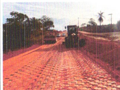
Foto 52 – Execução e compactação de aterro com solo predominantemente argiloso.
