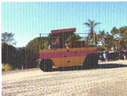
Foto 137 – Execução e compactação base.
