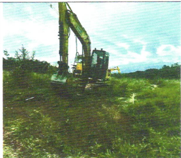
Foto 10 – Desmatamento, destocamento, limpeza de área.
