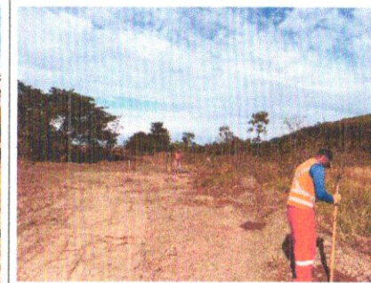
Foto 64 – Execução e remoção de cercas e mourões.
