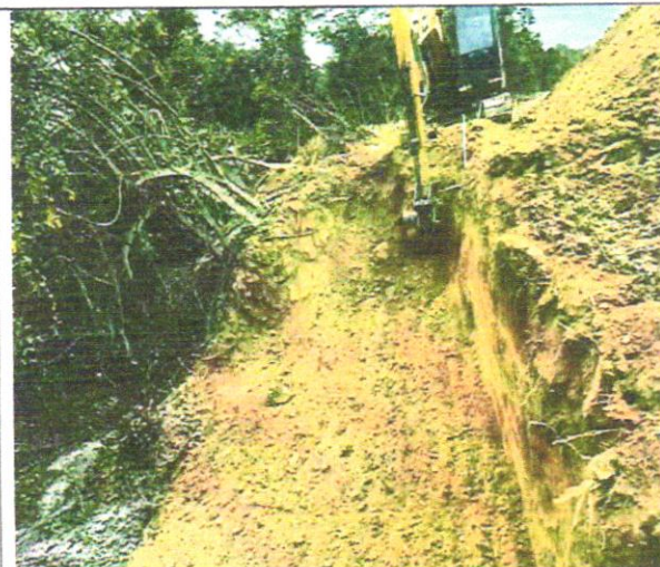
Foto 59 – Escalonamento para execução de gabião.
