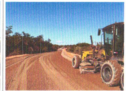
Foto 160 – Execução e compactação de base.
