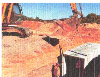
Foto 122 – Execução de Passa gado.
