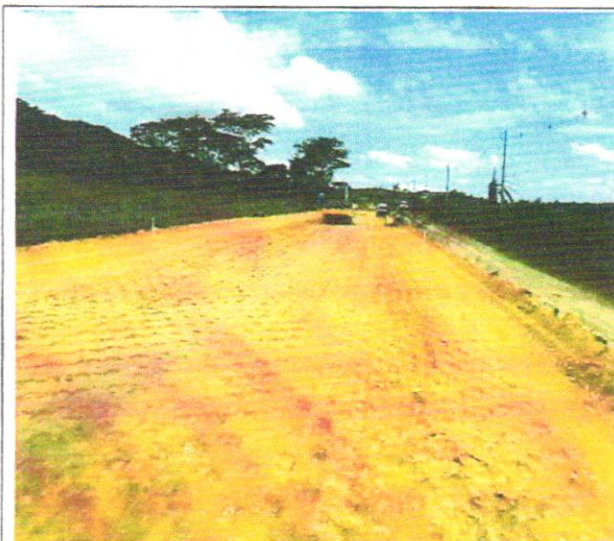
Foto 41 – Execução e compactação de aterro com solo predominantemente argiloso.
