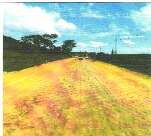
Foto 42 – Execução e compactação de aterro com solo predominantemente argiloso.
