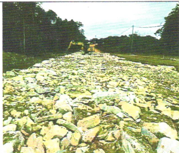
Foto 29 – Enrocamento com pedra de mão.
