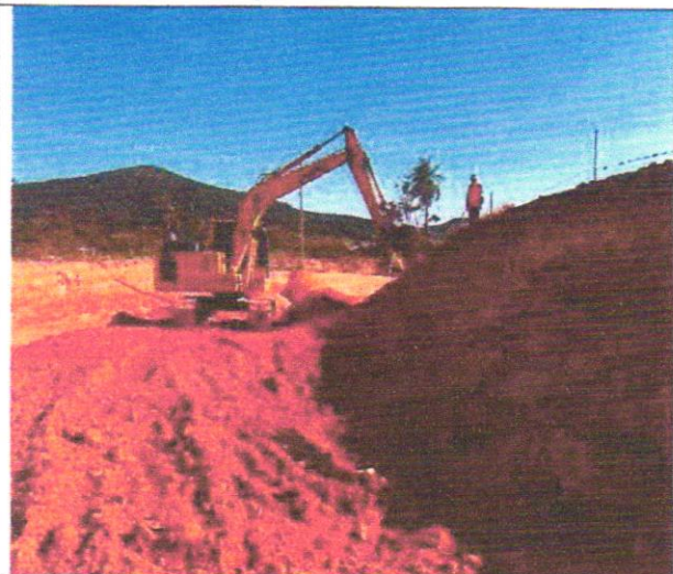
Foto 55 – Execução de rampa 1x1.
