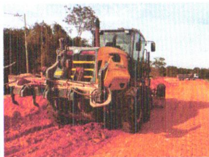
Foto 50 – Execução e compactação de aterro com solo predominantemente argiloso.
