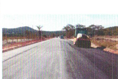
Foto 114 – Execução de pavimento com aplicação de concreto asfáltico. (Pista).
