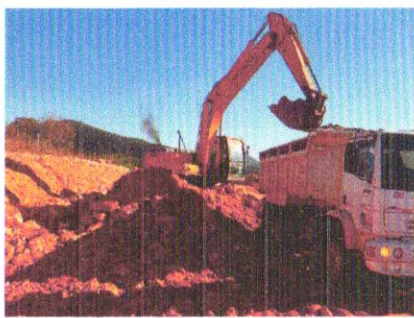
Foto 20 – Escavação, carga e transporte de material de 2ª categoria.
