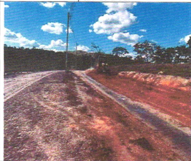
Foto 11 – Desmatamento, destocamento, limpeza de área.
