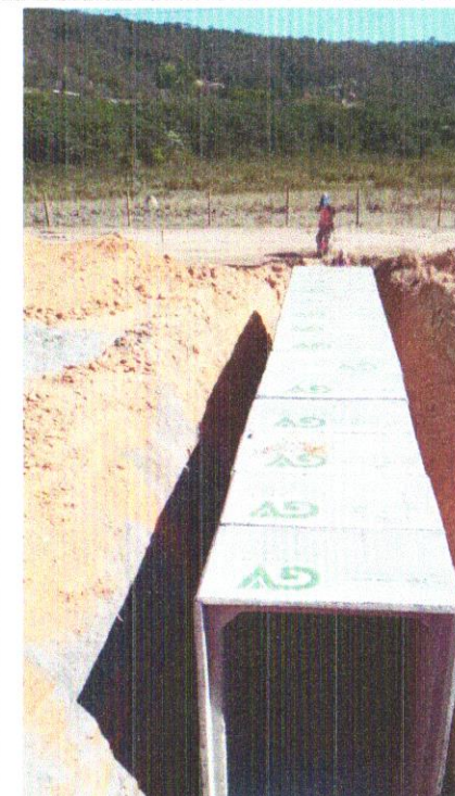
Foto 186 – Execução de Passa gado.
