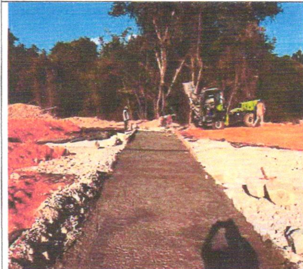
Foto 95 – Concreto para berço tubular.
