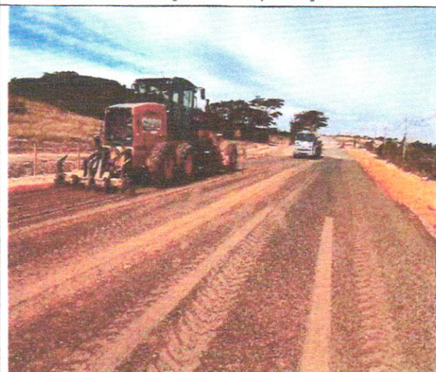
Foto 79 – Execução e compactação de base.
