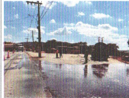
Foto 141 – Imprimação (Execução e Fornecimento do Material betuminoso).
