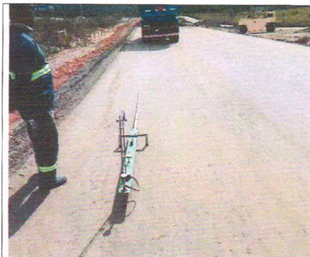
Foto 109 – Liberação camada de base.
