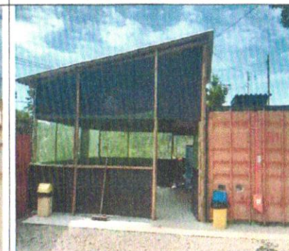
Foto 04 – Locação de Container
