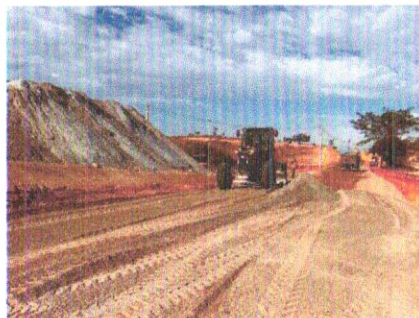
Foto 59 – Execução e compactação de base.
