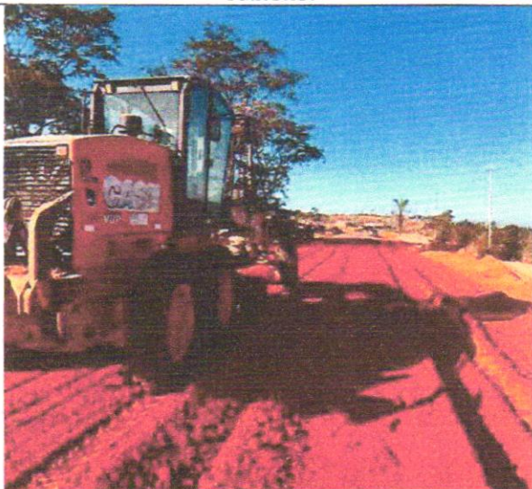
Foto 60 – Regularização e compactação de subleito.
