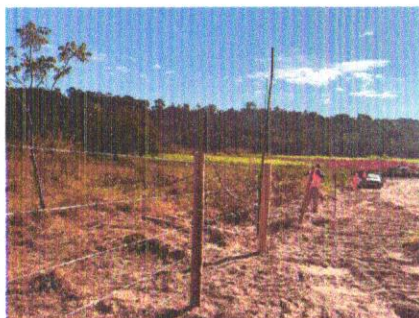
Foto 65 – Execução e remoção de cercas e mourões.
