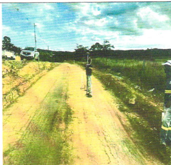
Foto 06 – Locação topográfica.
