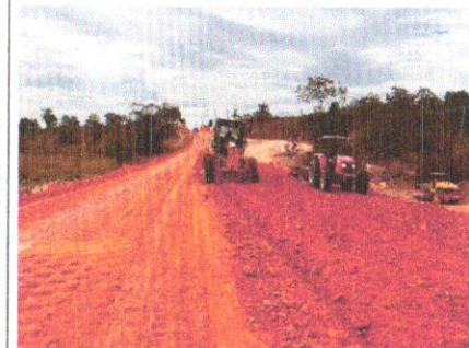
Foto 72 – Execução de camada final de aterro.
