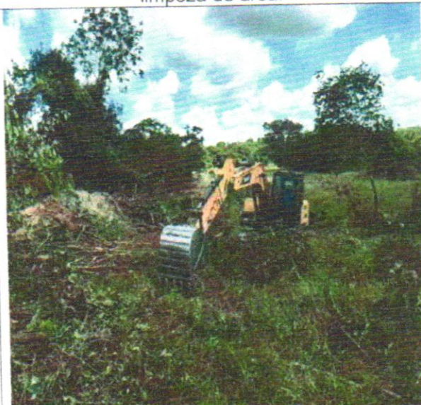
Foto 12 – Desmatamento, destocamento, limpeza de área.
