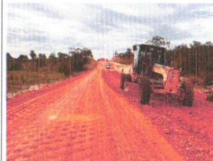
Foto 71 – Execução de camada final de aterro.
