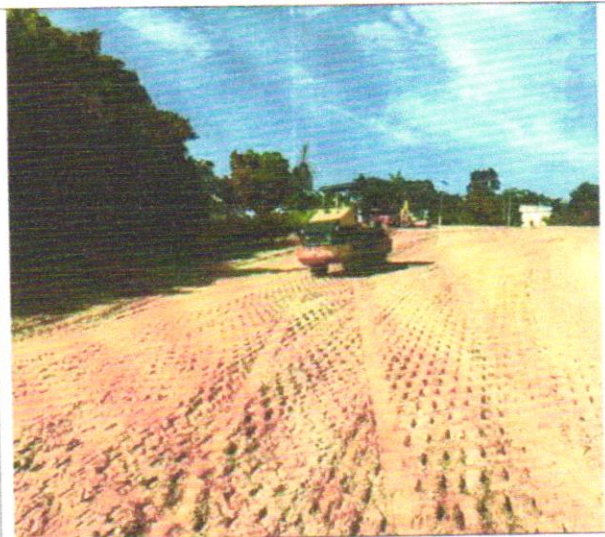
Foto 53 – Execução e compactação de aterro com solo predominantemente argiloso.
