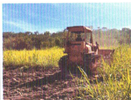
Foto 33 – Desmatamento, destocamento, limpeza de área.
