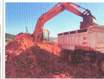
Foto 22 – Escavação, carga e transporte de material de 2ª categoria.
