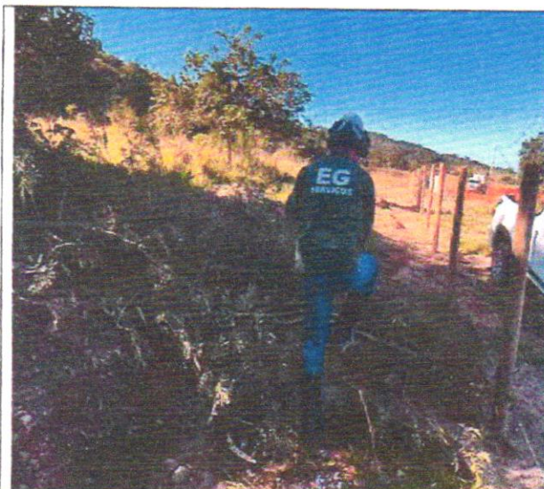
Foto 09 – Desmatamento, destocamento, limpeza de área.
