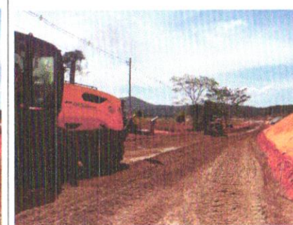
Foto 40 – Execução e compactação de sub- base.
