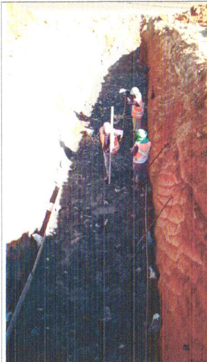
Foto 153 – Lastro de concreto para execução de passa gado
