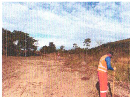
Foto 66 – Execução e remoção de cercas e mourões.
