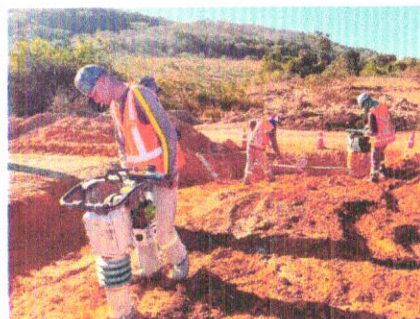
Foto 183 – Reaterro manual e compactação de vala.
