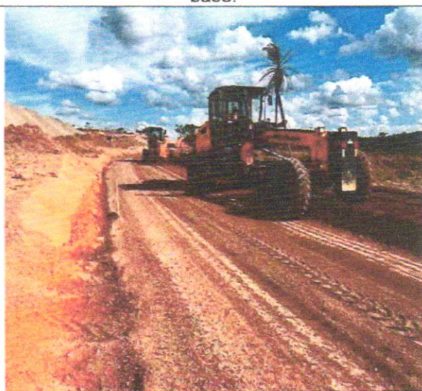
Foto 76 – Execução e compactação de base.
