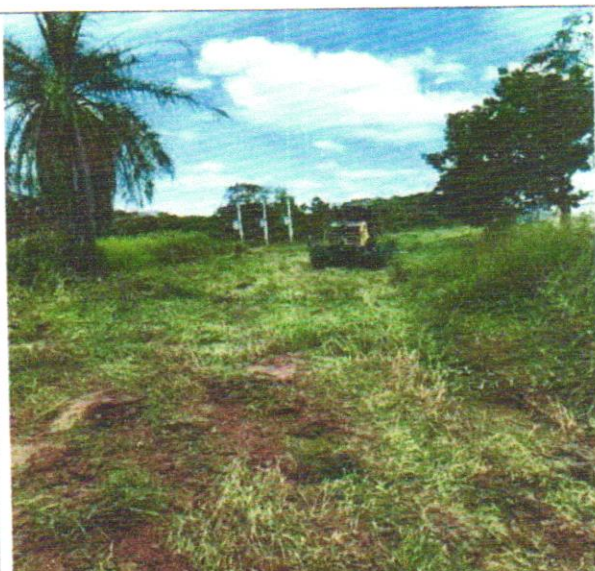
Foto 10 – Desmatamento, destocamento, limpeza de área.
