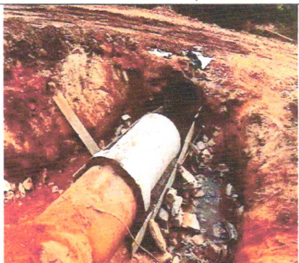
Foto 100 – Prolongamento de rede tubo DN 800 mm.
