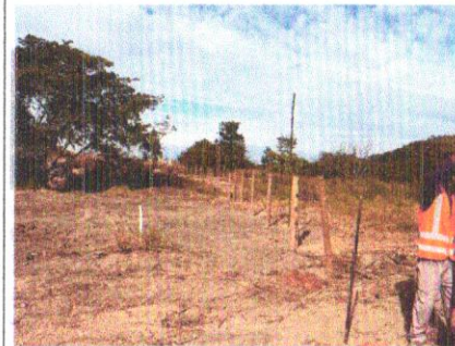
Foto 63 – Execução e remoção de cercas e mourões.
