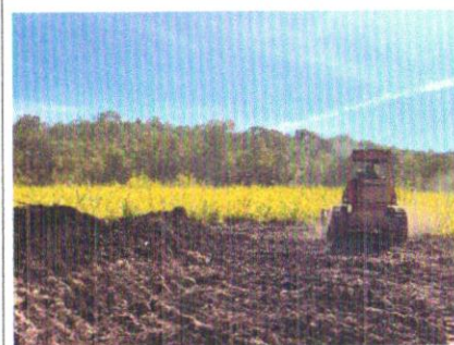
Foto 36 – Desmatamento, destocamento, limpeza de área.
