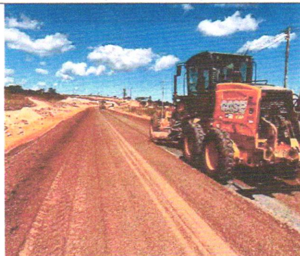
Foto 71 – Execução e compactação de sub-base.
