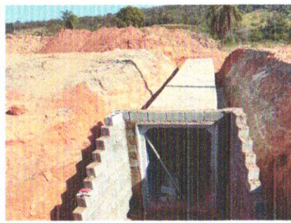
Foto 140 – Execução Ala para passa gado.
