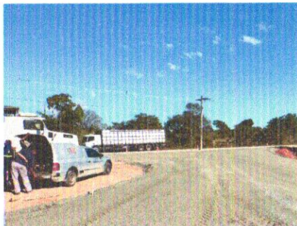
Foto 139 – Execução e compactação base.
