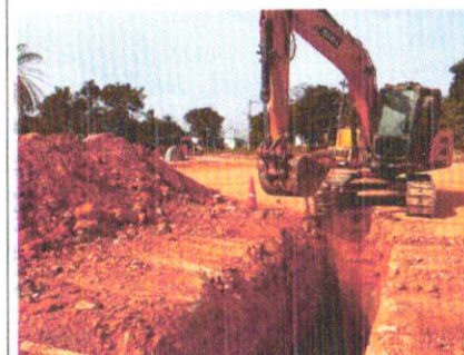
Foto 55 – Escavação para execução de rede de tubo de concreto DN 800 mm.
