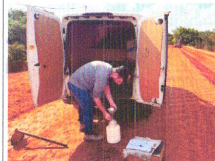
Foto 95 – Liberação camada de subleito.
