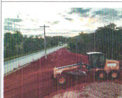
Foto 119 – Execução e compactação de subleito.
