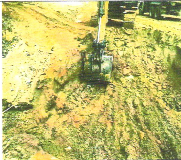
Foto 30 – Escavação mecânica em solo mole.
