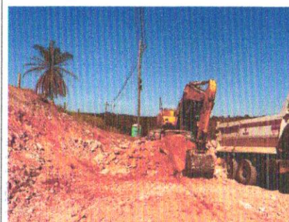
Foto 125 – Escavação, carga e transporte de material de 2ª categoria para botafora.
