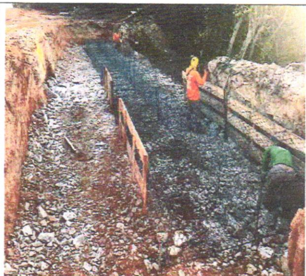
Foto 30 – Execução de arrimo em gabião tipo caixa.
