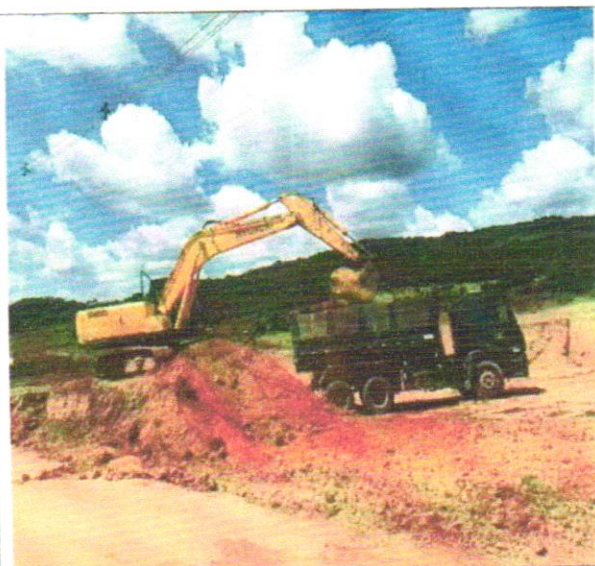
Foto 42 – Escavação vertical a céu aberto em solo de 1ª categoria.
