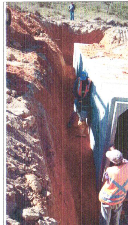
Foto 185 – Execução de Passa gado.
