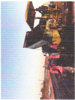
Foto 101 -- Execução de pavimento com aplicação de concreto asfáltico. (Pista de Caminhada).
