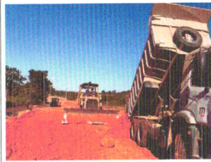
Foto 164 – Execução de camada final de aterro.
