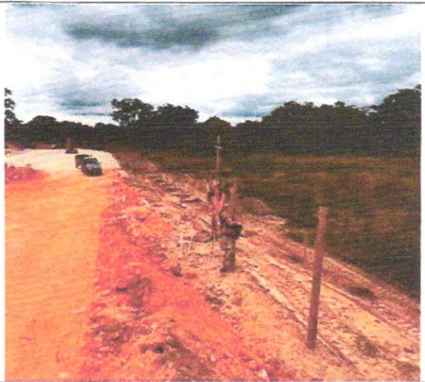
Foto 20 – Remoção de cercas e mourões.
