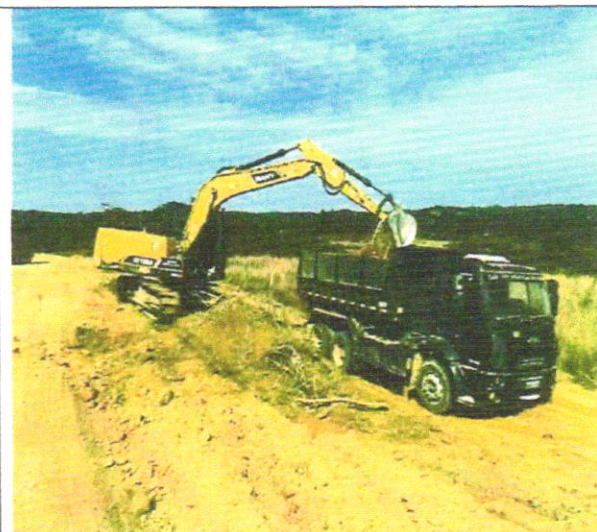
Foto 24 – Limpeza para bota fora.
