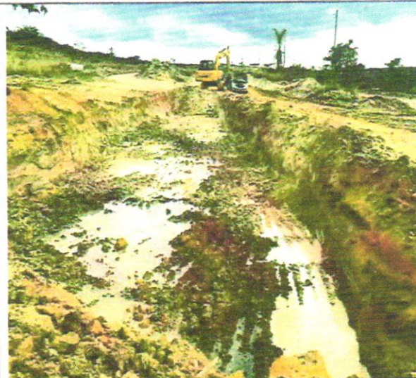
Foto 32 – Escavação mecânica em solo mole.
