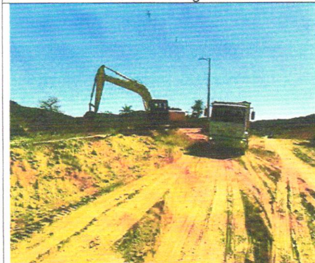
Foto 39 – Escavação vertical a céu aberto em solo de 1ª categoria.
