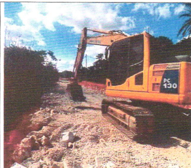
Foto 37 – Transição de enrocamento.
