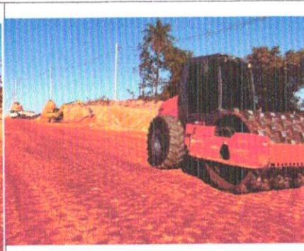
Foto 10 – Regularização e compactação de subleito.
