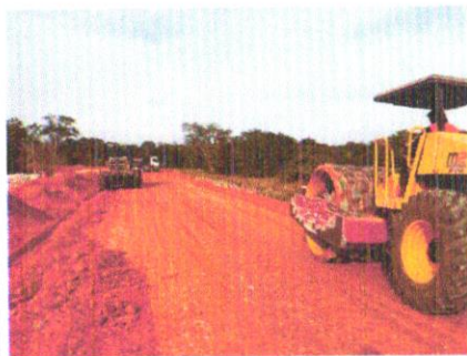
Foto 49 – Execução e compactação de aterro com solo predominantemente argiloso.
