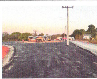
Foto 146 – Salgamento de Via
