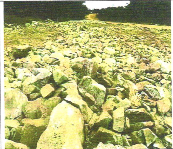
Foto 28 – Enrocamento com pedra de mão.
