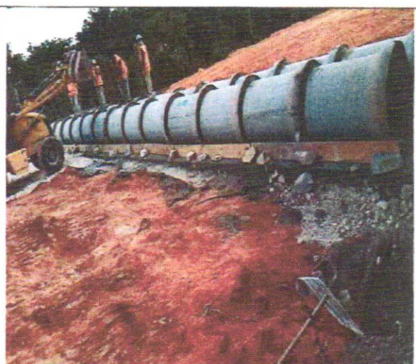
Foto 98 – Tubo de concreto duplo DN 800 mm.
