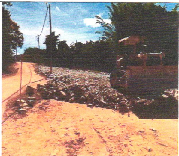
Foto 26 – Enrocamento com pedra de mão.
