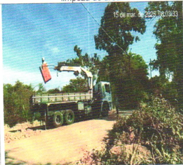
Foto 20 – Corte raso e recorte de árvore
