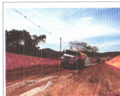
Foto 37 – Execução e compactação de sub- base.
