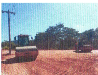
Foto 124 – Execução e compactação de subleito.
