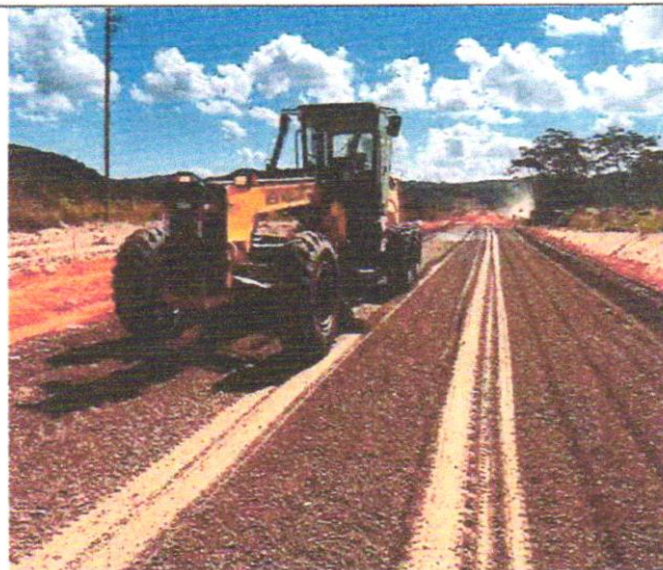
Foto 72 – Execução e compactação de sub-base.
