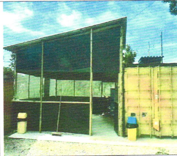
Foto 04 – Locação de Container
