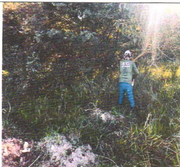
Foto 10 – Desmatamento, destocamento, limpeza de área.
