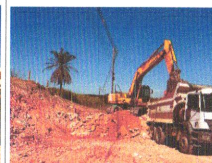
Foto 126 – Escavação, carga e transporte de material de 2ª categoria para botafora.
