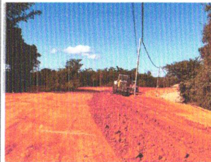
Foto 23 – Execução de camada final de aterro.
