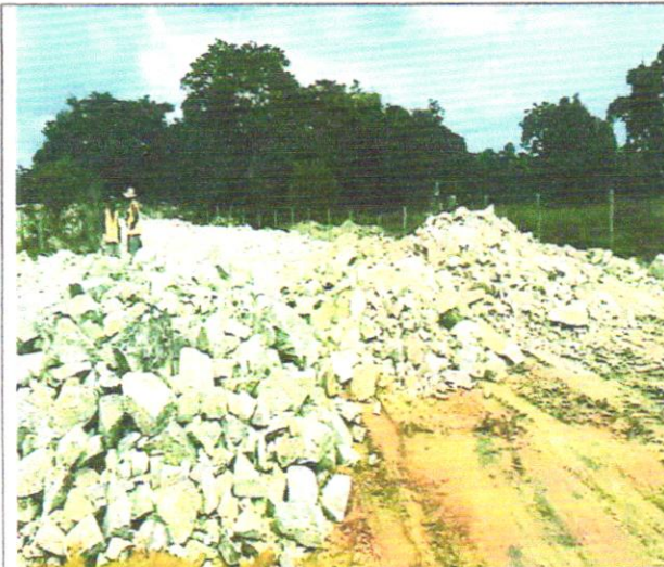
Foto 25 – Enrocamento com pedra de mão.
