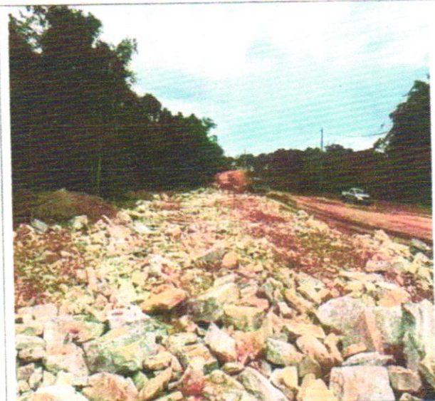
Foto 40 – Enrocamento com pedra de mão.
