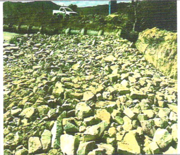
Foto 26 – Enrocamento com pedra de mão.
