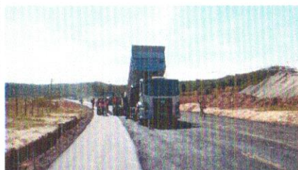
Foto 115 – Execução de pavimento com aplicação de concreto asfáltico. (Pista).
