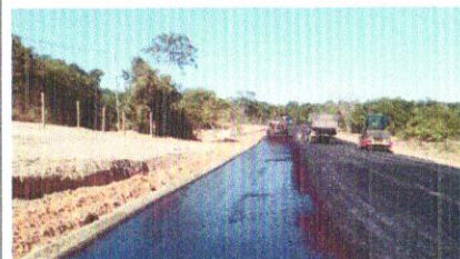
Foto 184 – Imprimação (Execução e Fornecimento do Material betuminoso) e Imprimação de via.
