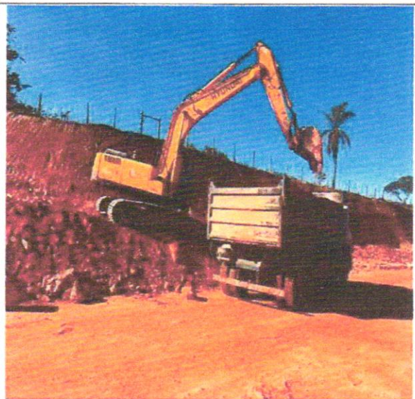
Foto 42 – Escavação, carga e transporte de material de 2ª categoria.
