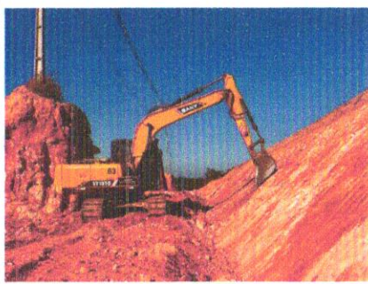
Foto 18 – Execução de rampa 1x1.
