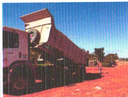
Foto 163 – Execução de camada final de aterro.
