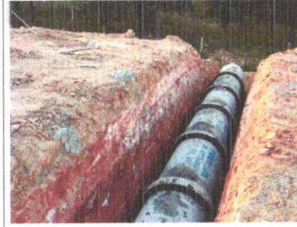
Foto 77 – Tubo de concreto DN 800 mm.
