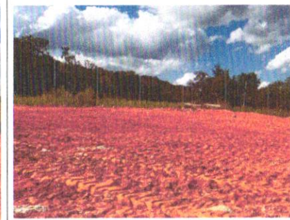
Foto 80 – Execução e compactação de aterro.
