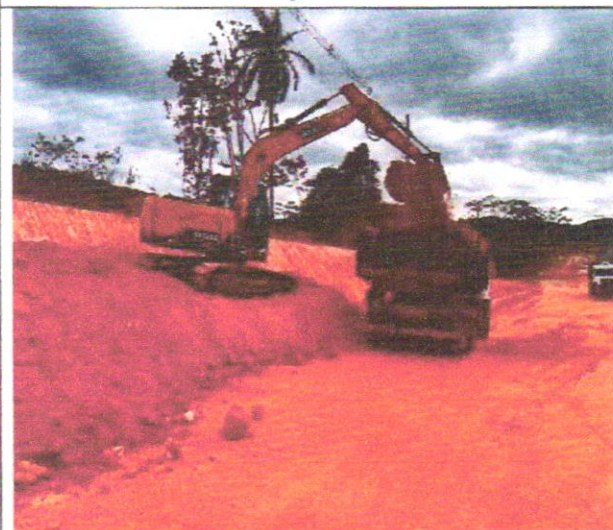
Foto 39 – Escavação vertical a céu aberto em material de 1ª categoria.
