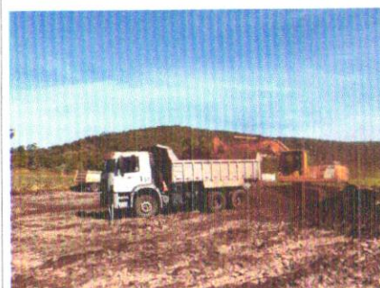
Foto 35 – Desmatamento, destocamento, limpeza de área.
