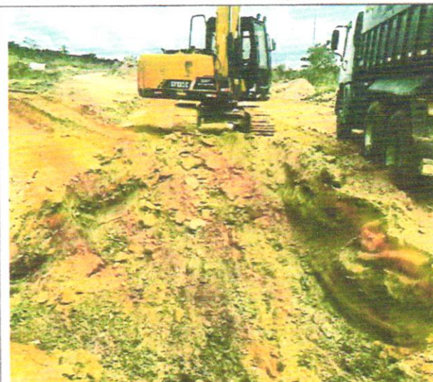
Foto 31 – Escavação mecânica em solo mole.
