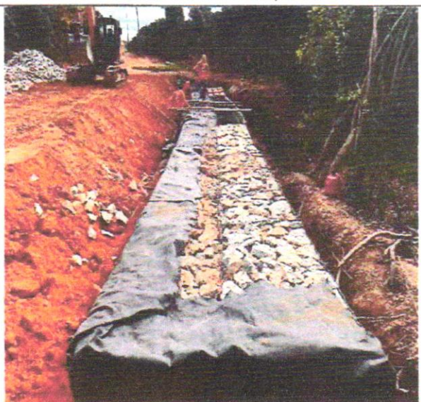
Foto 28 – Execução de arrimo em gabião tipo caixa.
