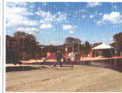
Foto 142 - Imprimação (Execução e Fornecimento do Material betuminoso).
