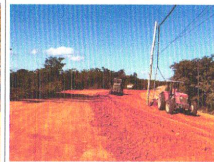
Foto 24 – Execução de camada final de aterro..
