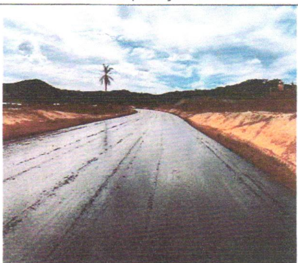
Foto 84 – Imprimação asfáltica.
