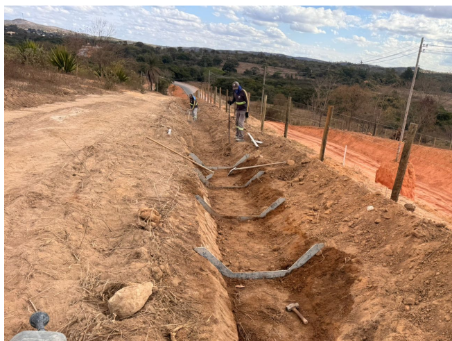
Foto 23 – Execução de VPC.
