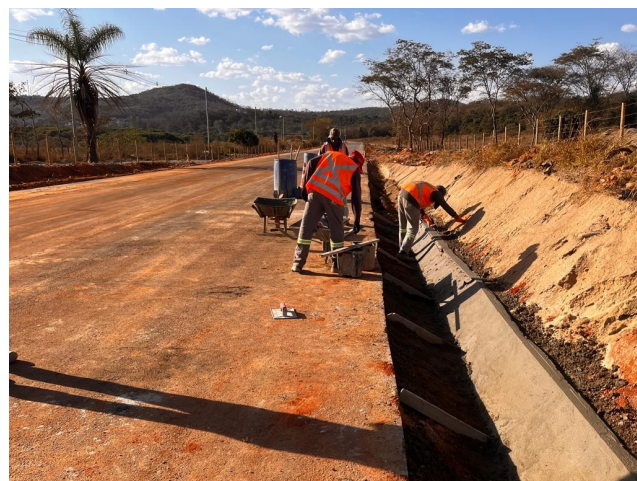
Foto 10 - Execução de Sarjeta triangular de concreto (STC-02).
