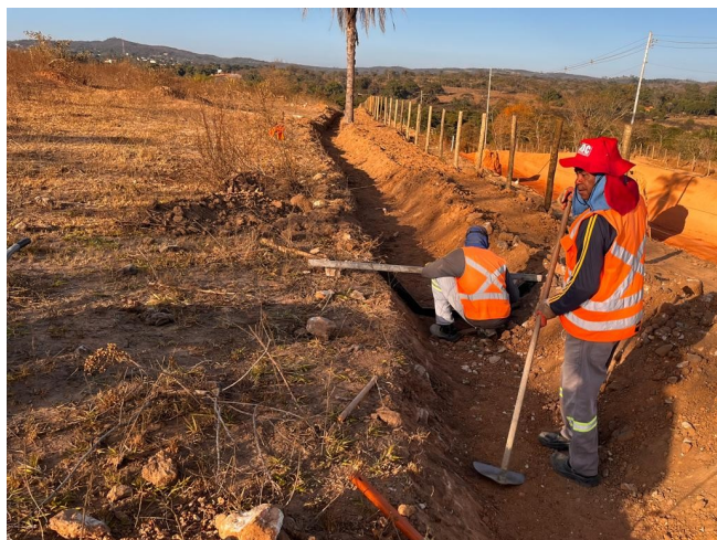
Foto 17 – Execução de VPC.
