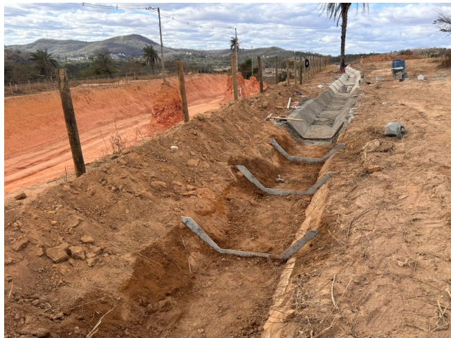
Foto 21 – Execução de VPC.
