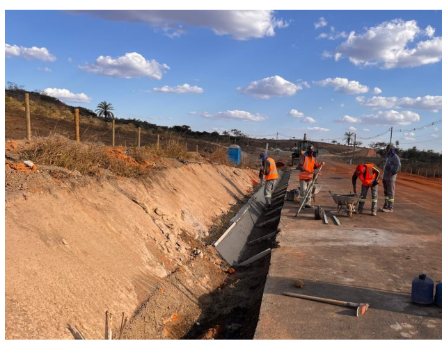
Foto 08 – Execução de Sarjeta triangular de concreto (STC-02).
