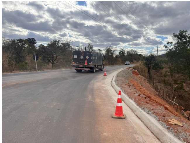
Foto 25 – Execução de sarjeta e Guia.
