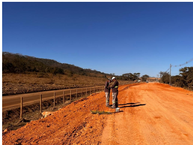
Foto 06 – Locação topográfica..
