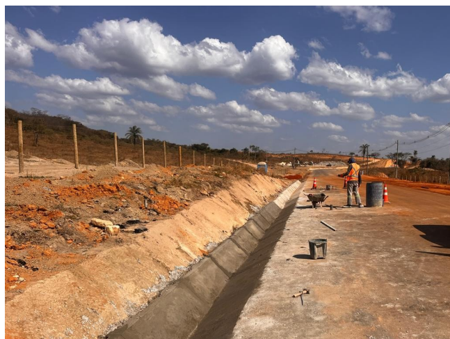
Foto 11 - Execução de Sarjeta triangular de concreto (STC-02).
