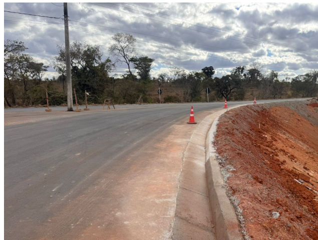
Foto 26 – Execução de sarjeta e Guia
