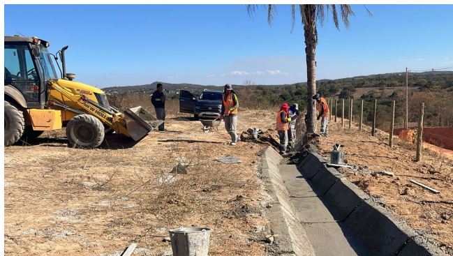
Foto 19 – Execução de VPC.
