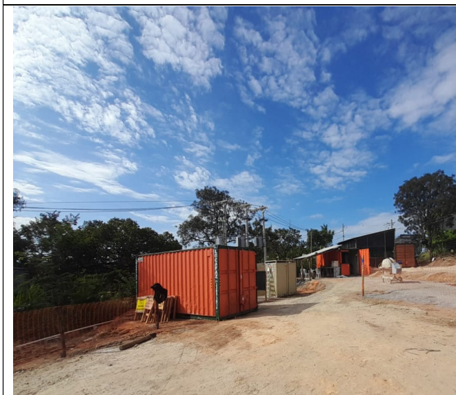
Foto 03 – Locação de Container.
