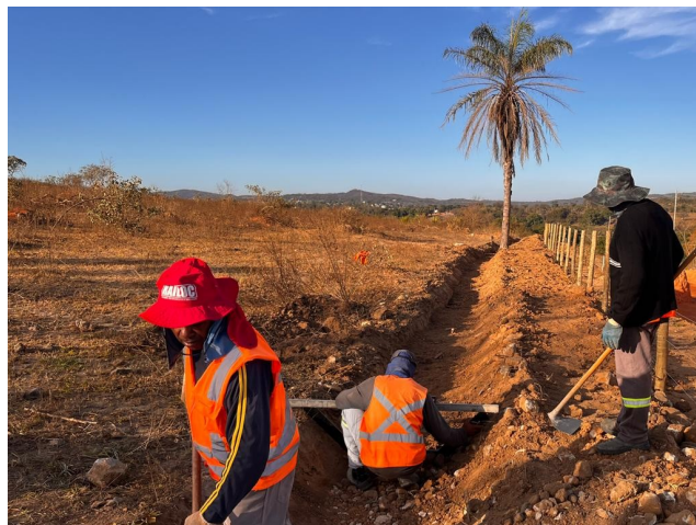
Foto 18 – Execução de VPC.
