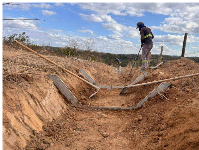
Foto 24 – Execução de VPC.
