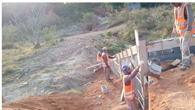
Foto 31 – Execução de Ala Passa Gado 3,00 x 3,00 m.
