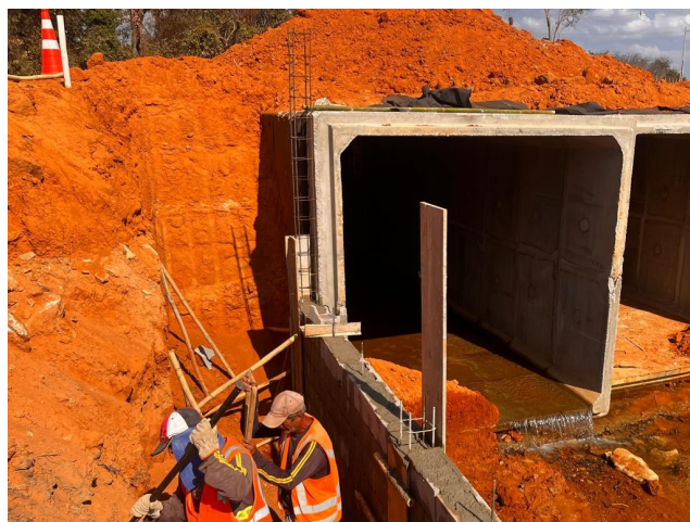
Foto 28 – Execução de Ala Passa Gado 3,00 x 3,00 m.
