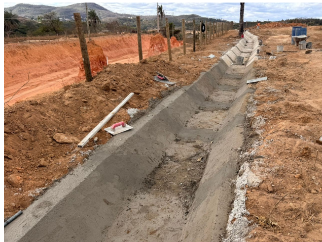
Foto 22 – Execução de VPC.
