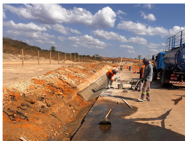
Foto 12 - Execução de Sarjeta triangular de concreto (STC-02).
