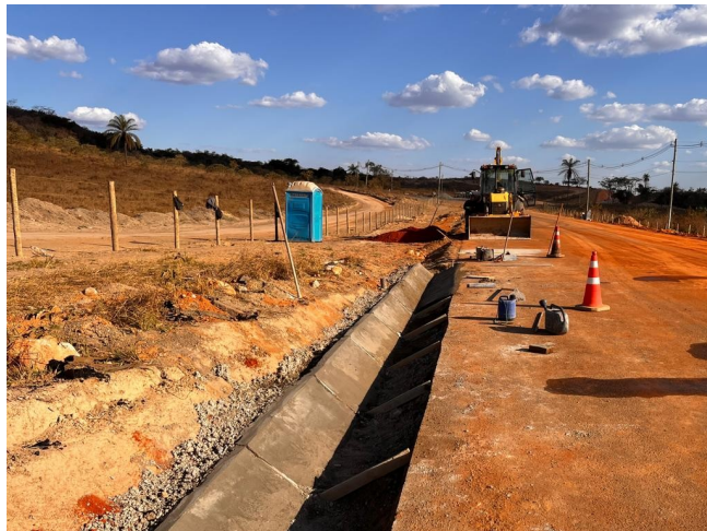
Foto 09 - Execução de Sarjeta triangular de concreto (STC-02).
