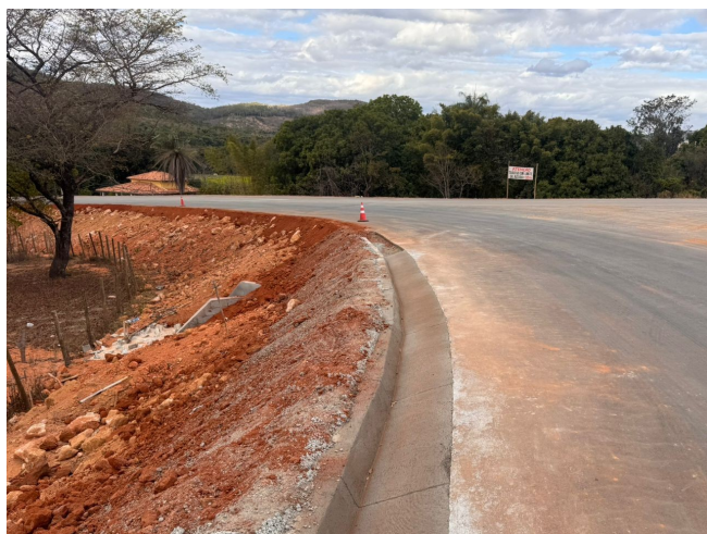
Foto 27- Execução de sarjeta e Guia.
