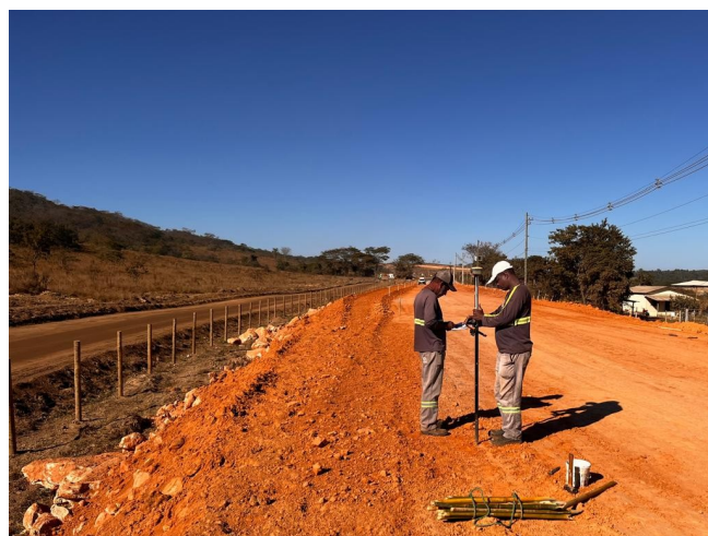
Foto 07 – Locação topográfica.
