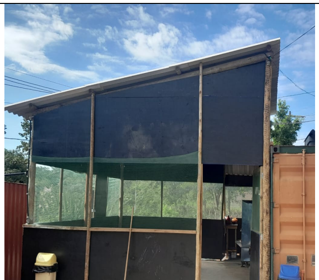
Foto 04 – Locação de Container.
