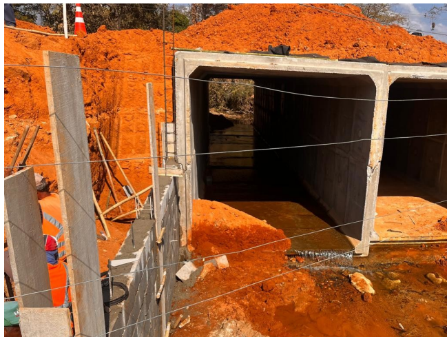
Foto 29 – Execução de Ala Passa Gado 3,00 x 3,00 m.
