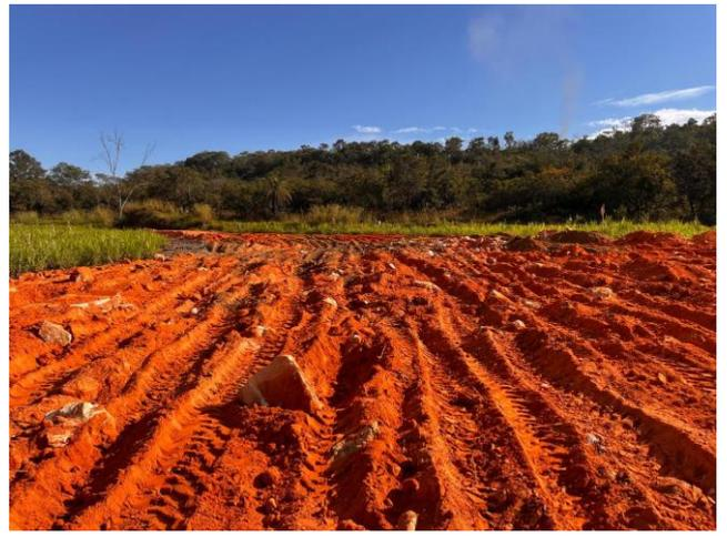
Foto 62 – Execução e compactação de aterro.
