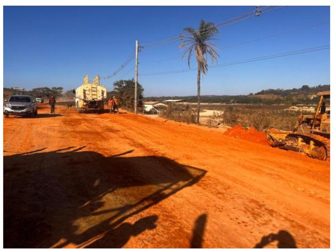
Foto 12 – Execução e compactação de aterro com solo predominantemente argiloso.
