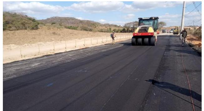
Foto 77 – Execução de pavimento com aplicação de concreto asfáltico.
