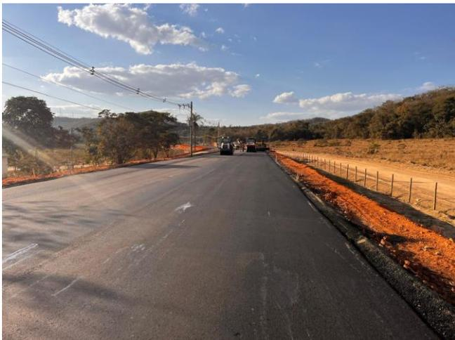
Foto 82 – Execução de pavimento com aplicação de concreto asfáltico.
