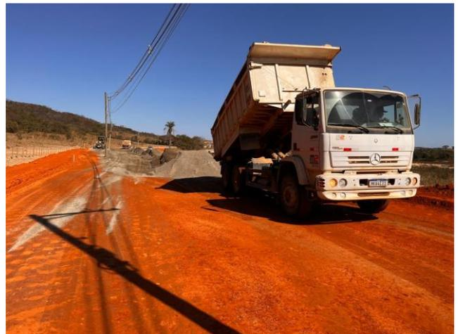
Foto 79 – Execução e compactação de sub-base.
