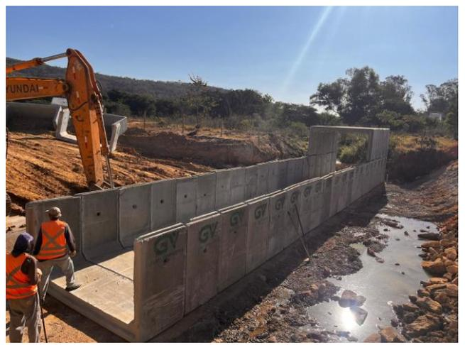
Foto 48 – Execução de bueiro duplo celular de concreto 3,00x3,00 m.
