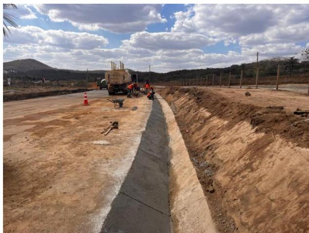
Foto 75 – Execução de Sarjeta triangular de concreto (STC-02).
