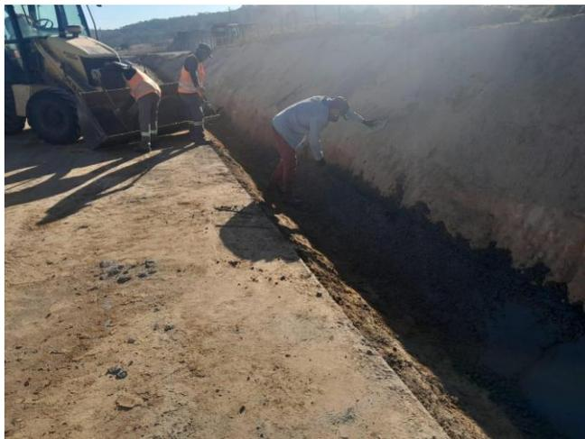
Foto 35 – Execução de Sarjeta triangular de concreto (STC-02).
