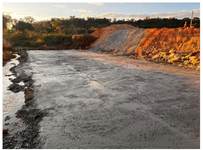
Foto 20 – Concretagem de Berço para bueiro duplo celular de concreto 3,00x3,00 m.
