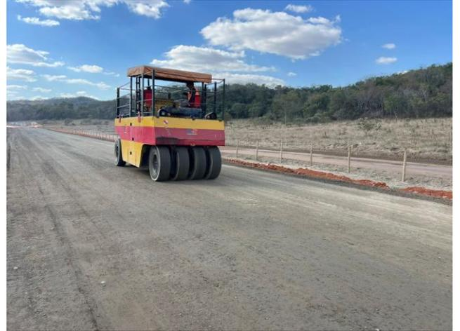
Foto 42 – Execução e compactação de sub-base.
