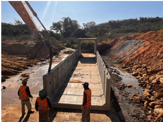
Foto 47 – Execução de bueiro duplo celular de concreto 3,00x3,00 m.
