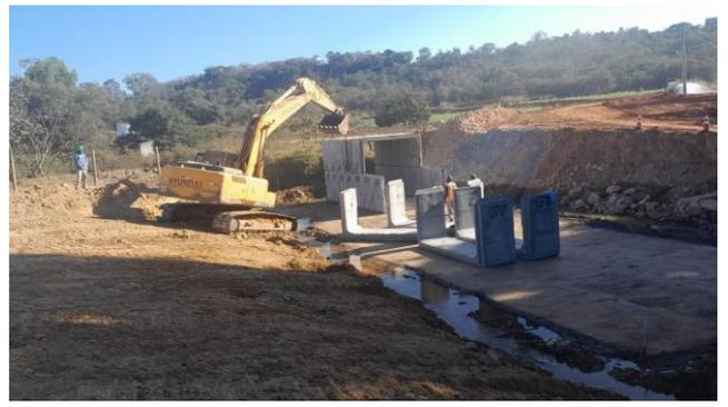
Foto 46 – Execução de bueiro duplo celular de concreto 3,00x3,00 m.
