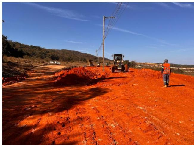
Foto 51 – Execução e compactação de aterro com solo predominantemente argiloso.
