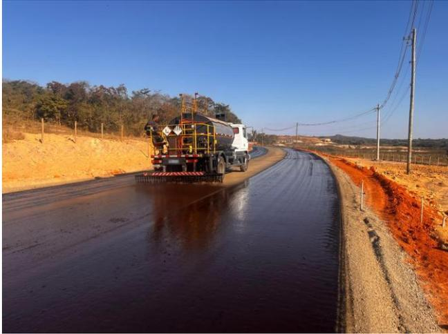
Foto 84 – Imprimação (Execução e Fornecimento do Material betuminoso).
