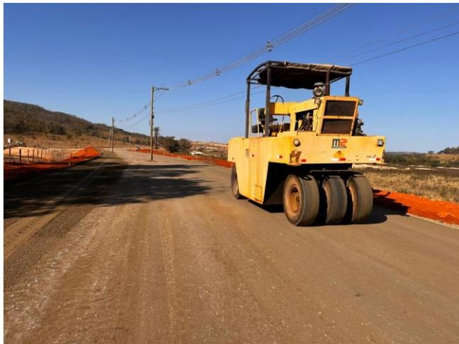
Foto 55 – Execução e compactação de sub-base.
