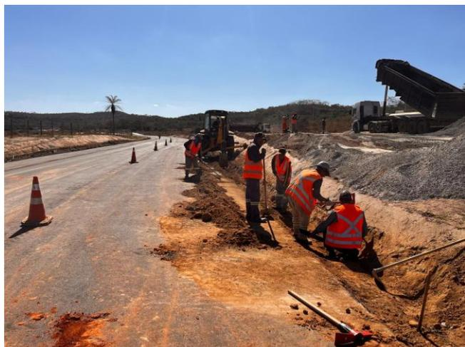
Foto 09 - Execução de Sarjeta triangular de concreto (STC-02).
