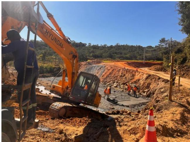
Foto 19 – Concretagem de Berço para bueiro duplo celular de concreto 3,00x3,00 m.
