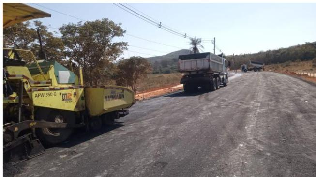
Foto 73 – Execução de pavimento com aplicação de concreto asfáltico.
