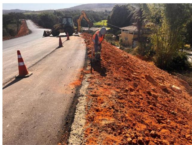
Foto 40 – Acabamento e Acerto Talude, Estaca 00 a 30.
