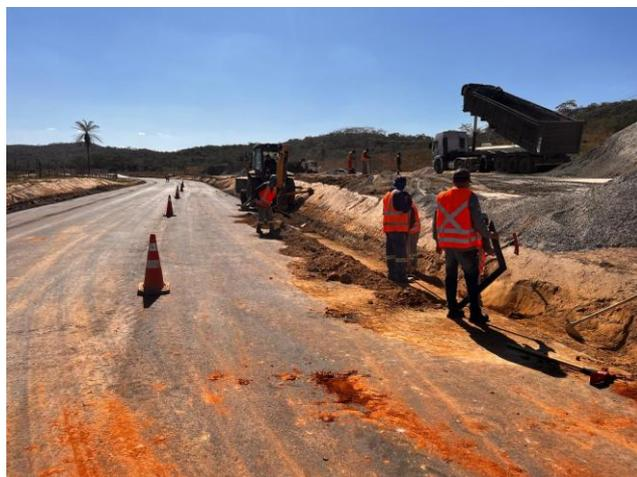
Foto 08 – Execução de Sarjeta triangular de concreto (STC-02).
