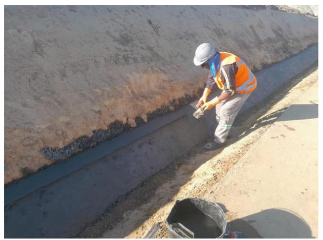
Foto 36 – Execução de Sarjeta triangular de concreto (STC-02).
