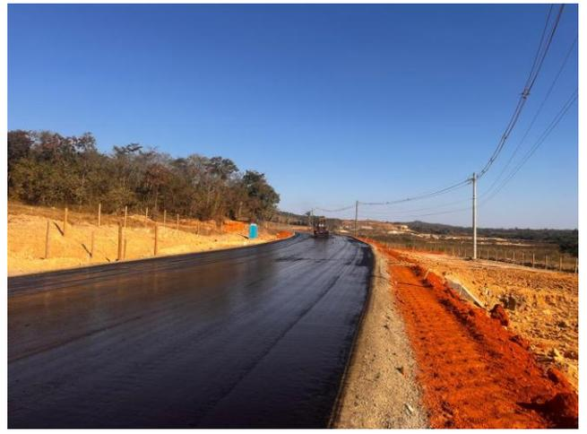
Foto 85 - Imprimação (Execução e Fornecimento do Material betuminoso).
