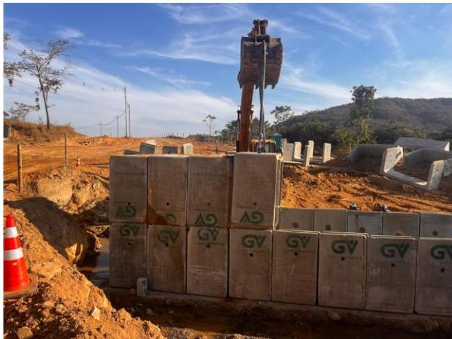
Foto 59 – Execução de bueiro duplo celular de concreto 3,00x3,00 m.
