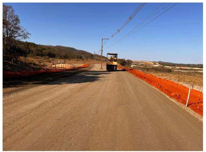
Foto 56 – Execução e compactação de sub-base.
