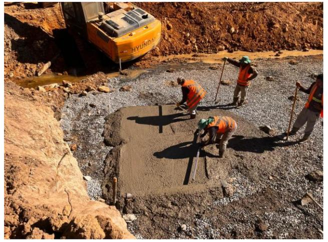
Foto 18 – Concretagem de Berço para bueiro duplo celular de concreto 3,00x3,00 m.
