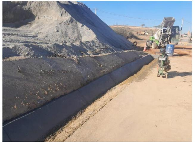
Foto 34 – Execução de Sarjeta triangular de concreto (STC-02).
