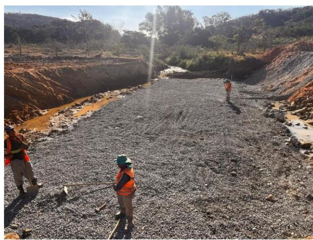
Foto 52 – Execução de Enrocamento para execução de berço. Estaca 127+10.
