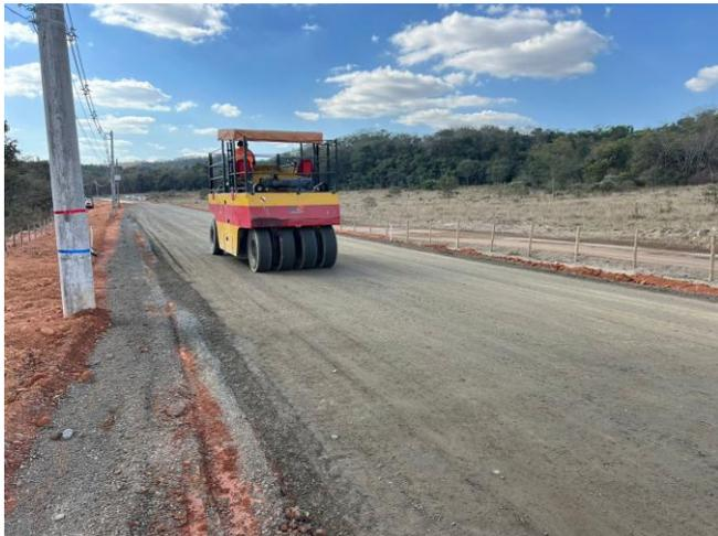
Foto 43 - Execução e compactação de sub-base.
