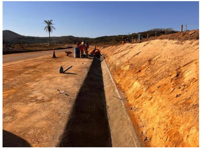
Foto 54 – Execução de Sarjeta triangular de concreto (STC-02).
