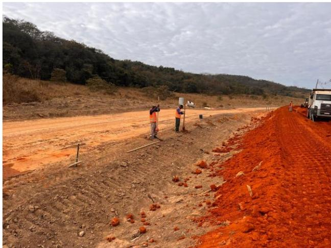
Foto 63 – Execução e remoção de cercas e mourões.
