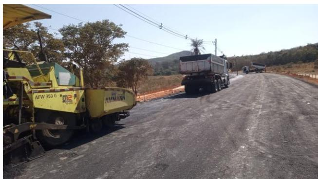
Foto 74 – Execução de pavimento com aplicação de concreto asfáltico.
