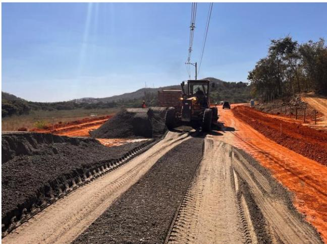
Foto 78 – Execução e compactação de sub-base.
