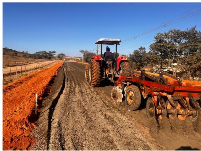
Foto 38 – Execução e compactação de sub-base.
