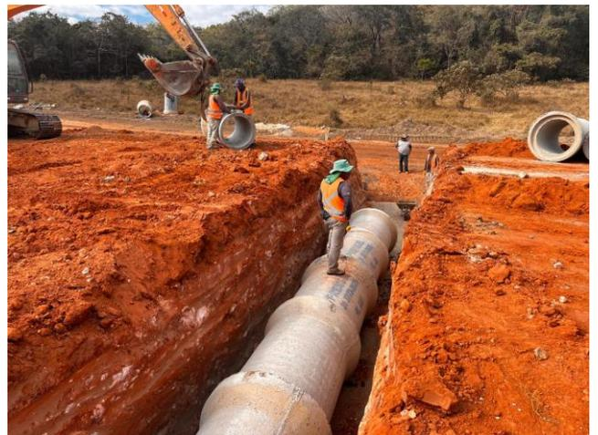
Foto 24 – Execução de rede de tubo de concreto DN 800 mm.
