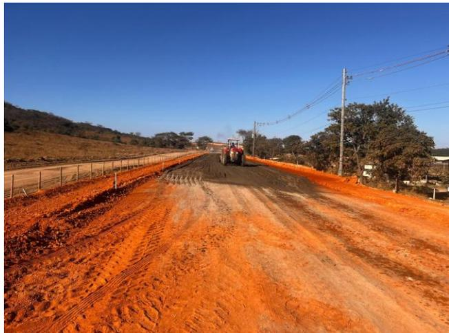
Foto 37 – Execução e compactação de sub-base.
