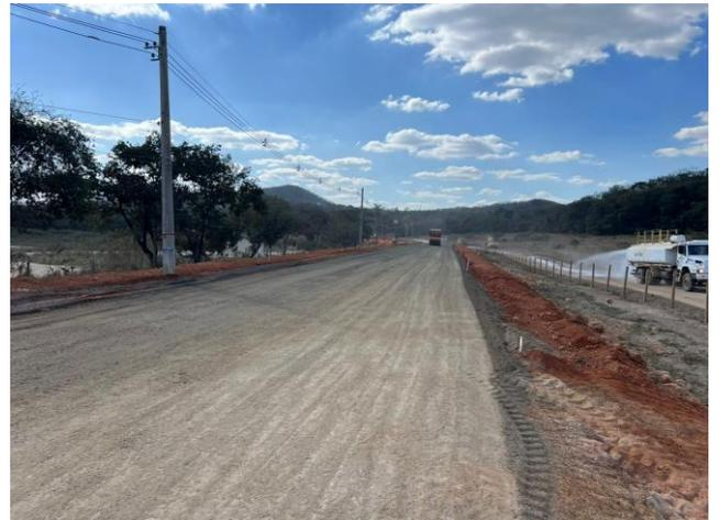
Foto 44 – Execução e compactação de sub-base.
