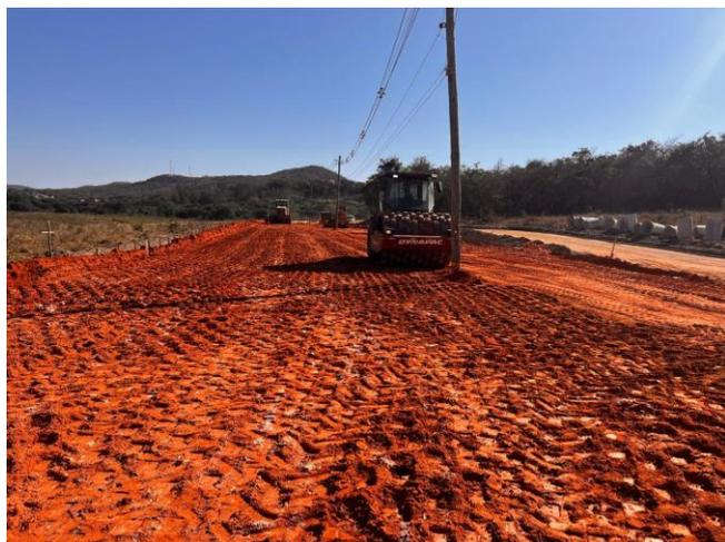
Foto 49 – Execução e compactação de aterro com solo predominantemente argiloso.
