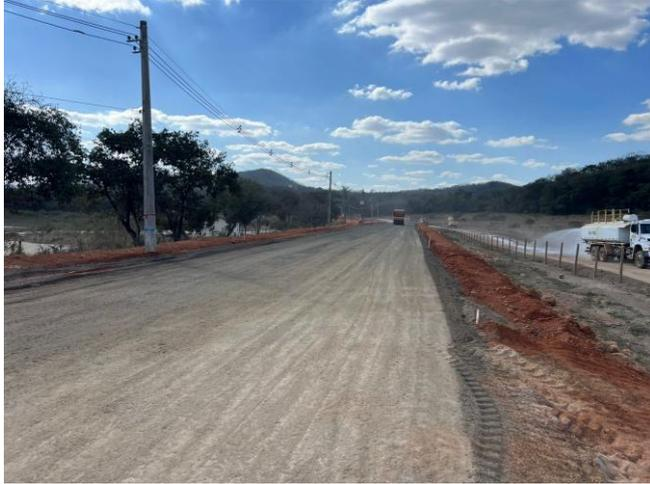
Foto 41 – Execução e compactação de sub-base.
