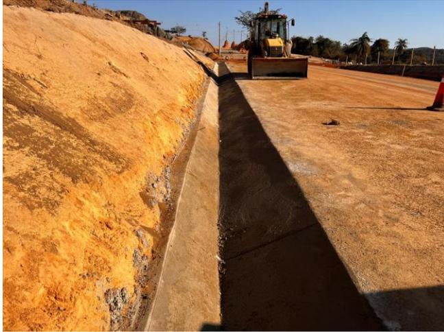
Foto 53 – Execução de Sarjeta triangular de concreto (STC-02).
