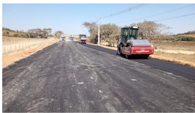
Foto 73 – Execução de pavimento com aplicação de concreto asfáltico.
