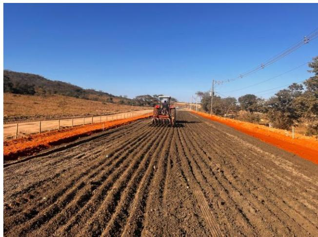
Foto 39 – Execução e compactação de sub-base.
