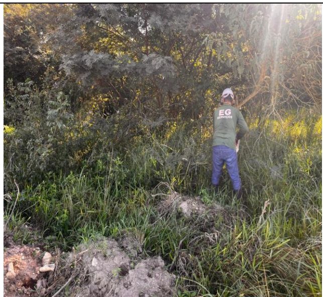
Foto 10 – Desmatamento, destocamento, limpeza de área.
