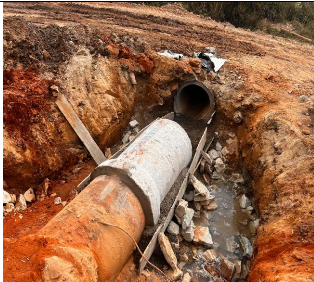
Foto 100 – Prolongamento de rede tubo DN 800 mm.
