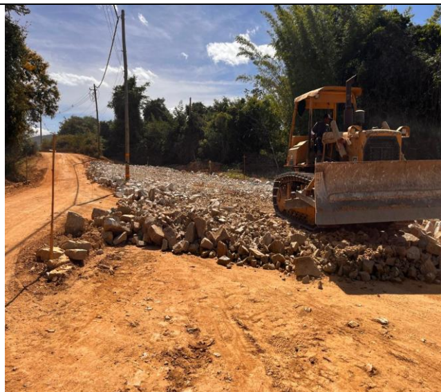
Foto 26 – Enrocamento com pedra de mão.
