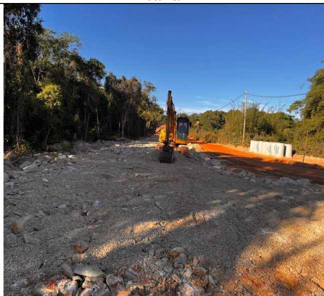
Foto 35 – Transição de enrocamento.
