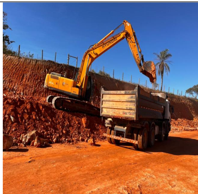
Foto 42 – Escavação, carga e transporte de material de 2ª categoria.
