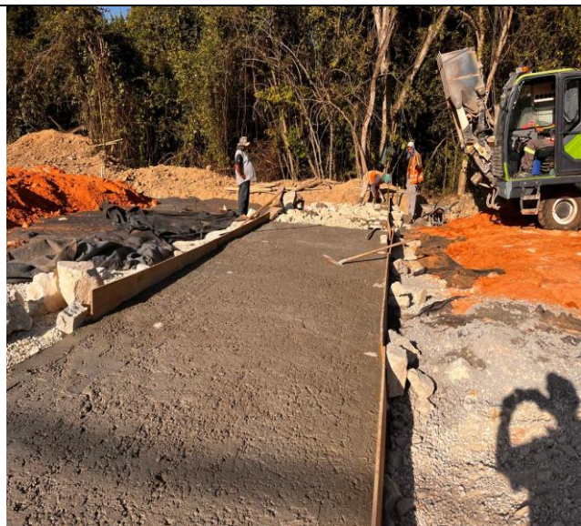
Foto 94 – Forma e concreto para berço tubular.
