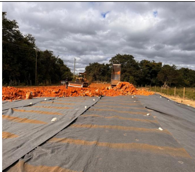
Foto 87 – Instalação de manta bidim na camada de enrocamento.
