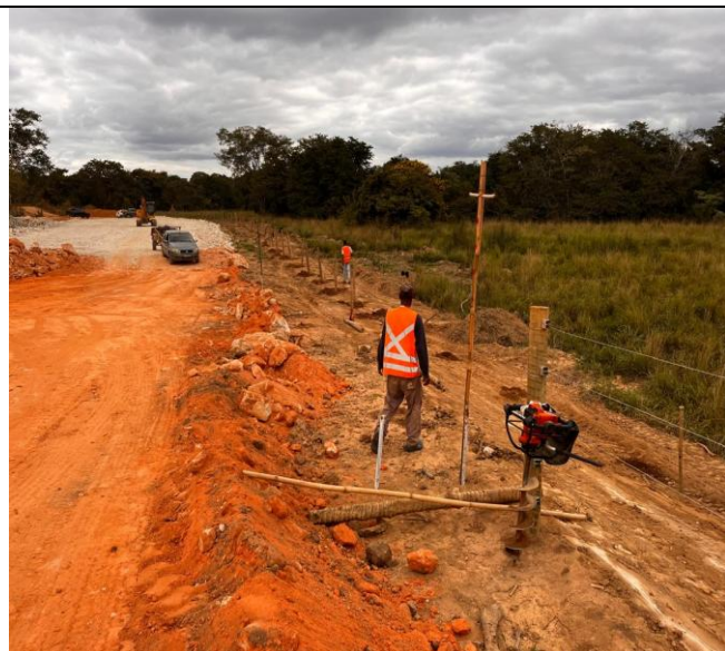
Foto 19 – Remoção de cercas e mourões.
