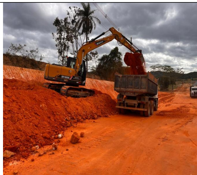
Foto 39 – Escavação vertical a céu aberto em material de 1ª categoria.
