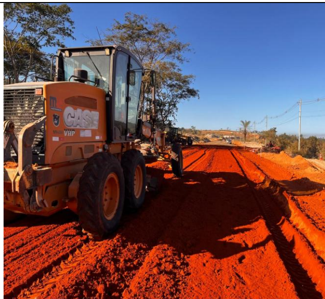
Foto 60 – Regularização e compactação de subleito.
