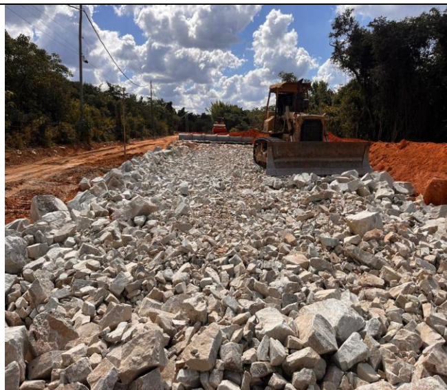
Foto 25 – Enrocamento com pedra de mão.
