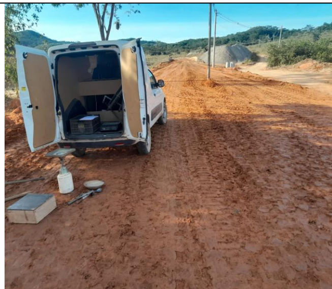
Foto 105 – Liberação camada de aterro.
