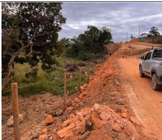
Foto 21 – Remoção de cercas e mourões.
