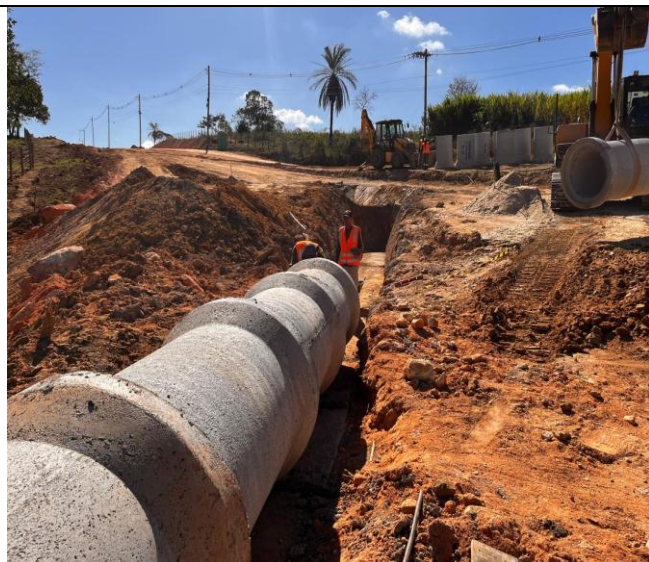
Foto 97 – Tubo de concreto DN 800 mm.
