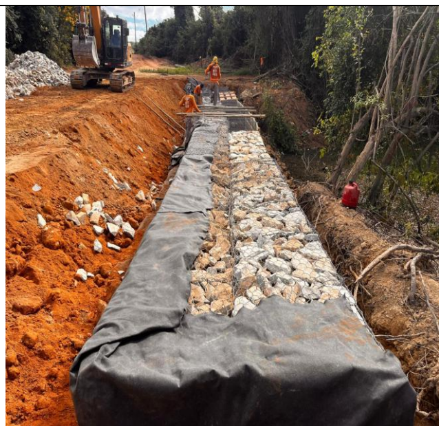
Foto 28 – Execução de arrimo em gabião tipo caixa.
