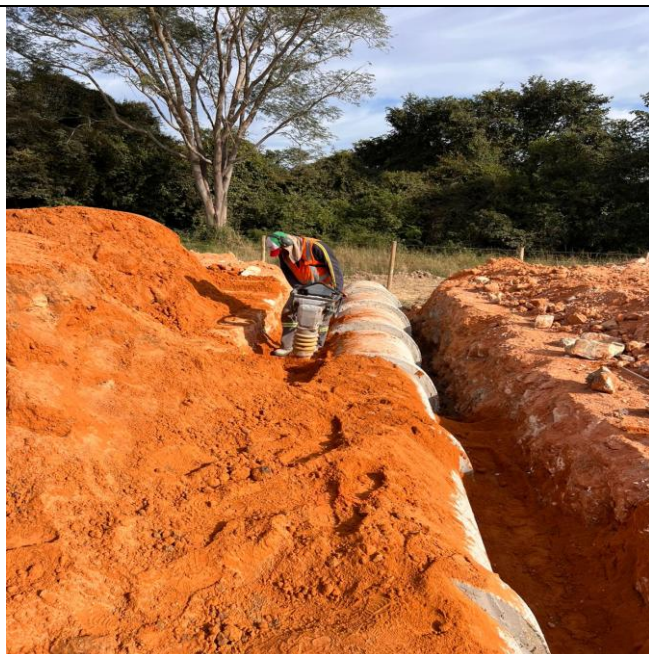
Foto 101 – Reaterro manual e compactação de vala.
