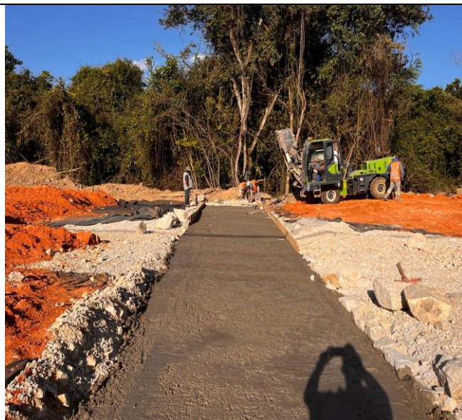
Foto 95 – Concreto para berço tubular.
