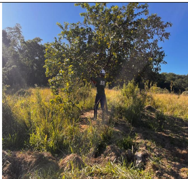
Foto 08 – Desmatamento, destocamento, limpeza de área.
