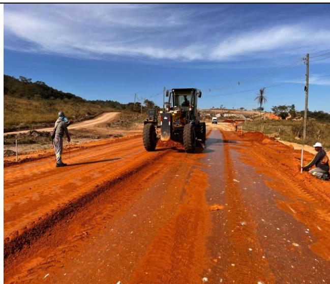
Foto 65 – Regularização e compactação de subleito.
