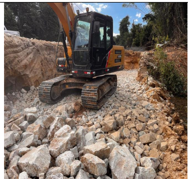
Foto 27 – Enrocamento fundo de gabião.
