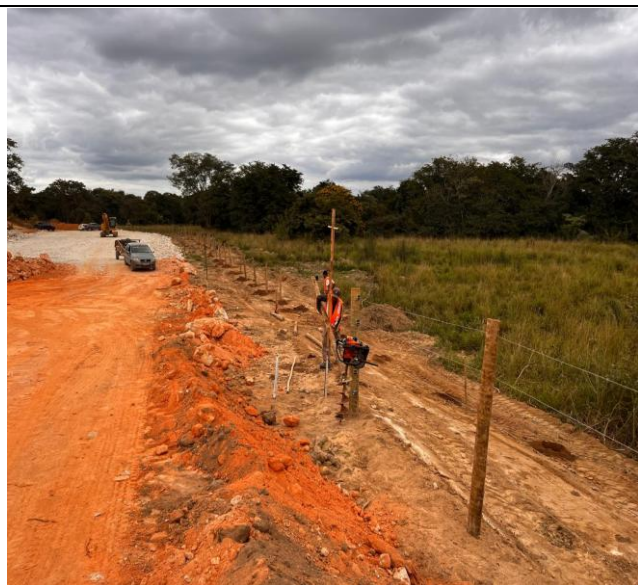
Foto 20 – Remoção de cercas e mourões.
