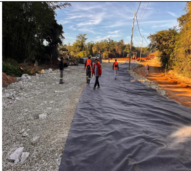
Foto 88 – Instalação de manta bidim na camada de enrocamento.
