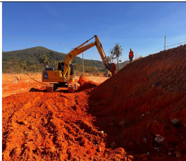
Foto 55 – Execução de rampa 1x1.
