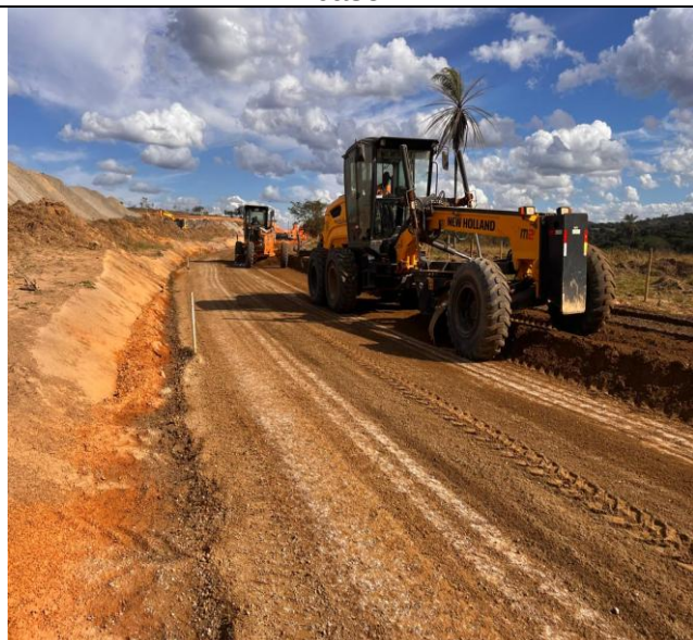
Foto 76 – Execução e compactação de base.
