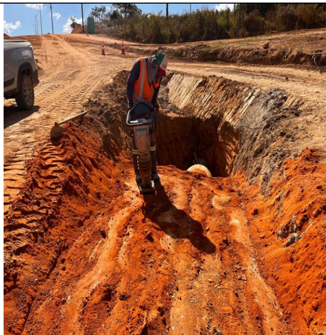
Foto 102 – Reaterro manual e compactação de vala.
