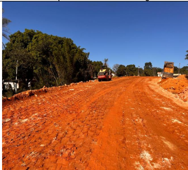
Foto 48 – Execução e compactação de aterro com solo predominantemente argiloso.
