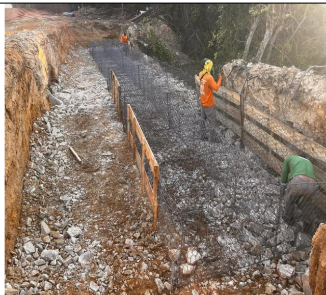
Foto 30 – Execução de arrimo em gabião tipo caixa.
