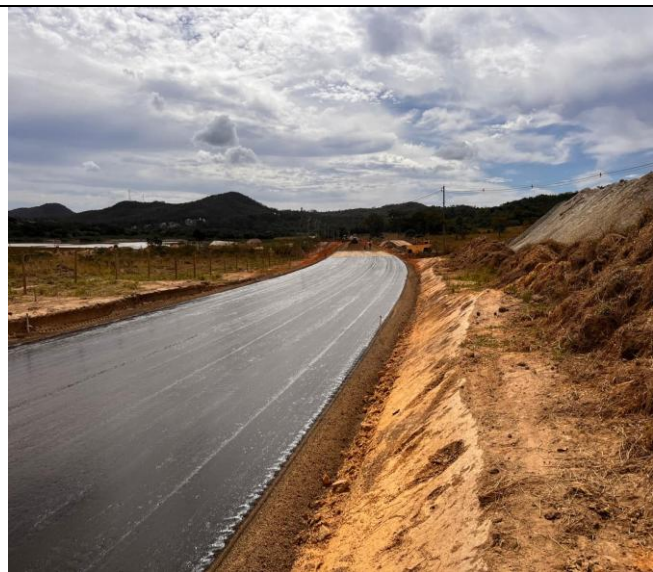
Foto 83 – Imprimação asfáltica.
