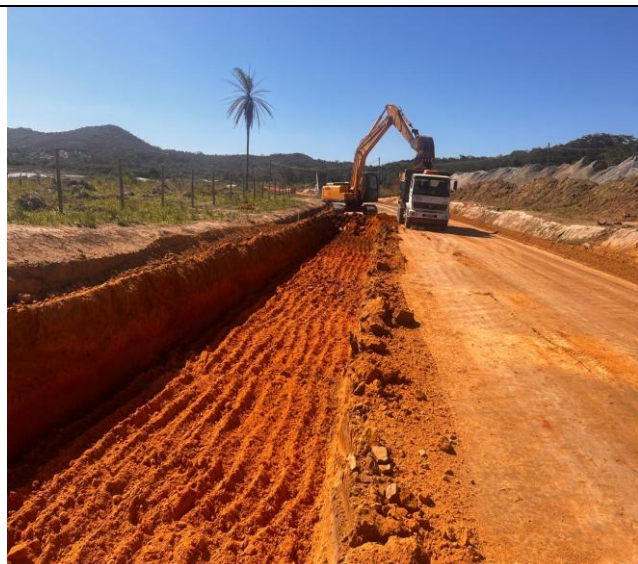
Foto 22 – Escavação mecânica em solo mole.
