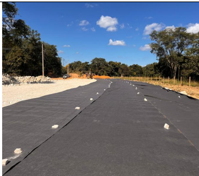
Foto 89 – Aplicação de manta bidim.
