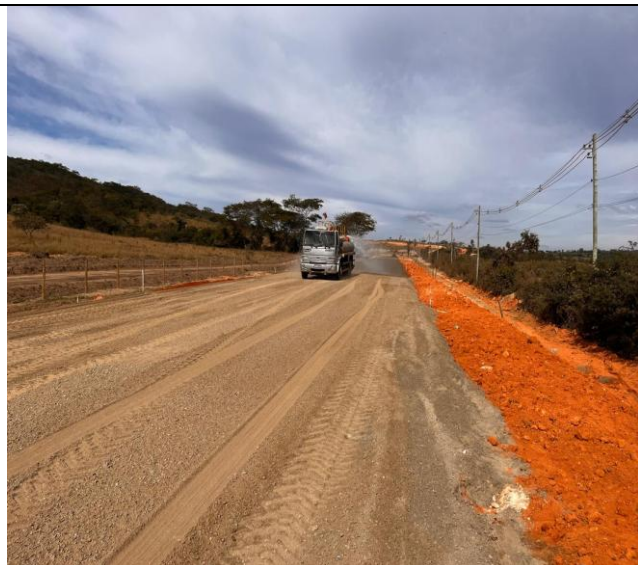
Foto 80 – Execução e compactação de base.
