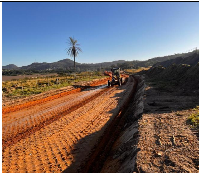
Foto 64 – Regularização e compactação de subleito.
