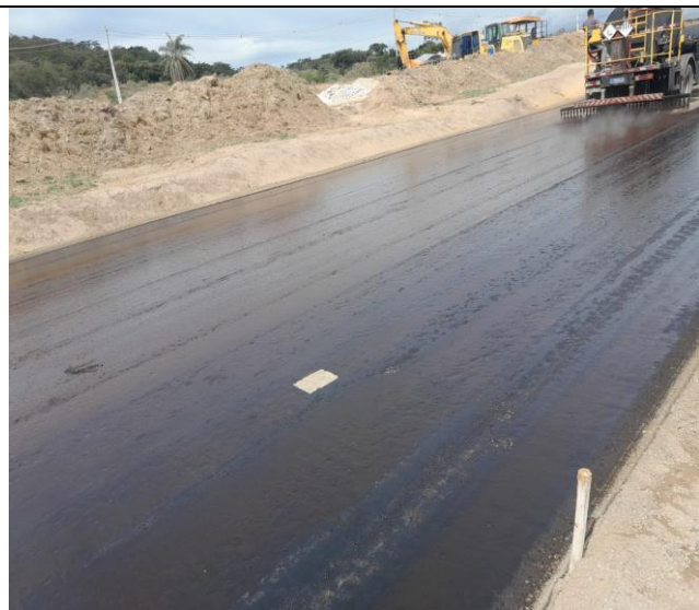
Foto 86 – Imprimação asfáltica.
