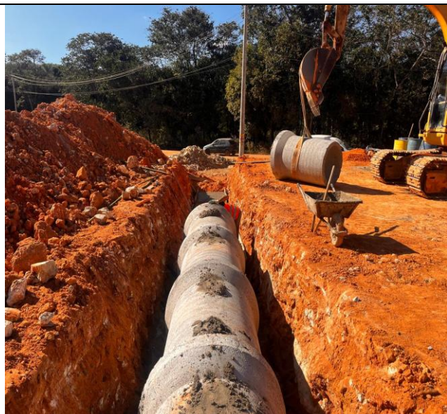
Foto 96 – Tubo de concreto DN 800 mm.
