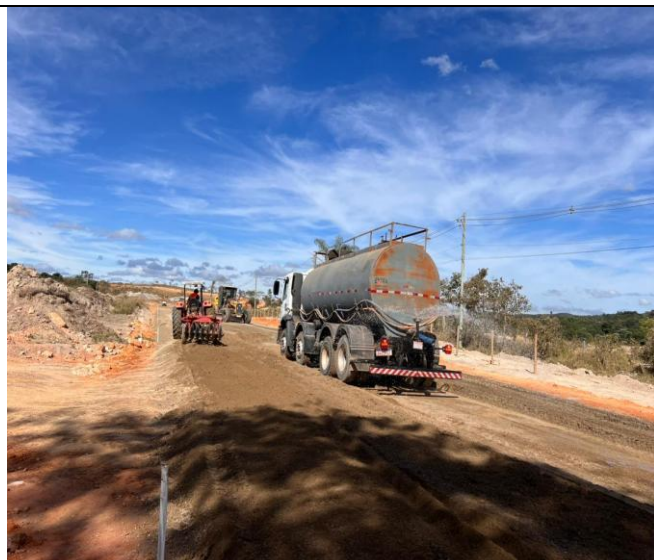
Foto 70 – Execução e compactação de sub-base.
