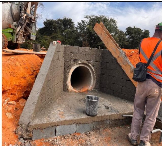
Foto 114 – Execução de ala.
