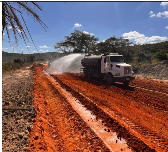
Foto 59 – Regularização e compactação de subleito.
