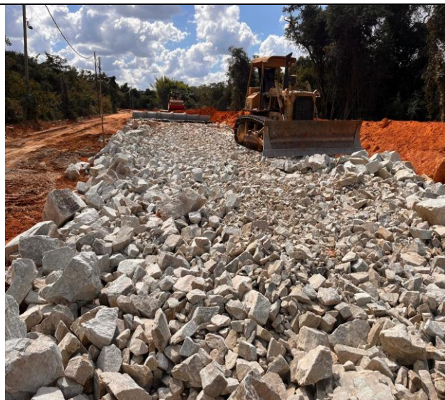
Foto 24 – Enrocamento com pedra de mão.
