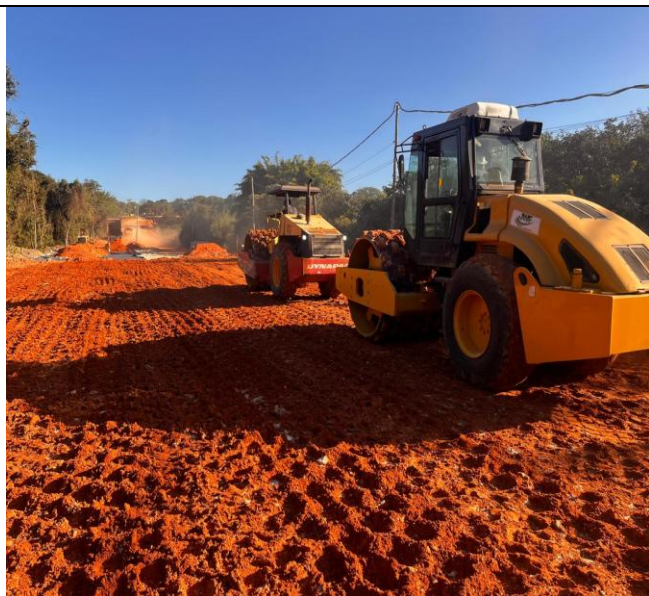
Foto 49 – Execução e compactação de aterro com solo predominantemente argiloso.
