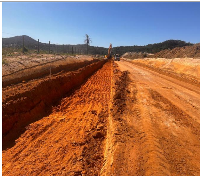
Foto 23 – Escavação mecânica em solo mole.
