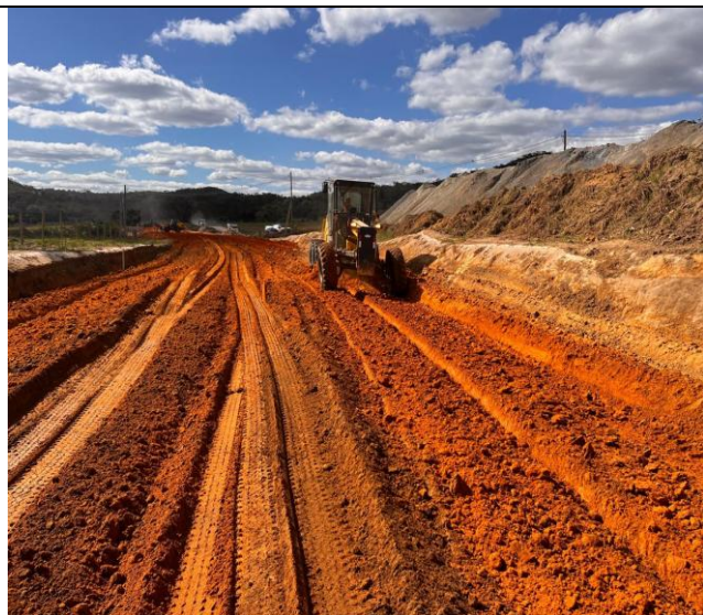
Foto 58 – Regularização e compactação de subleito.
