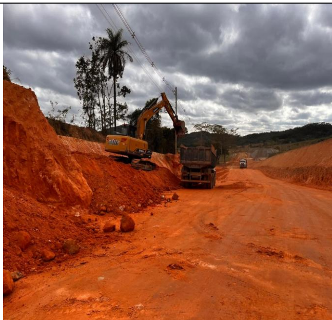
Foto 41 – Escavação vertical a céu aberto em material de 1ª categoria.
