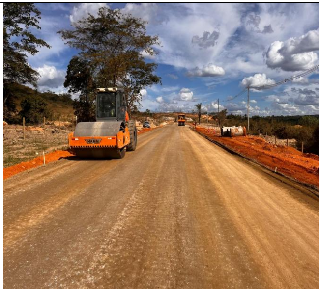
Foto 75 – Execução e compactação de sub-base.
