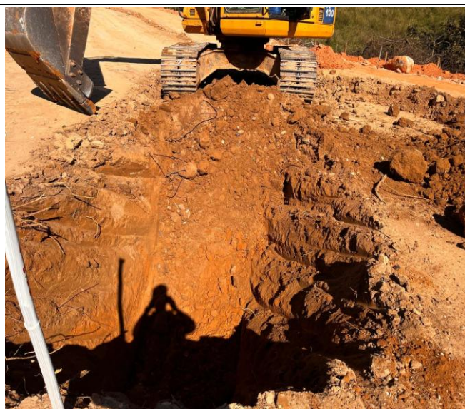
Foto 90 – Escavação mecanizada de vala.
