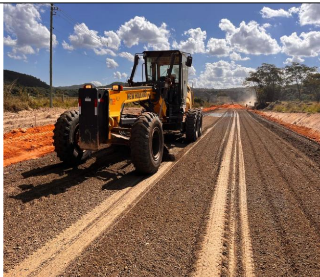
Foto 72 – Execução e compactação de sub-base.
