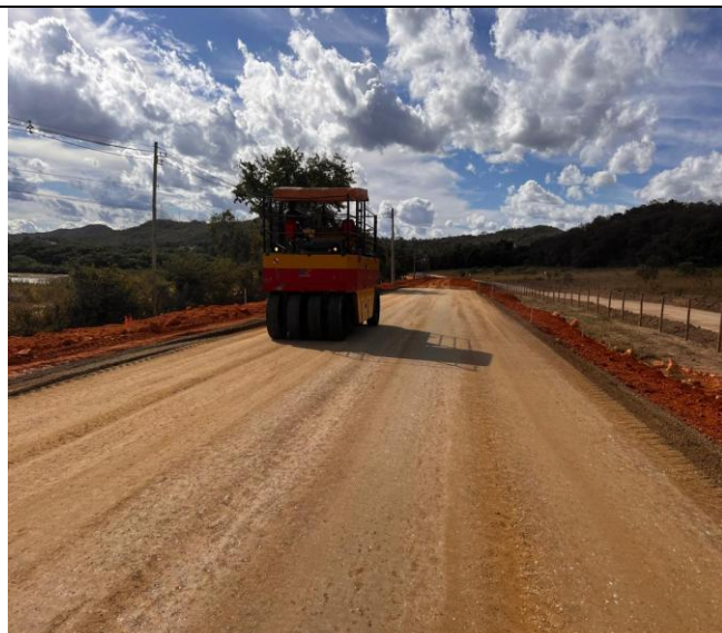
Foto 73 – Execução e compactação de sub-base.
