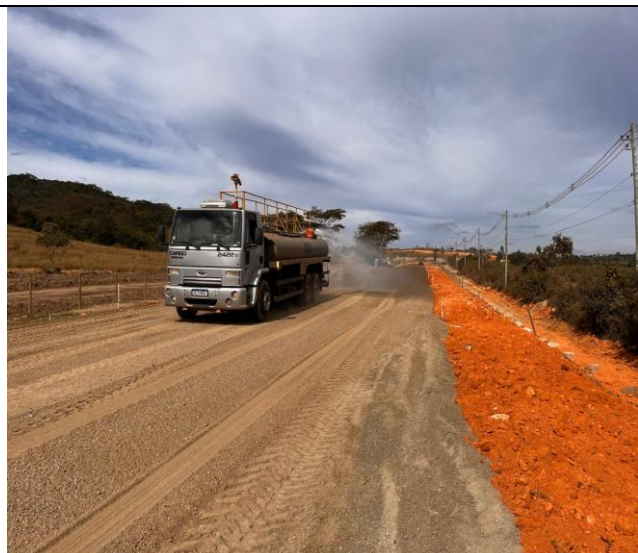
Foto 78 – Execução e compactação de base.
