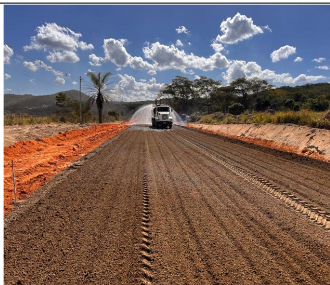
Foto 69 – Execução e compactação de sub-base.
