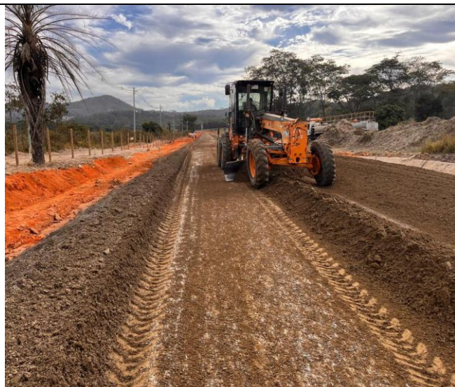
Foto 77 – Execução e compactação de base.
