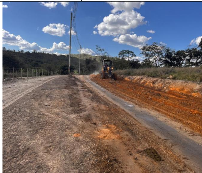
Foto 11 – Desmatamento, destocamento, limpeza de área.
