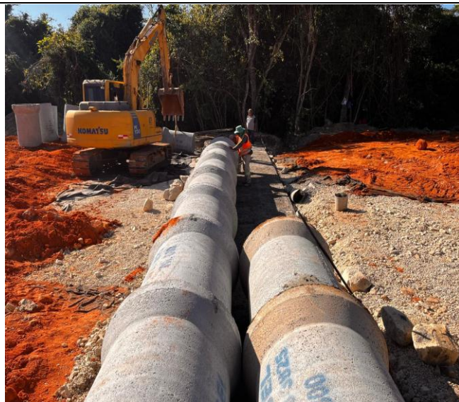
Foto 99 – Tubo de concreto duplo DN 800 mm.
