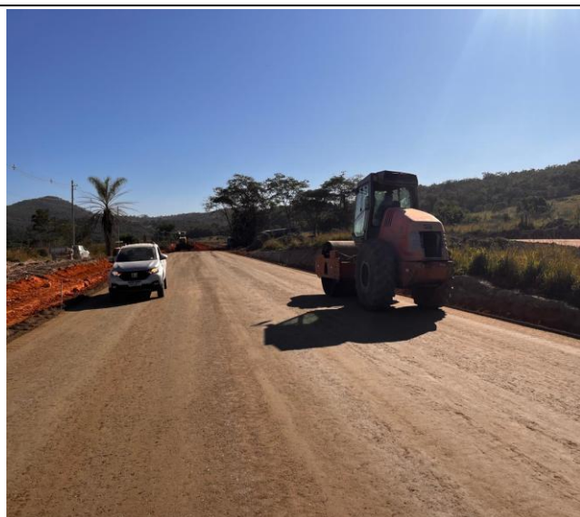
Foto 74 – Execução e compactação de sub-base.
