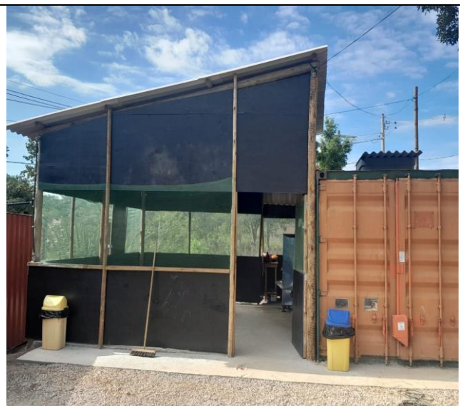
Foto 04 – Locação de Container
