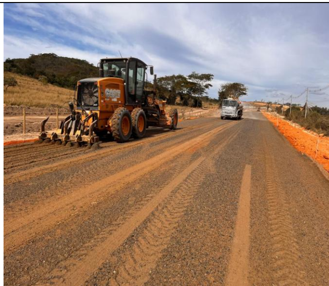
Foto 79 – Execução e compactação de base.
