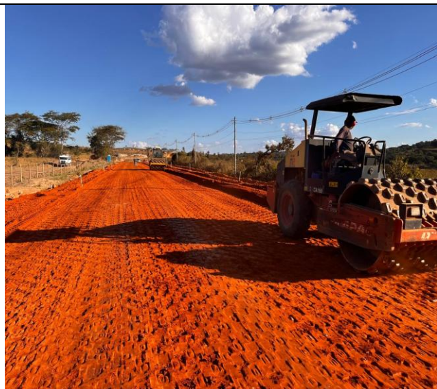
Foto 62 – Regularização e compactação de subleito.
