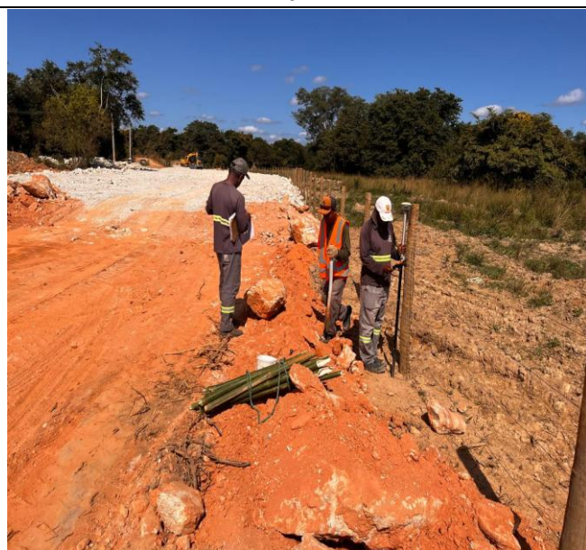
Foto 07 – Locação topográfica.
