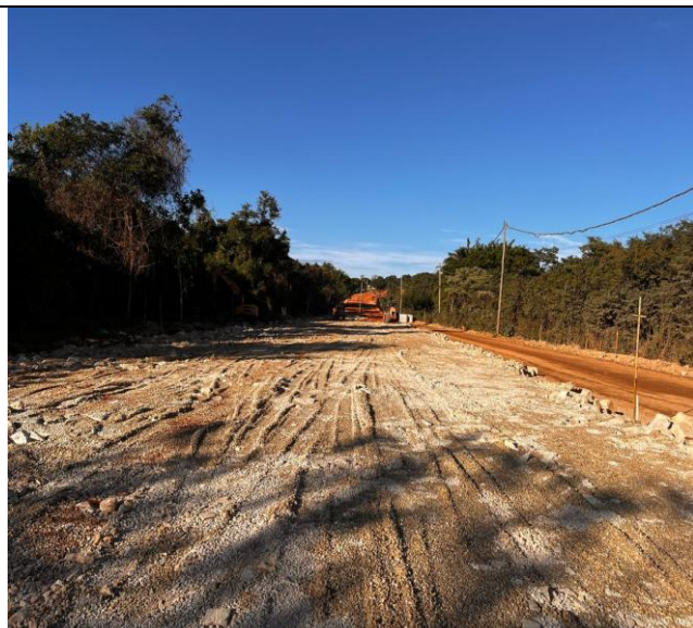
Foto 38 – Transição de enrocamento.
