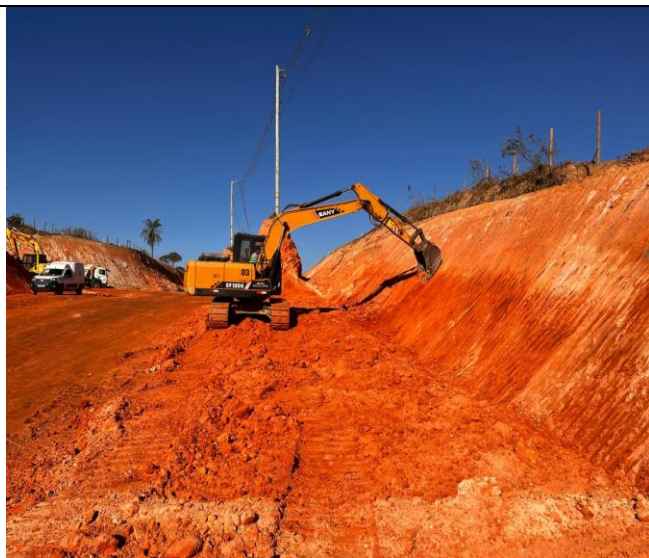
Foto 57 – Execução de rampa 1x1.
