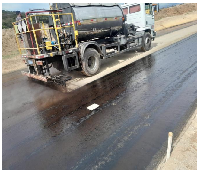
Foto 81 – Imprimação asfáltica.
