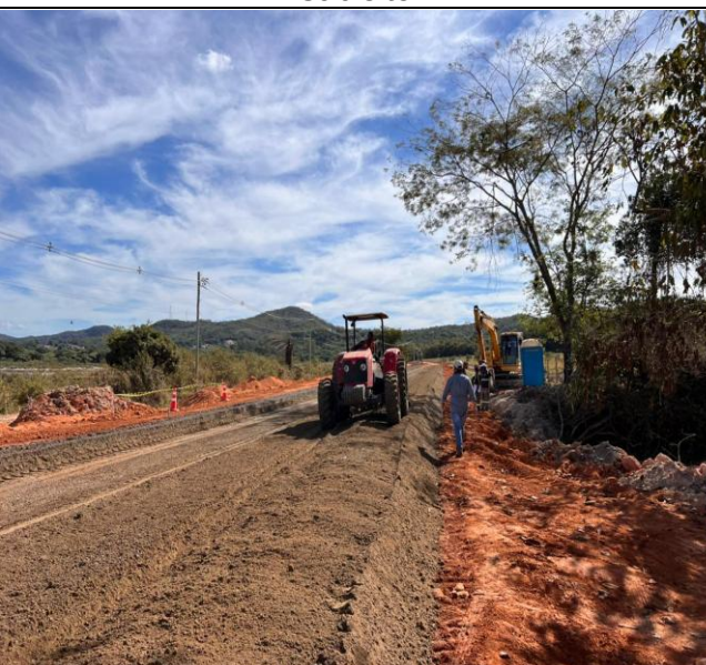
Foto 68 – Execução e compactação de sub-base.
