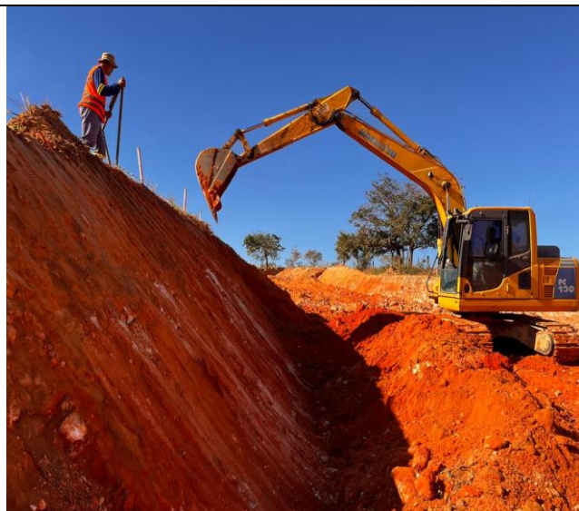
Foto 56 – Execução de rampa 1x1 que dá acesso as carretas da pedreira.
