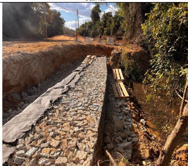
Foto 31 – Execução de arrimo em gabião tipo caixa.
