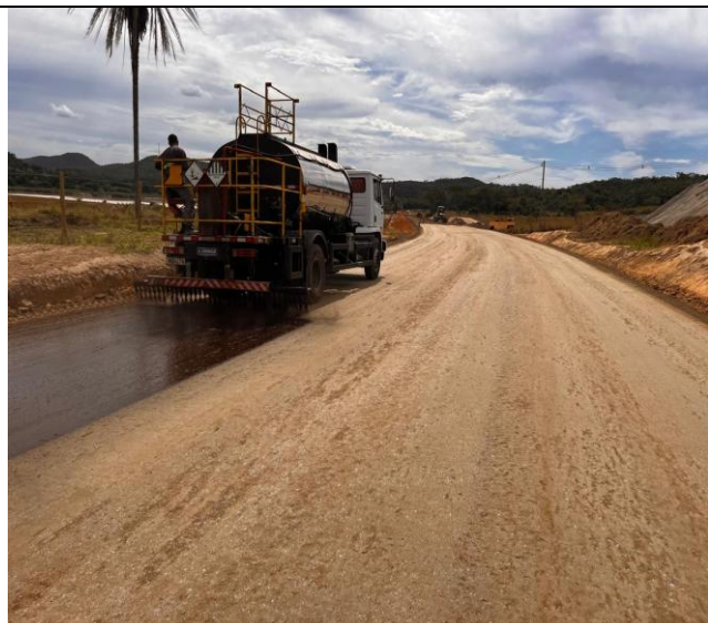
Foto 82 – Imprimação asfáltica.
