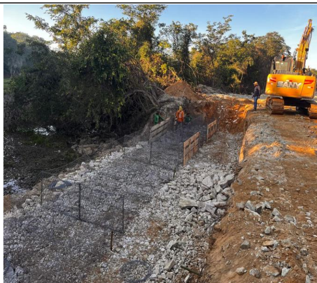
Foto 29 – Execução de arrimo em gabião tipo caixa.
