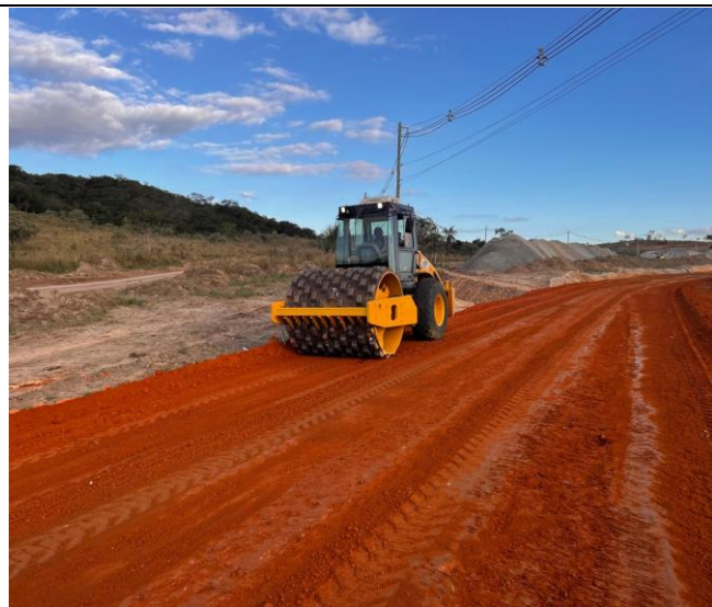
Foto 63 – Regularização e compactação de subleito.
