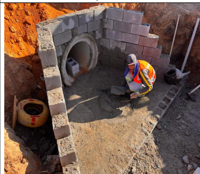
Foto 111 – Execução de ala.
