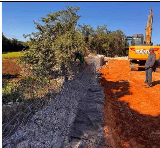
Foto 34 – Execução de arrimo em gabião tipo caixa.
