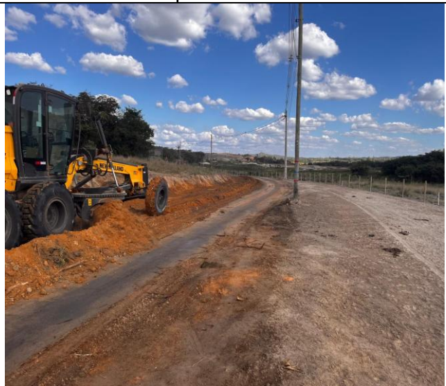
Foto 12 – Desmatamento, destocamento, limpeza de área.
