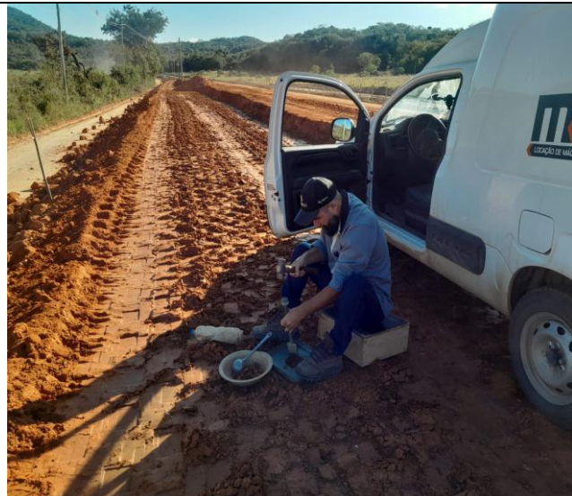
Foto 104 – Liberação camada de aterro escalonamento
