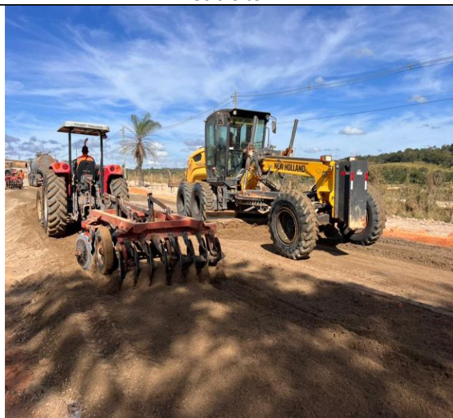
Foto 67 – Execução e compactação de sub-base.
