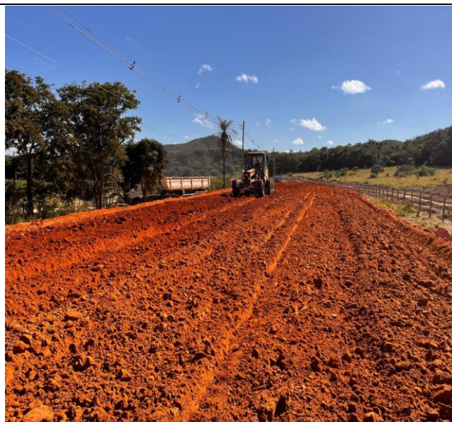
Foto 54 – Execução de camada final de aterro.
