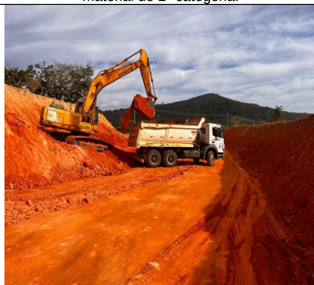
Foto 44 – Escavação, carga e transporte de material de 2ª categoria.
