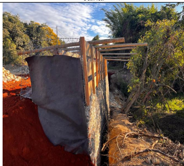
Foto 32 – Execução de arrimo em gabião tipo caixa.
