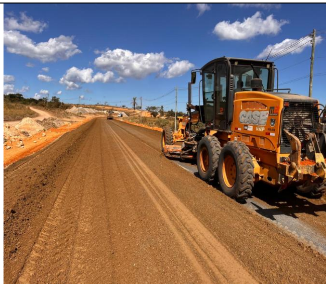
Foto 71 – Execução e compactação de sub-base.
