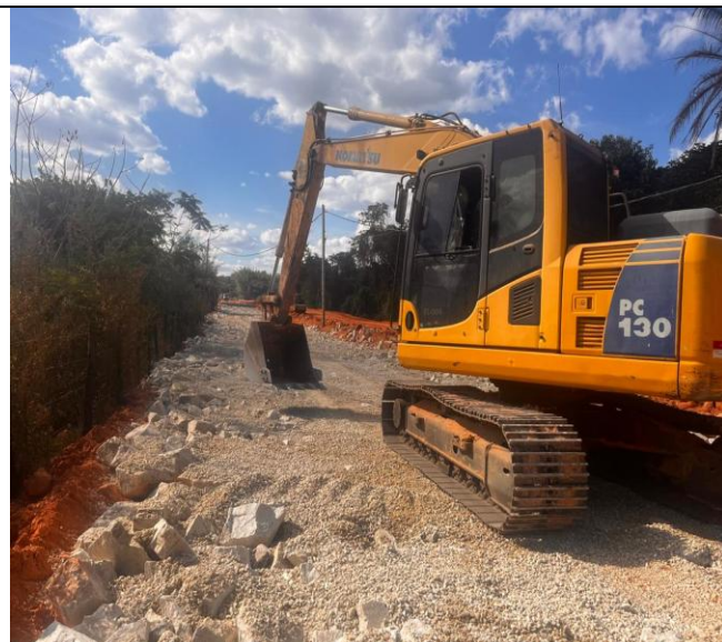
Foto 37 – Transição de enrocamento.
