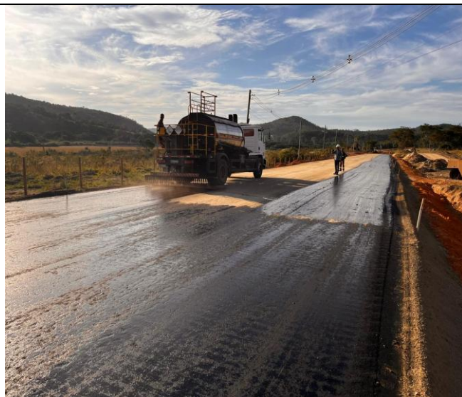
Foto 85 – Imprimação asfáltica.
