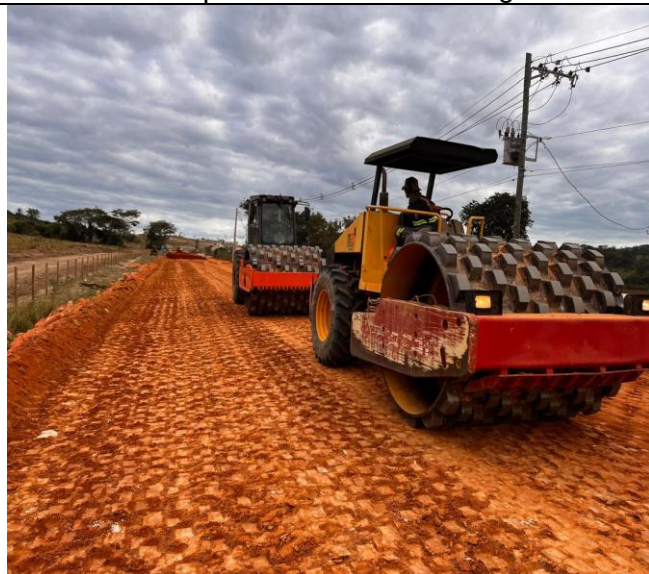
Foto 47 – Execução e compactação de aterro com solo predominantemente argiloso.
