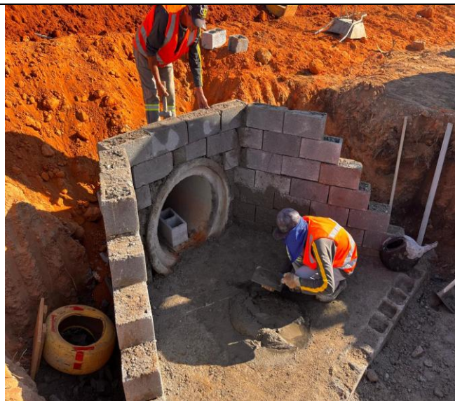
Foto 113 – Execução de ala.
