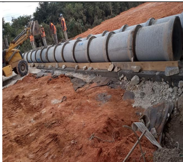
Foto 98 – Tubo de concreto duplo DN 800 mm.
