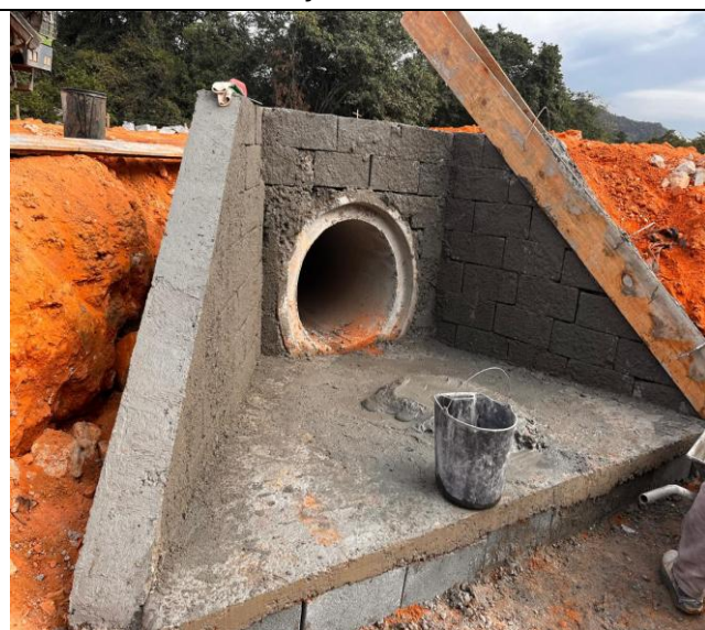
Foto 112 – Execução de ala.
