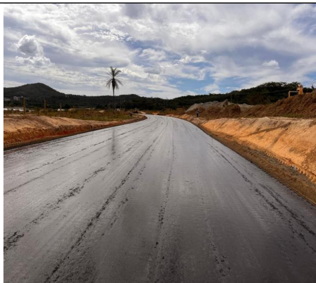
Foto 84 – Imprimação asfáltica.
