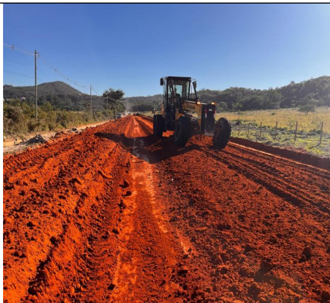
Foto 53 – Execução de camada final de aterro.
