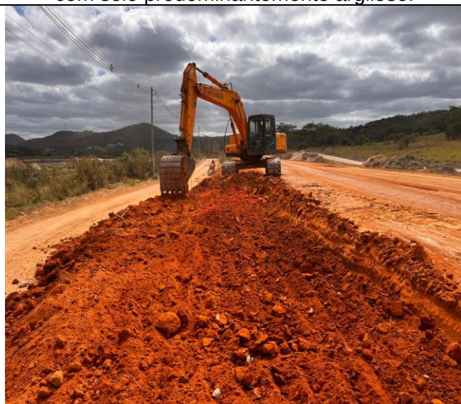
Foto 51 – Escalonamento e levantamento topográfico.
