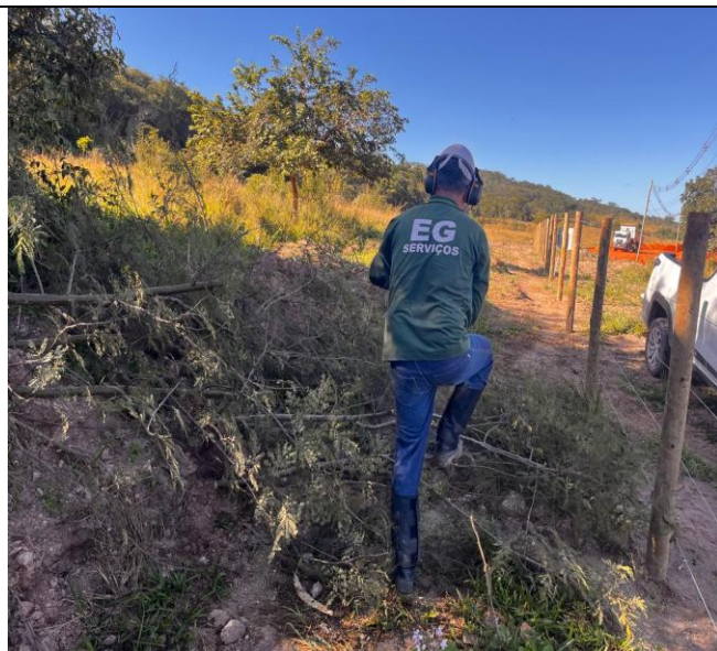
Foto 09 – Desmatamento, destocamento, limpeza de área.
