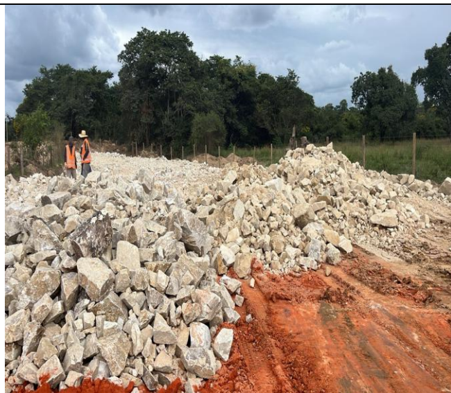
Foto 25 – Enrocamento com pedra de mão.
