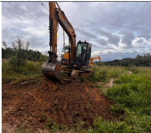
Foto 10 – Desmatamento, destocamento, limpeza de área.
