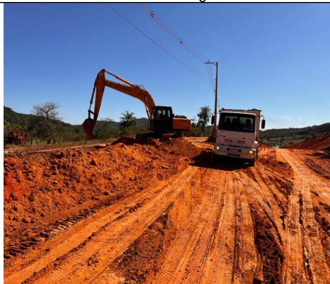
Foto 39 – Escavação vertical a céu aberto em solo de 1ª categoria.
