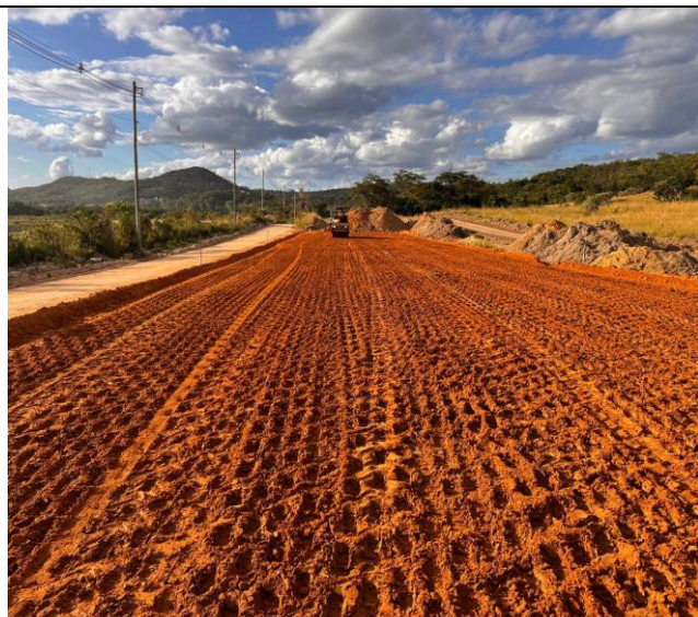
Foto 50 – Execução e compactação de aterro com solo predominantemente argiloso.
