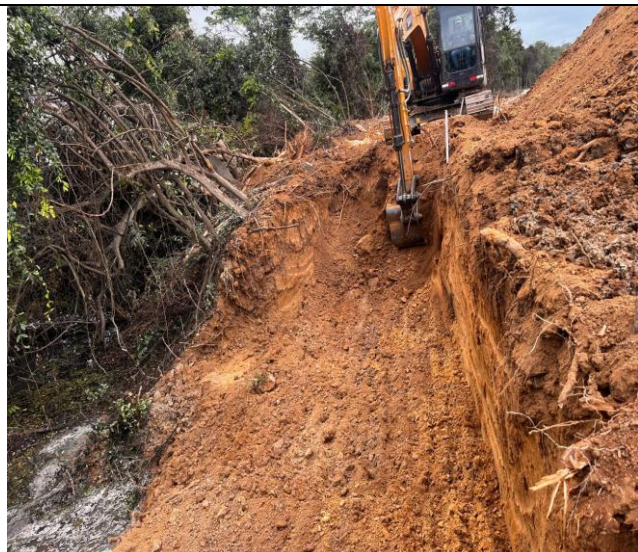
Foto 59 – Escalonamento para execução de gabião.
