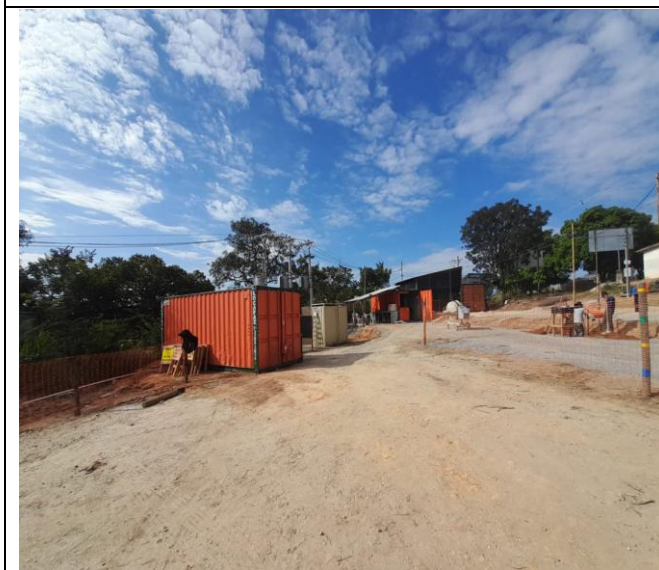
Foto 03 – Locação de Container
