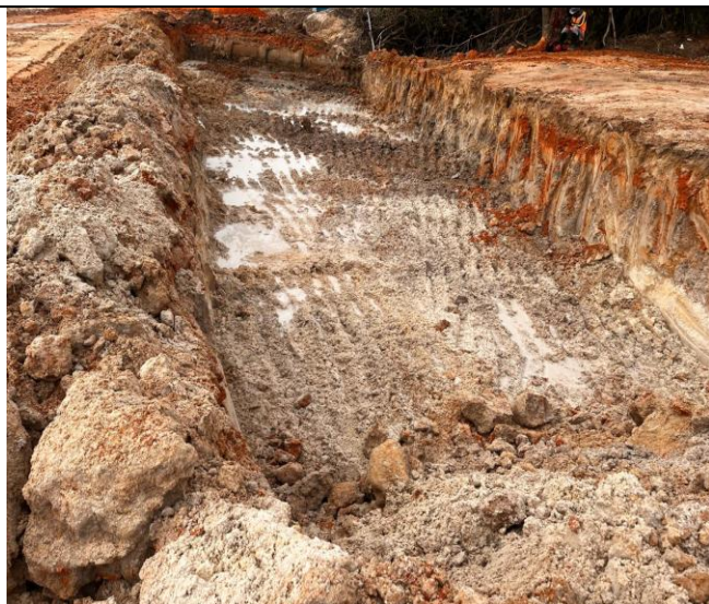
Foto 33 – Escavação mecânica em solo mole.
