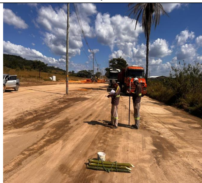
Foto 07 – Locação topográfica.
