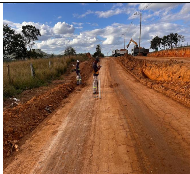
Foto 08 – Locação topográfica.
