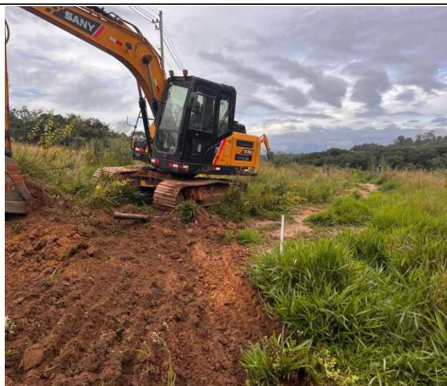
Foto 09 – Desmatamento, destocamento, limpeza de área.
