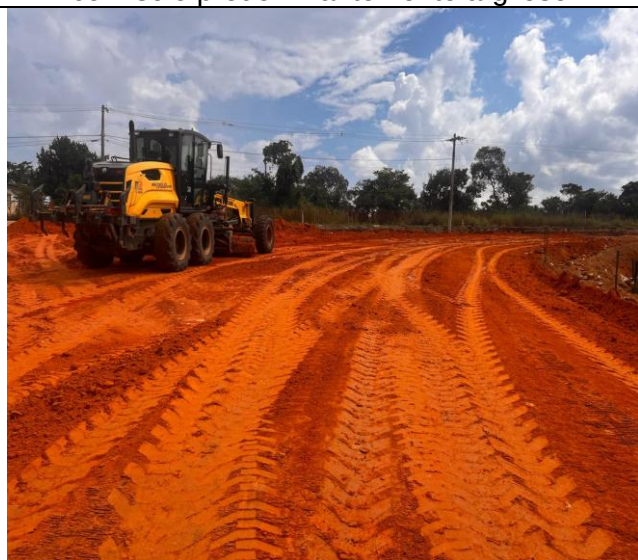
Foto 44 – Execução e compactação de aterro com solo predominantemente argiloso.
