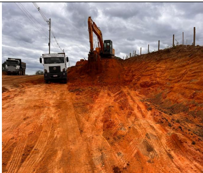
Foto 37 – Escavação vertical a céu aberto em solo de 1ª categoria.
