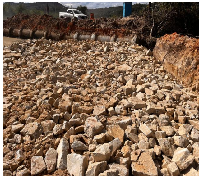
Foto 26 – Enrocamento com pedra de mão.
