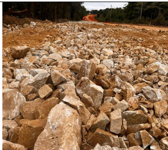
Foto 28 – Enrocamento com pedra de mão.
