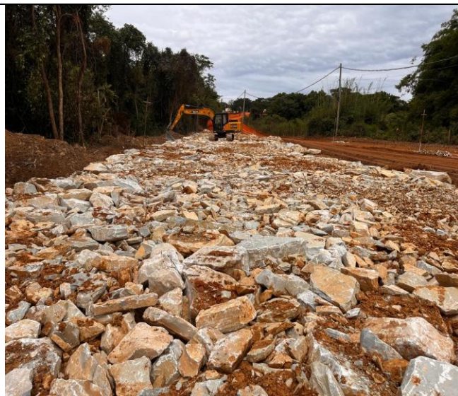
Foto 29 – Enrocamento com pedra de mão.
