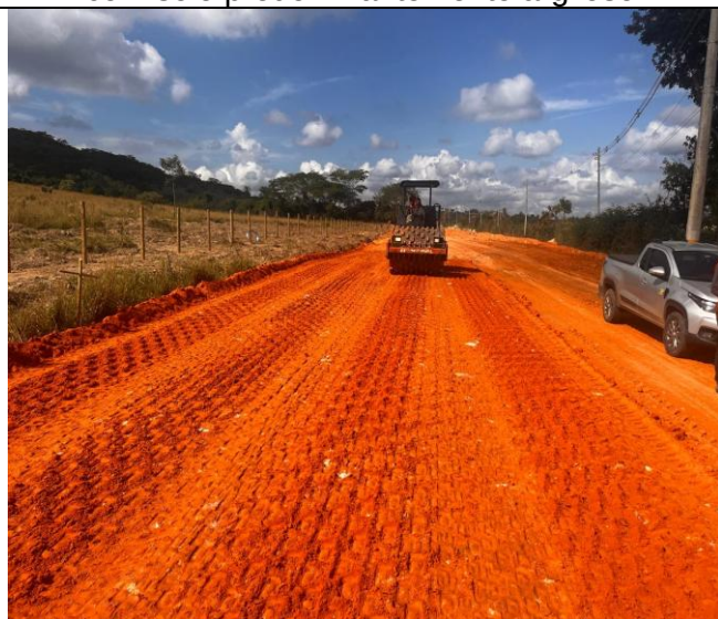
Foto 43 – Execução e compactação de aterro com solo predominantemente argiloso.
