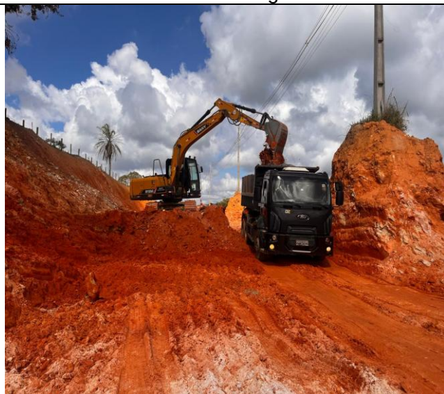
Foto 36 – Escavação vertical a céu aberto em solo de 1ª categoria.
