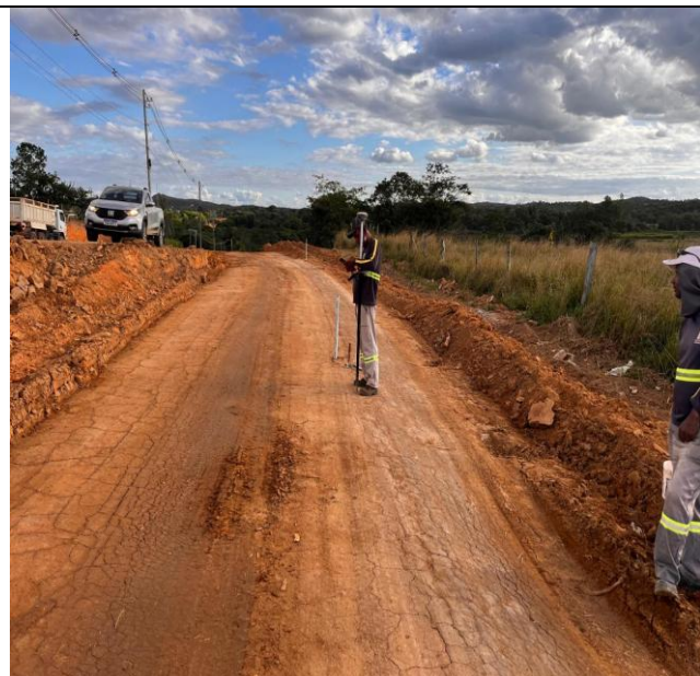
Foto 06 – Locação topográfica.
