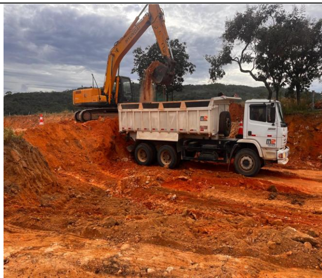
Foto 38 – Escavação vertical a céu aberto em solo de 1ª categoria.
