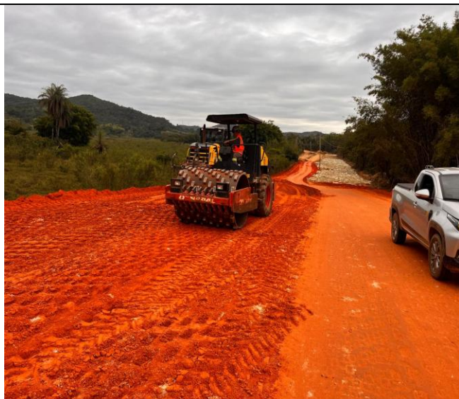
Foto 49 – Execução e compactação de aterro com solo predominantemente argiloso.
