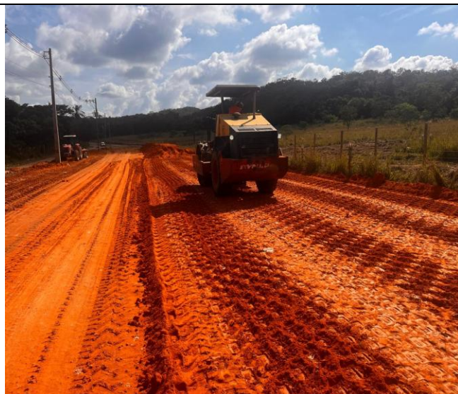
Foto 45 – Execução e compactação de aterro com solo predominantemente argiloso.
