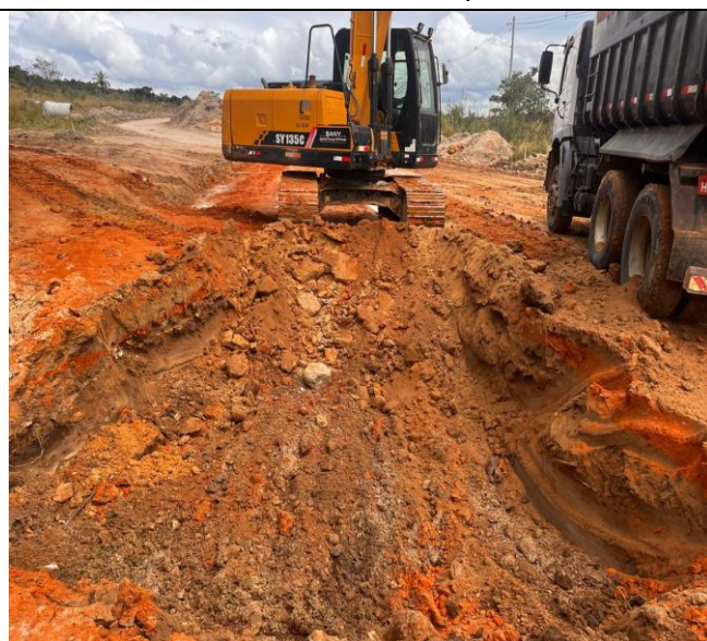
Foto 31 – Escavação mecânica em solo mole.
