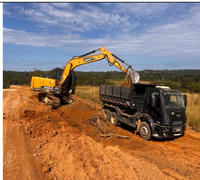
Foto 24 – Limpeza para bota fora.
