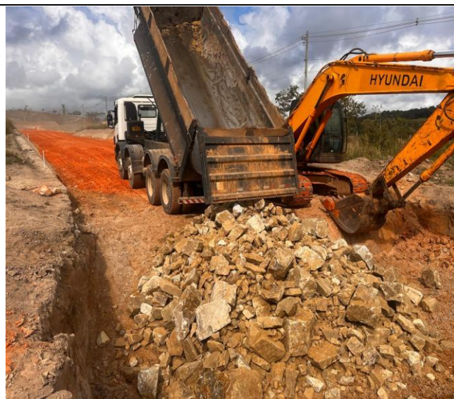
Foto 27 – Enrocamento com pedra de mão.
