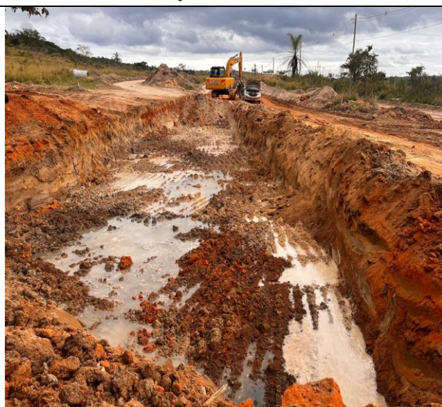
Foto 32 – Escavação mecânica em solo mole.
