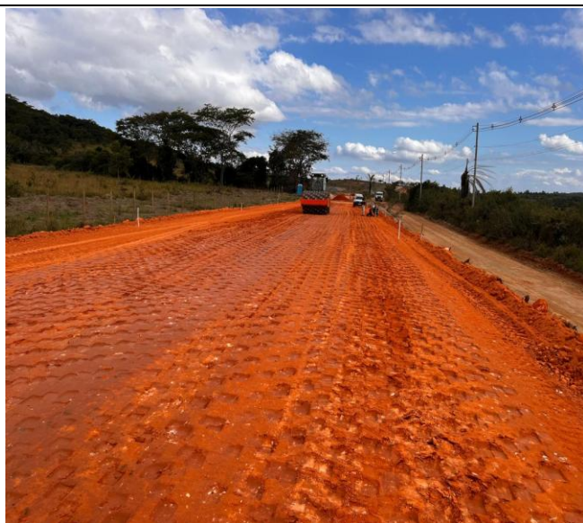
Foto 41 – Execução e compactação de aterro com solo predominantemente argiloso.
