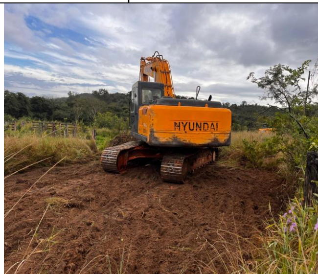
Foto 11 – Desmatamento, destocamento, limpeza de área.
