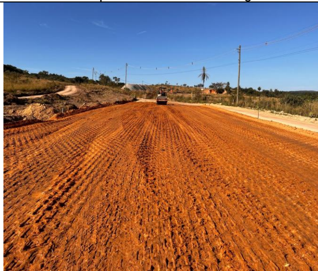
Foto 51 – Execução e compactação de aterro com solo predominantemente argiloso.
