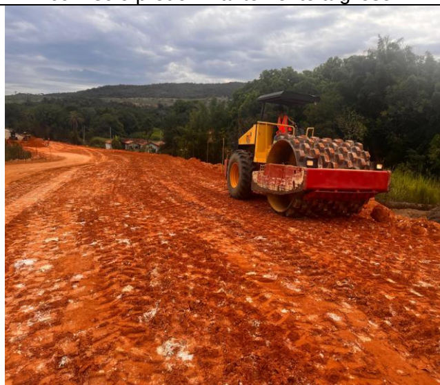
Foto 48 – Execução e compactação de aterro com solo predominantemente argiloso.
