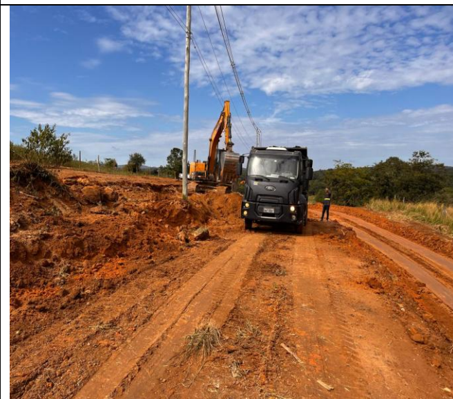
Foto 23 – Limpeza para bota fora.
