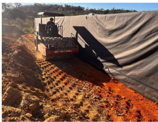
Foto 72 – Compactação de bueiro duplo celular de concreto 3,00x3,00 m
