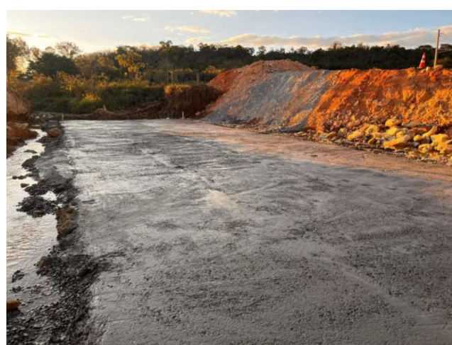
Foto 20 – Concretagem de Berço para bueiro duplo celular de concreto 3,00x3,00 m.
