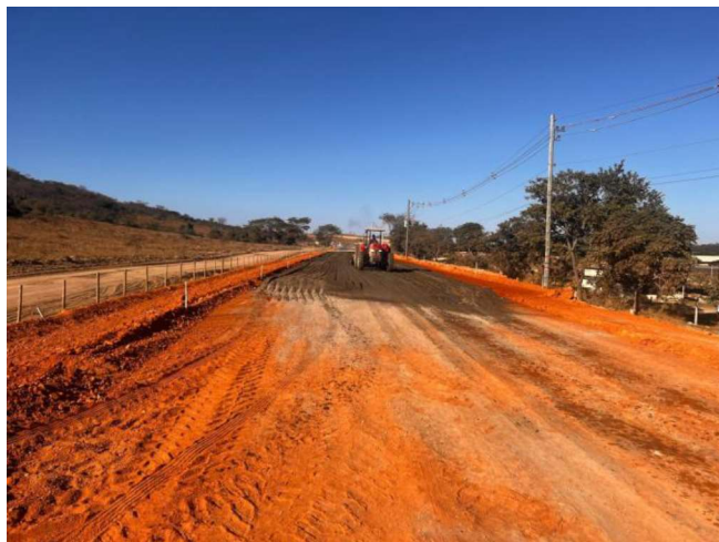
Foto 37 – Execução e compactação de sub-base.
