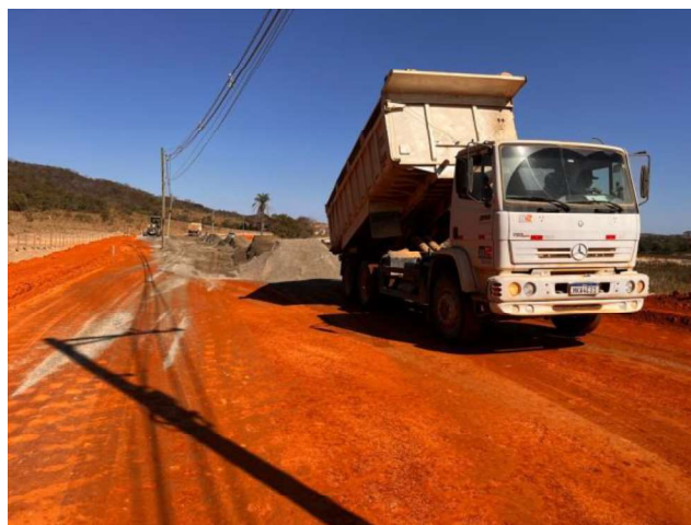
Foto 79 – Execução e compactação de sub-base.
