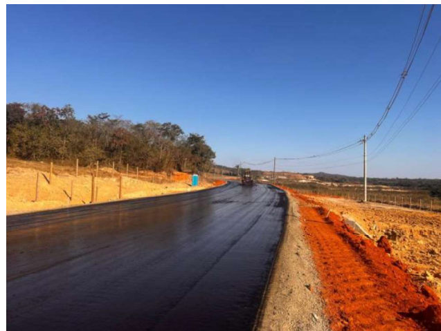
Foto 85 - Imprimação (Execução e Fornecimento do Material betuminoso).
