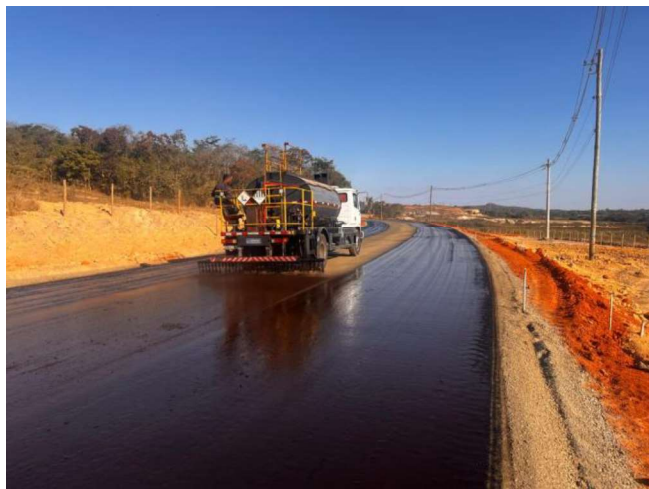
Foto 84 – Imprimação (Execução e Fornecimento do Material betuminoso).
