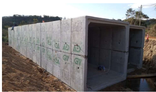
Foto 70 – Execução de bueiro duplo celular de concreto 3,00x3,00 m.
