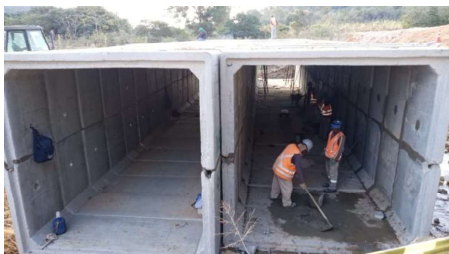
Foto 69 – Rejuntamento de bueiro duplo celular de concreto 3,00x3,00 m.
