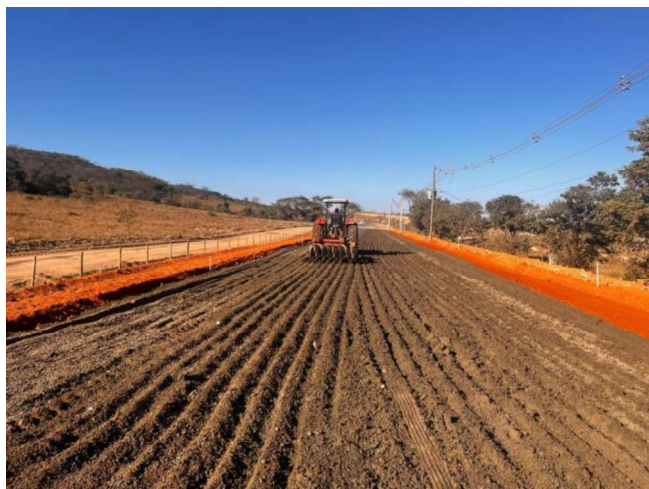
Foto 39 – Execução e compactação de sub-base.
