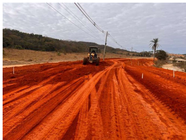
Foto 28 – Regularização e compactação de subleito.
