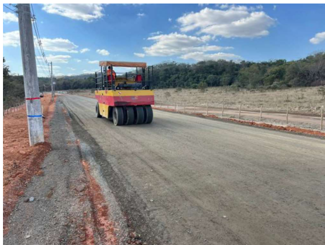
Foto 43 - Execução e compactação de sub-base.
