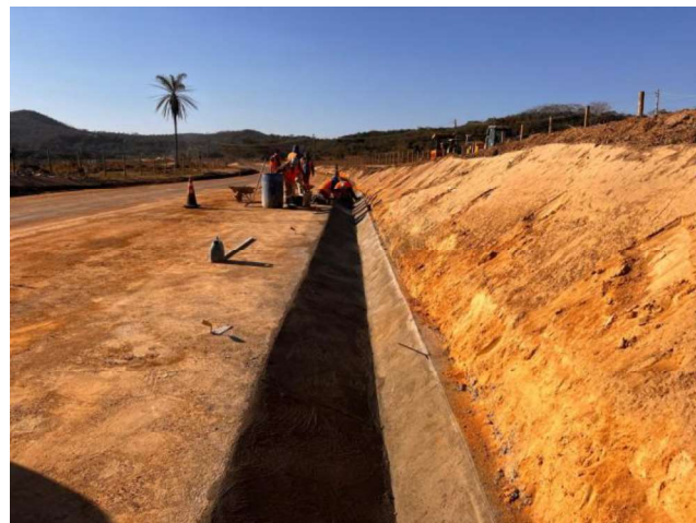
Foto 54 – Execução de Sarjeta triangular de concreto (STC-02).
