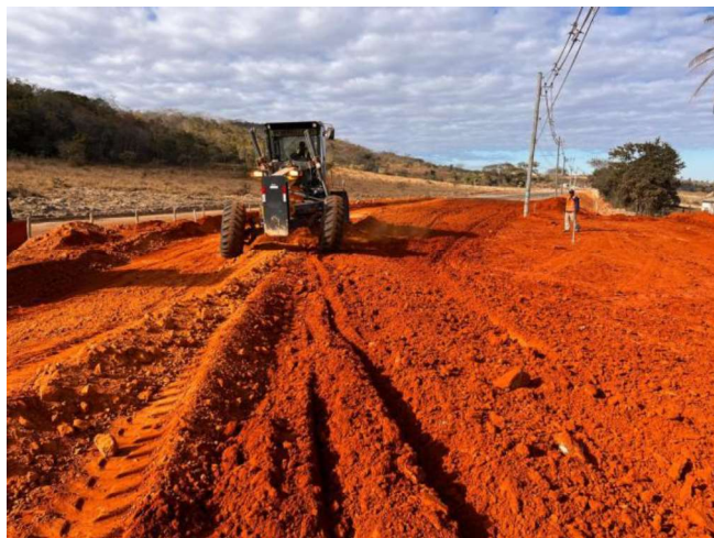
Foto 65 – Regularização e compactação de subleito.
