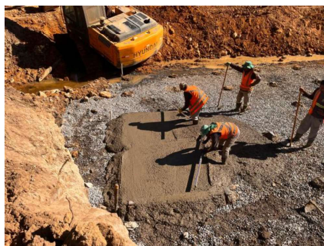
Foto 18 – Concretagem de Berço para bueiro duplo celular de concreto 3,00x3,00 m.
