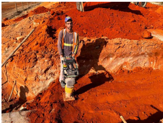
Foto 27- Reaterro manual e compactação de vala.
