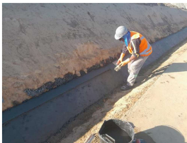
Foto 36 – Execução de Sarjeta triangular de concreto (STC-02).
