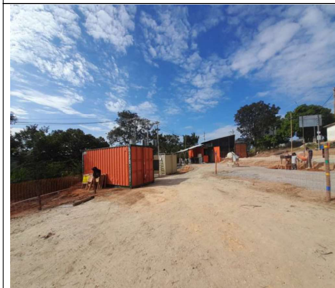
Foto 03 – Locação de Container.
