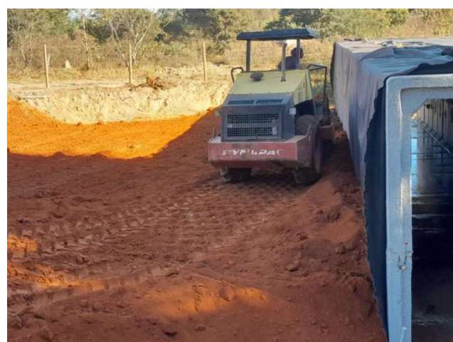
Foto 83 – Compactação de bueiro duplo celular de concreto 3,00x3,00 m.
