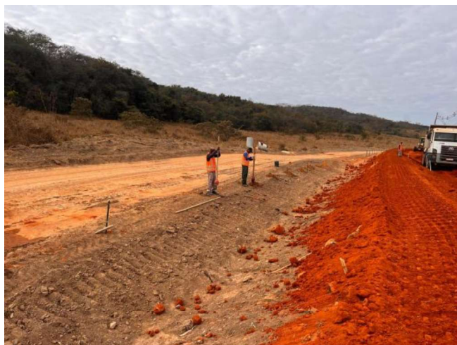
Foto 63 – Execução e remoção de cercas e mourões.
