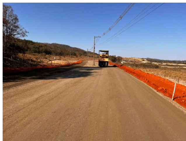
Foto 56 – Execução e compactação de sub-base.
