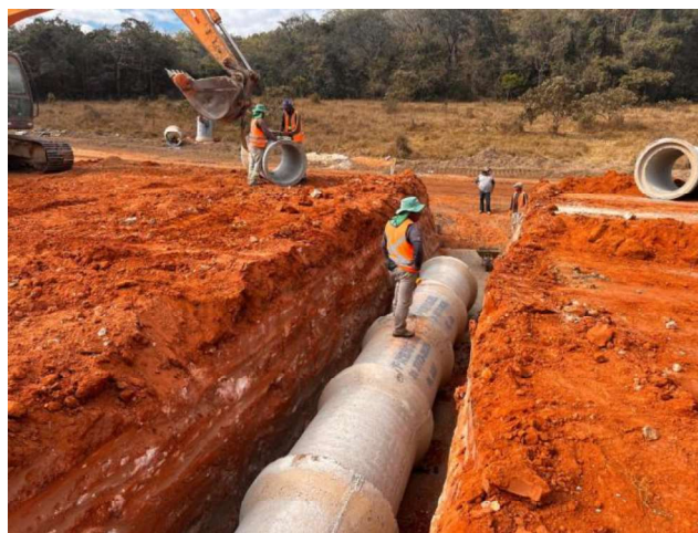
Foto 24 – Execução de rede de tubo de concreto DN 800 mm.
