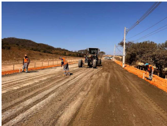
Foto 57 – Execução e compactação de base.
