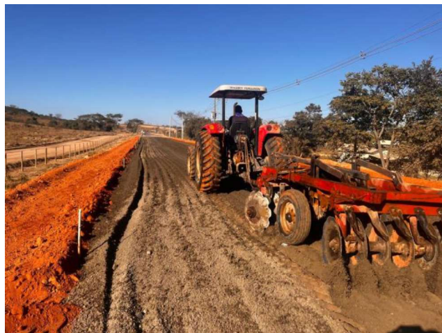
Foto 38 – Execução e compactação de sub-base.
