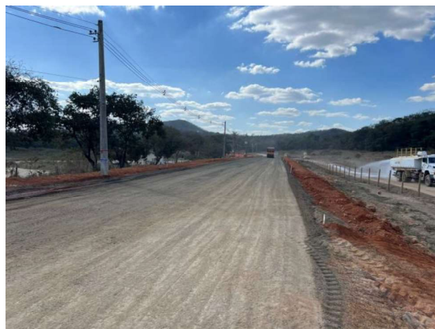
Foto 44 – Execução e compactação de sub-base.
