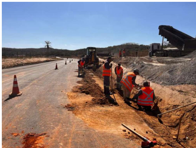
Foto 09 - Execução de Sarjeta triangular de concreto (STC-02).
