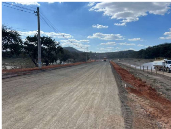
Foto 41 – Execução e compactação de sub-base.
