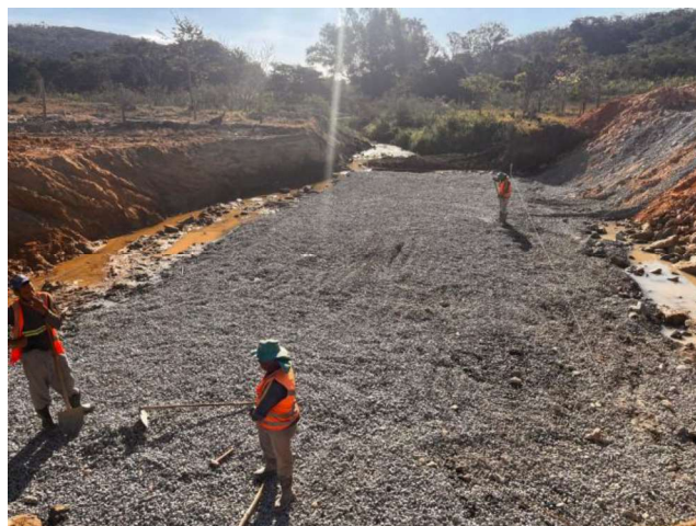
Foto 52 – Execução de Enrocamento para execução de berço. Estaca 127+10.
