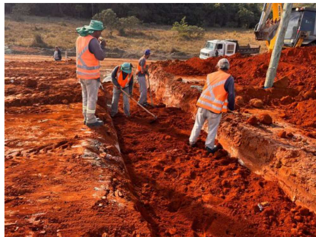
Foto 26 – Reaterro manual e compactação de vala.
