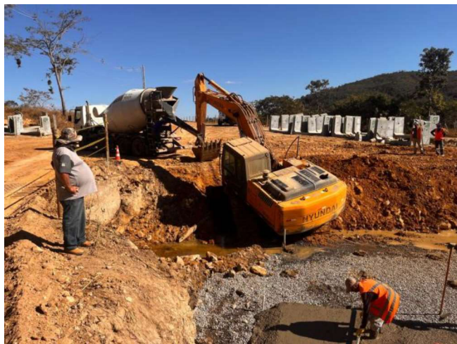
Foto 17 – Concretagem de Berço para bueiro duplo celular de concreto 3,00x3,00 m.
