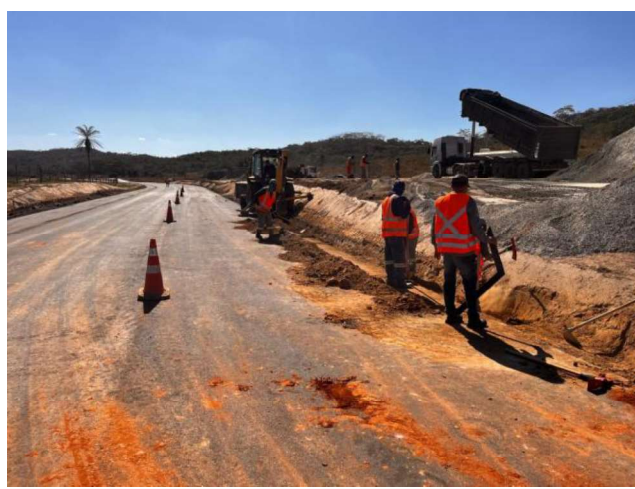
Foto 08 – Execução de Sarjeta triangular de concreto (STC-02).
