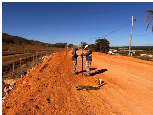
Foto 07 – Locação topográfica.
