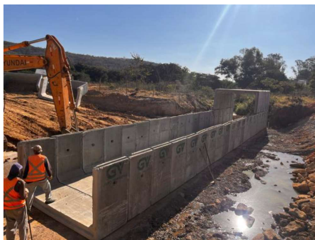
Foto 48 – Execução de bueiro duplo celular de concreto 3,00x3,00 m.
