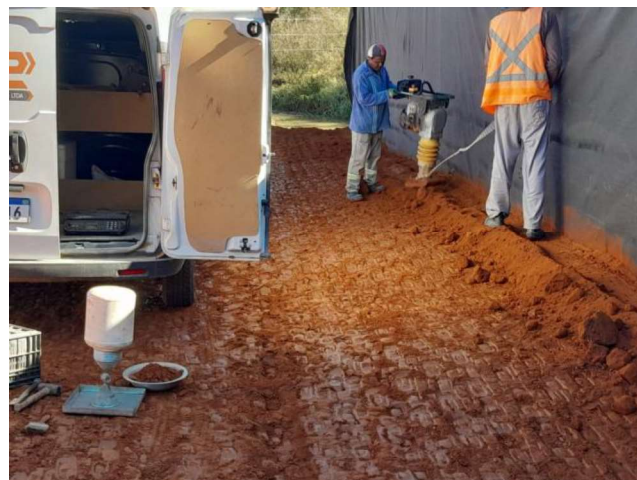
Foto 68 – Compactação de bueiro duplo celular de concreto 3,00x3,00 m.
