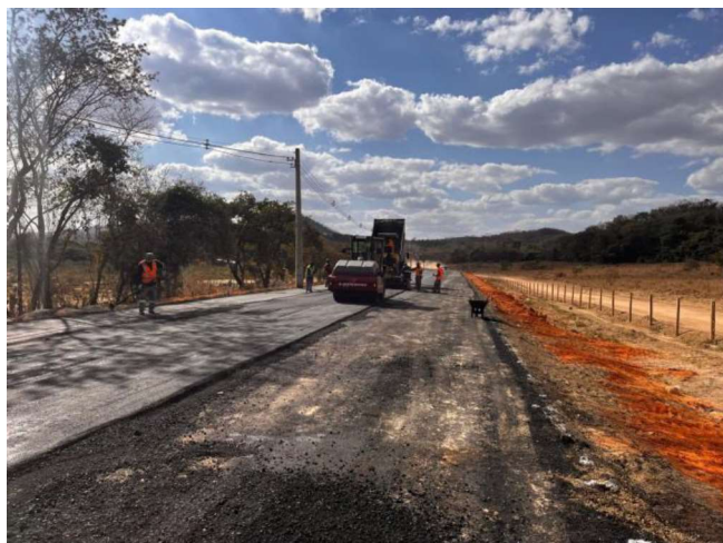
Foto 76 – Execução de pavimento com aplicação de concreto asfáltico.
