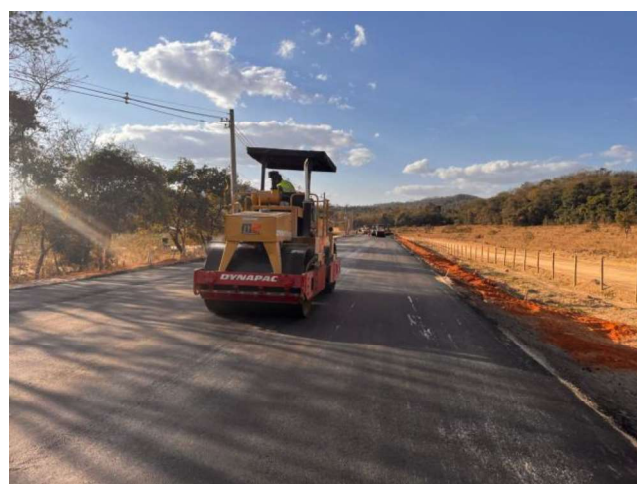
Foto 81 – Execução de pavimento com aplicação de concreto asfáltico.
