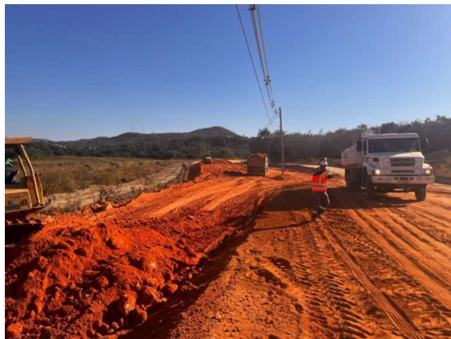
Foto 10 - Execução e compactação de aterro com solo predominantemente argiloso
