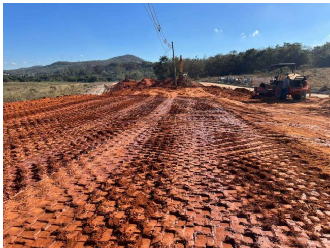
Foto 21 – Execução de Reforço de Subleito.
