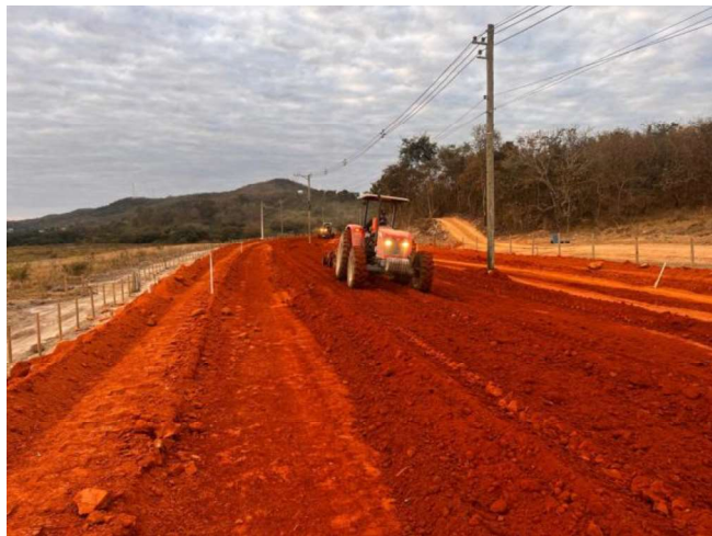
Foto 33 – Regularização e compactação de subleito.
