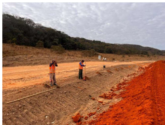
Foto 64 – Execução e remoção de cercas e mourões.
