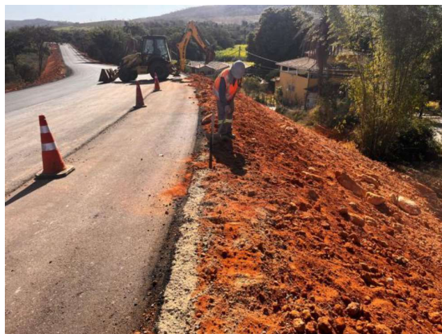
Foto 40 – Acabamento e Acerto Talude, Estaca 00 a 30.
