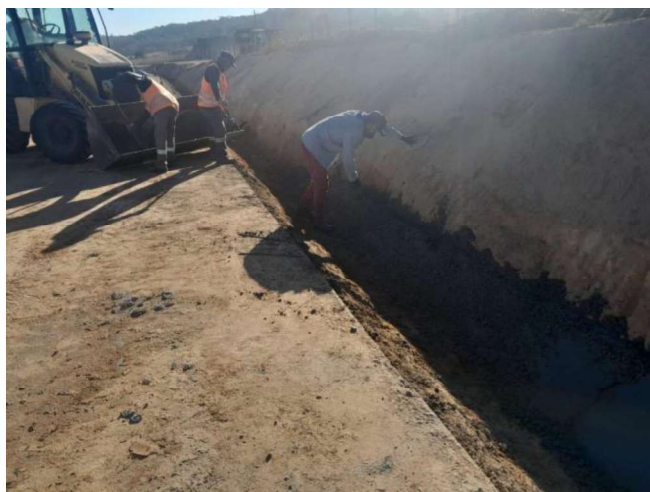
Foto 35 – Execução de Sarjeta triangular de concreto (STC-02).
