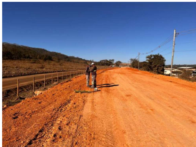
Foto 06 – Locação topográfica..
