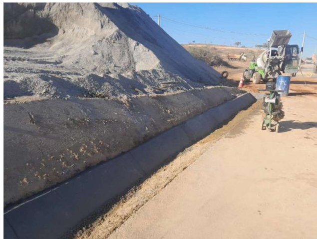
Foto 34 – Execução de Sarjeta triangular de concreto (STC-02).
