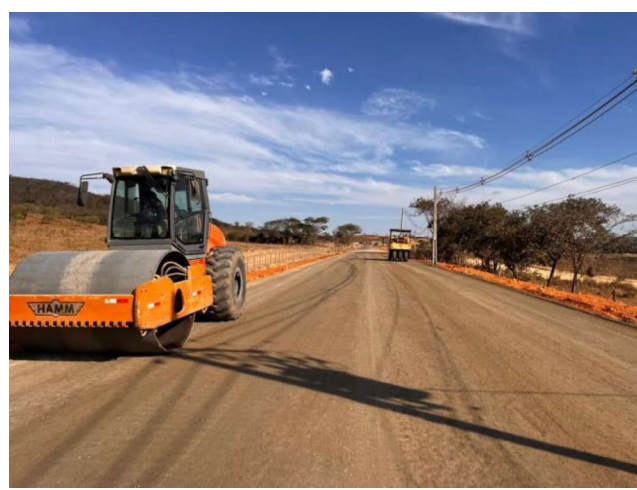
Foto 60 – Execução e compactação de base
