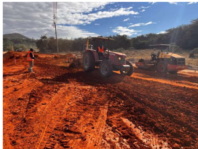
Foto 66 – Regularização e compactação de subleito.
