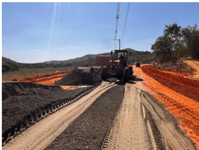
Foto 78 – Execução e compactação de sub-base.
