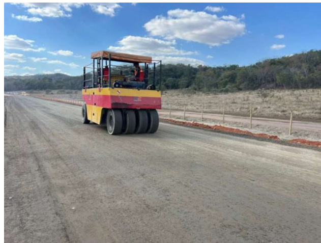
Foto 42 – Execução e compactação de sub-base.
