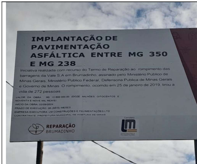
Foto 01 – Placa da Obra.
