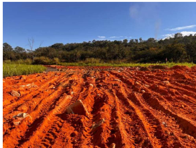
Foto 62 – Execução e compactação de aterro.
