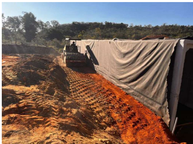
Foto 71 – Compactação de bueiro duplo celular de concreto 3,00x3,00 m.
