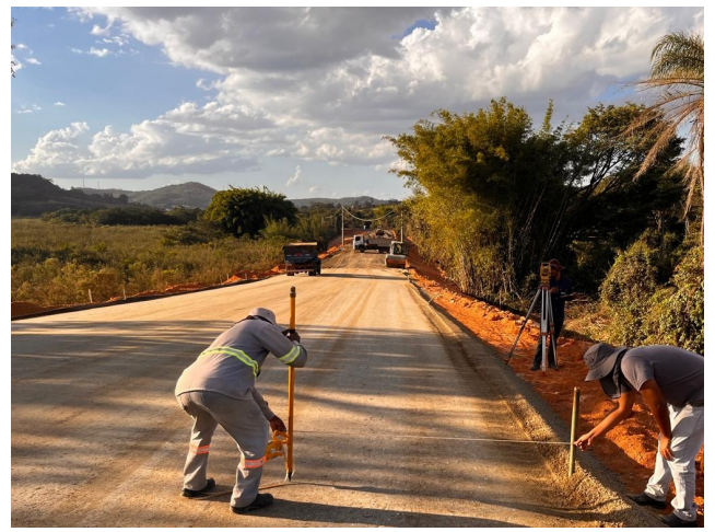
Foto 150 – Confêrencia e nivelamento feito pela fiscalização
