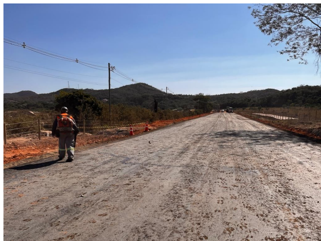
Foto 97 – Limpeza de base imprimada.
