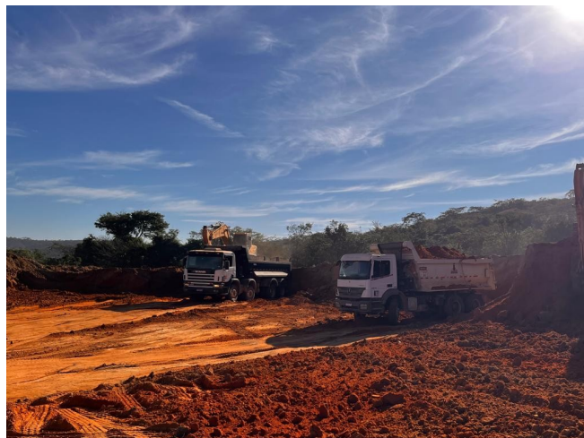
Foto 30 – Escavação vertical a céu aberto em material de 1ª categoria.
