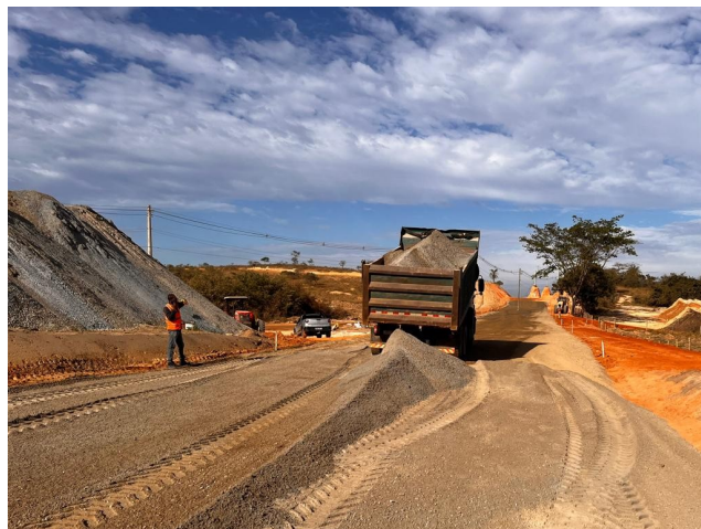
Foto 58 – Execução e compactação de base.
