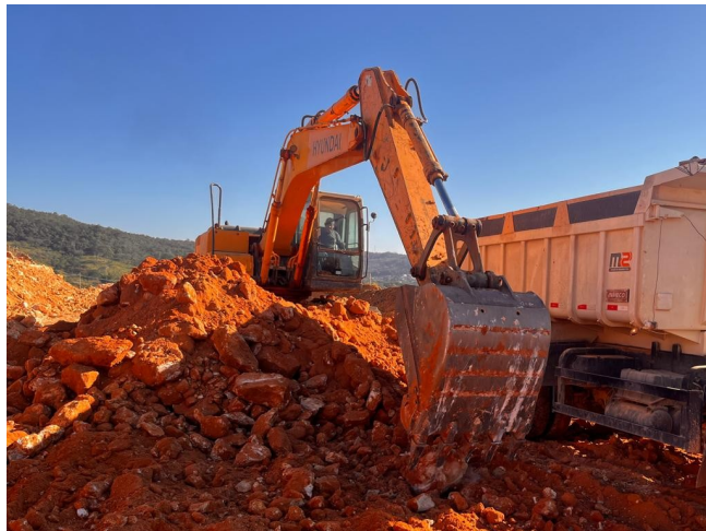
Foto 21 – Escavação, carga e transporte de material de 2ª categoria.
