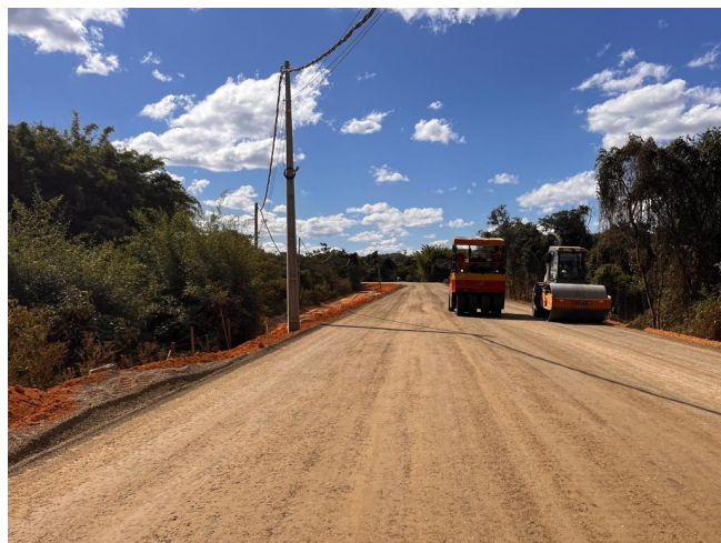
Foto 169 – Execução e compactação de base.
