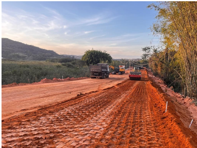
Foto 73 – Regularização e compactação de subleito. (Pista de caminhada)
