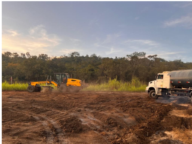
Foto 45 – Execução e compactação de aterro.
