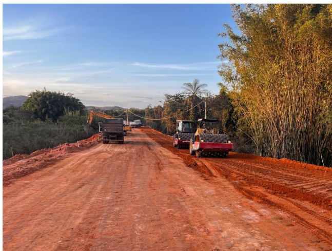
Foto 75 – Regularização e compactação de subleito. (Pista de caminhada)
