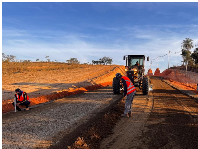
Foto 41 – Execução e compactação de sub-base.
