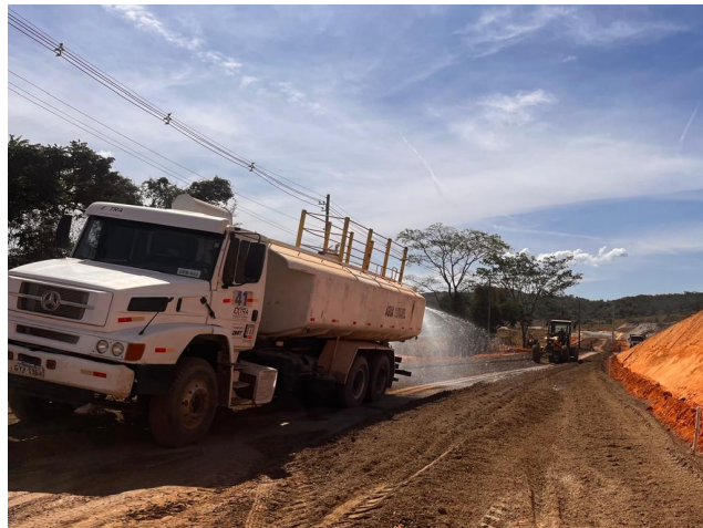
Foto 38 – Execução e compactação de sub-base.
