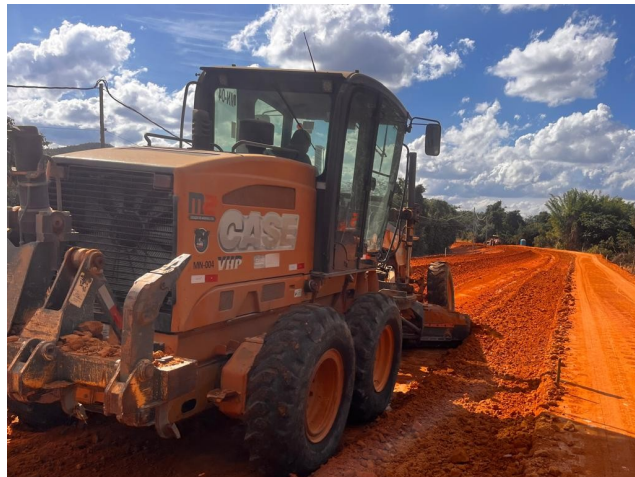
Foto 82 – Regularização e compactação de subleito.
