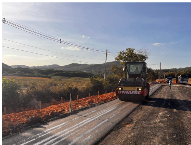
Foto 102 – Execução de pavimento com aplicação de concreto asfáltico. (Pista de Caminhada).
