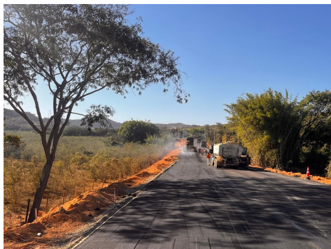
Foto 197 – Execução de pavimento com aplicação de concreto asfáltico.
