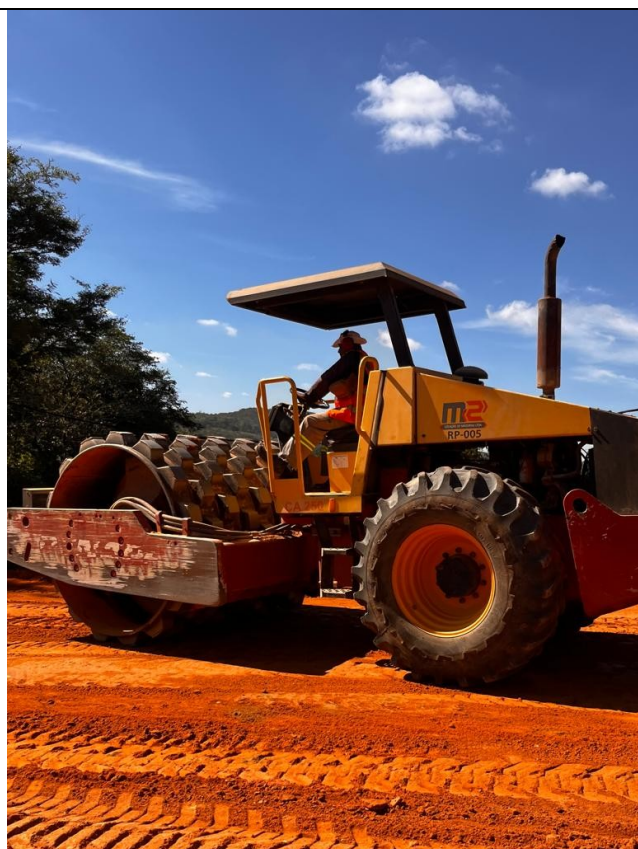
Foto 32 – Execução de camada final de aterro.
