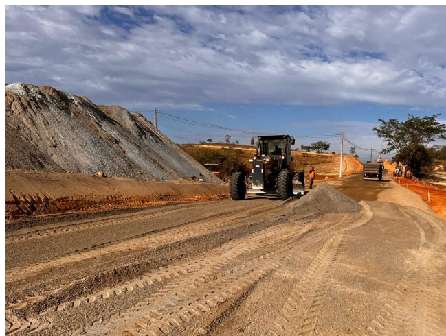
Foto 59 – Execução e compactação de base.
