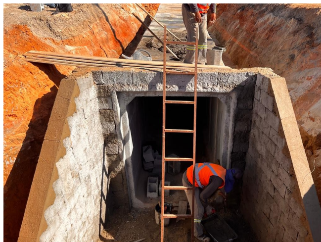
Foto 165 – Execução de ala pra passa gado
