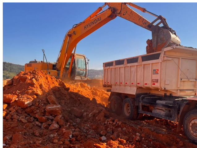
Foto 22 – Escavação, carga e transporte de material de 2ª categoria.
