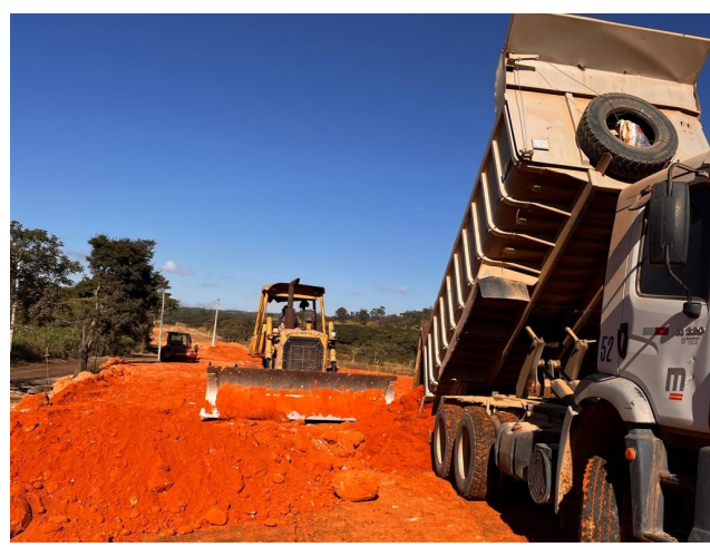
Foto 164 – Execução de camada final de aterro.
