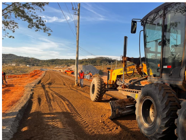
Foto 43 - Execução e compactação de sub-base.
