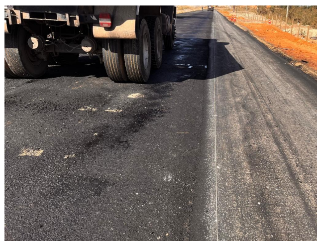
Foto 106 – Execução de pavimento com aplicação de concreto asfáltico. (Pista).
