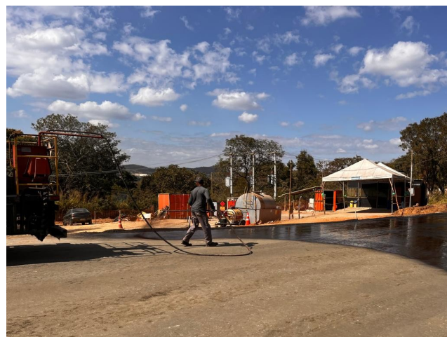
Foto 142 - Imprimação (Execução e Fornecimento do Material betuminoso).
