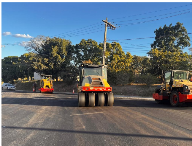
Foto 175 – Execução de pavimento com aplicação de concreto asfáltico.
