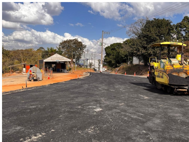
Foto 145 – Salgamento de Via
