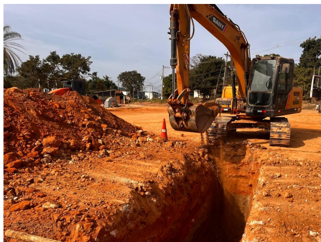
Foto 55 – Escavação para execução de rede de tubo de concreto DN 800 mm..
