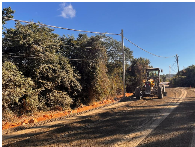
Foto 159 – Execução e compactação de base.
