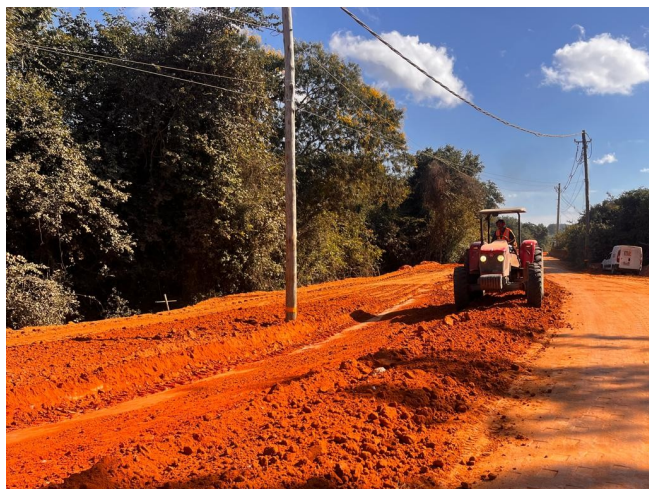
Foto 25 – Execução de camada final de aterro.
