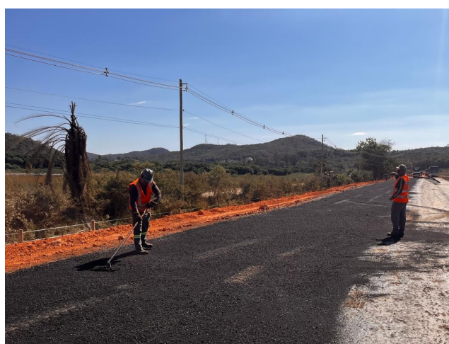
Foto 100 – Salgamento de via.
