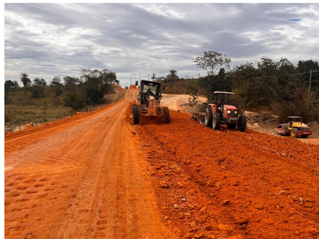
Foto 72 – Execução de camada final de aterro.
