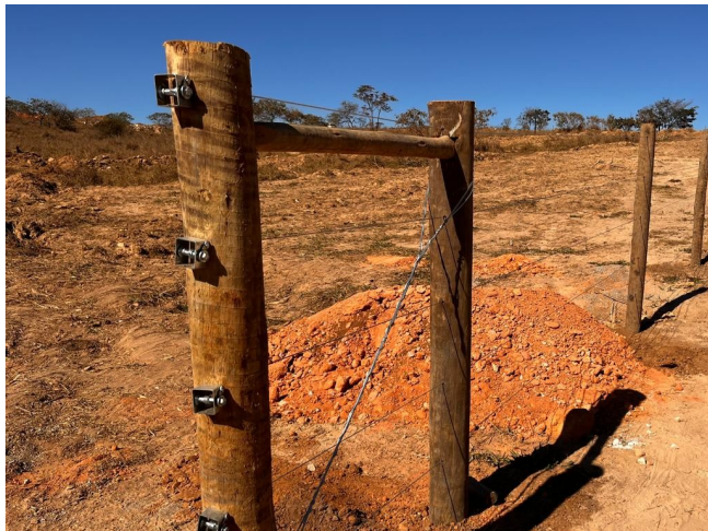
Foto 177 – Remoção e execução de cerca
