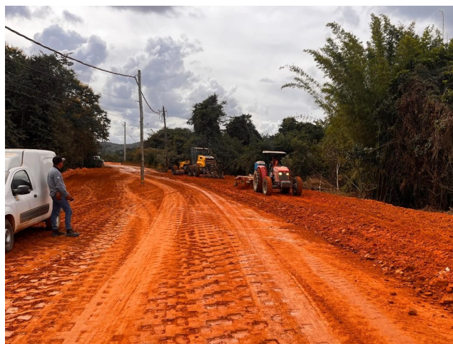
Foto 28 – Execução de camada final de aterro.
