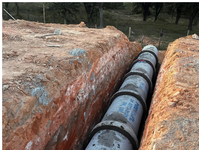
Foto 77 – Tubo de concreto DN 800 mm.
