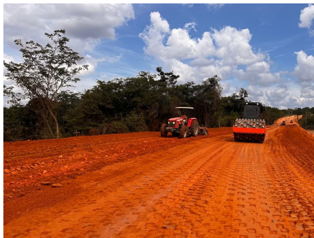
Foto 27- Execução de camada final de aterro.
