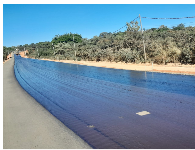
Foto 180 – Imprimação (Execução e Fornecimento do Material betuminoso).
