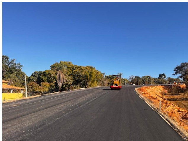
Foto 196 – Execução de pavimento com aplicação de concreto asfáltico.
