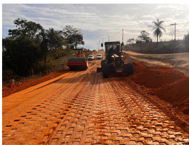
Foto 52 – Execução e compactação de aterro com solo predominantemente argiloso.
