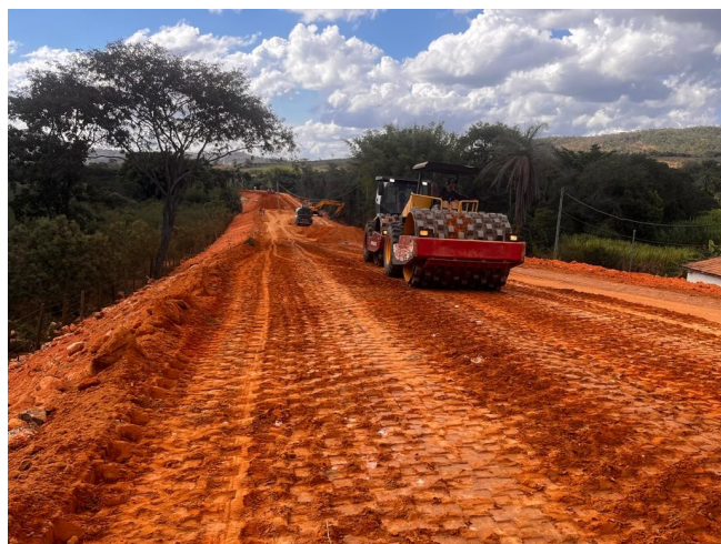
Foto 87 – Execução de camada final de aterro.
