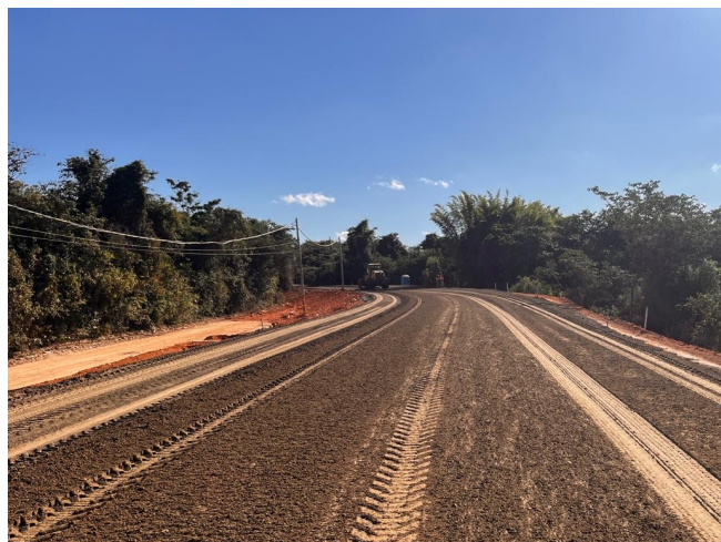
Foto 157 – Execução e compactação de base.
