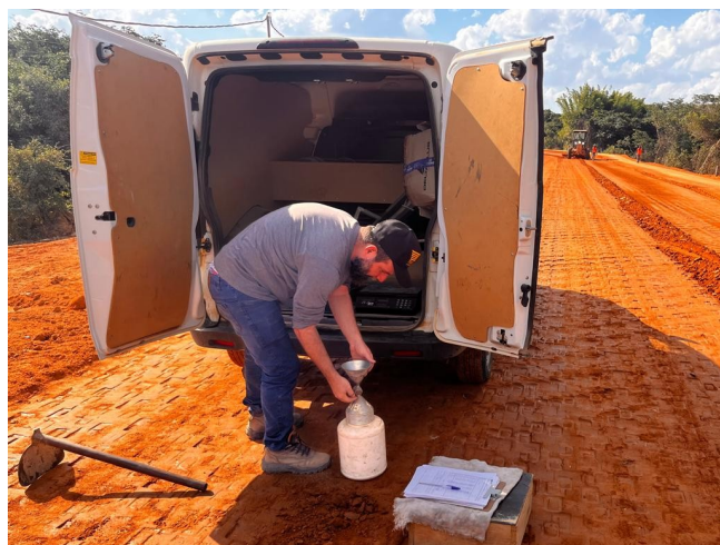
Foto 95 – Liberação camada de subleito.
