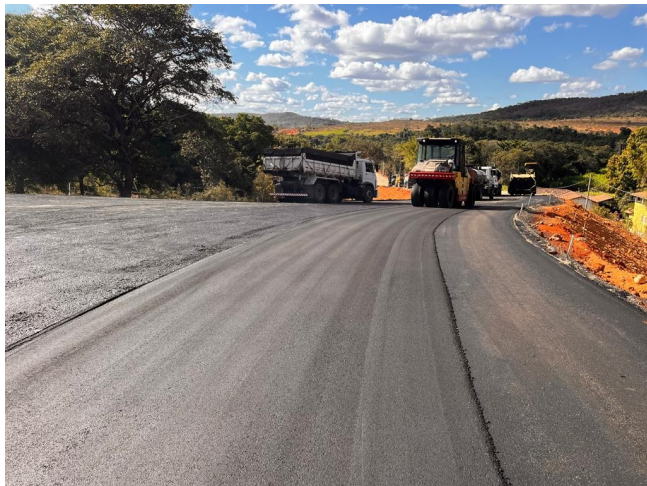
Foto 173 – Execução de pavimento com aplicação de concreto asfáltico.
