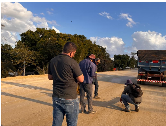
Foto 135 – Execução e compactação base.
