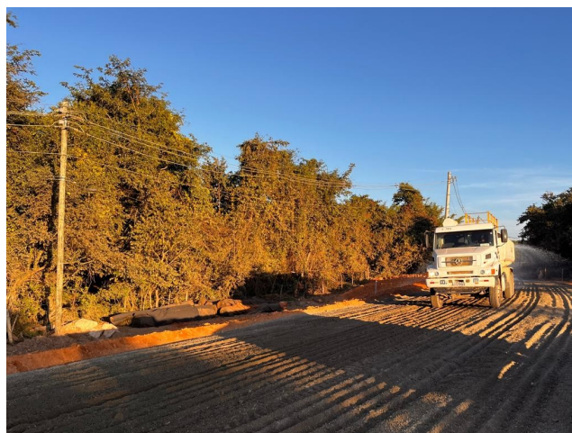
Foto 134 – Execução e compactação de sub-base.
