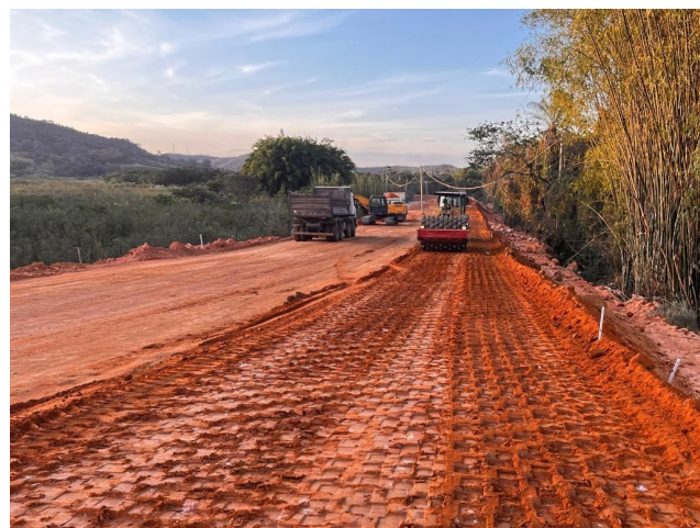
Foto 74 – Regularização e compactação de subleito. - (Pista de caminhada).
