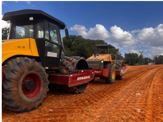
Foto 85 – Execução de camada final de aterro.
