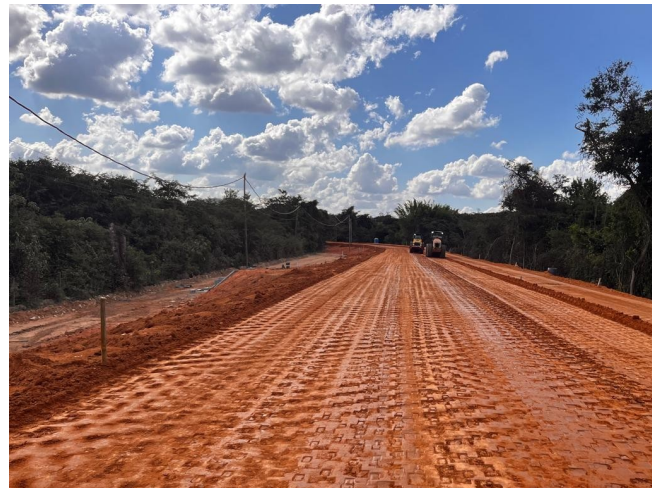
Foto 94 – Regularização e compactação de subleito.
