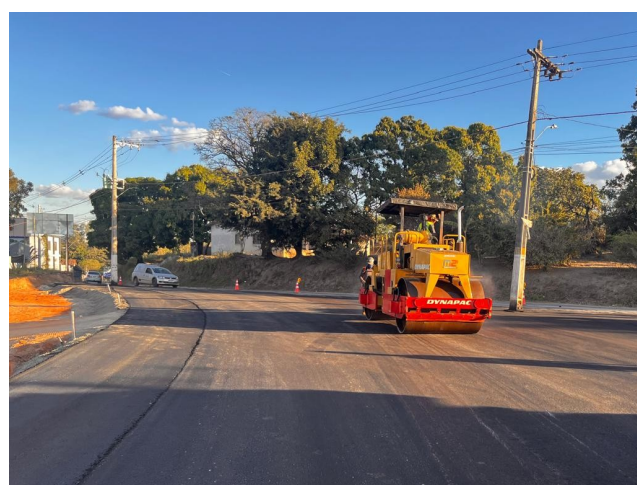
Foto 176 – Execução de pavimento com aplicação de concreto asfáltico.
