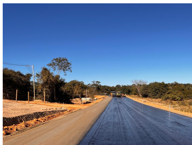
Foto 192 – Imprimação (Execução e Fornecimento do Material betuminoso).
