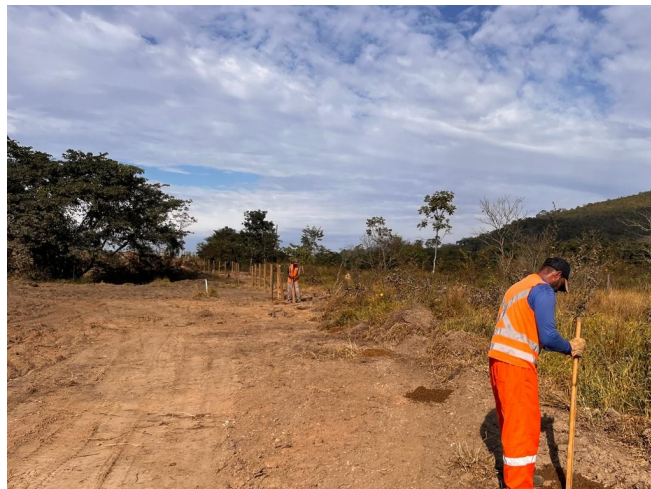
Foto 66 – Execução e remoção de cercas e mourões.
