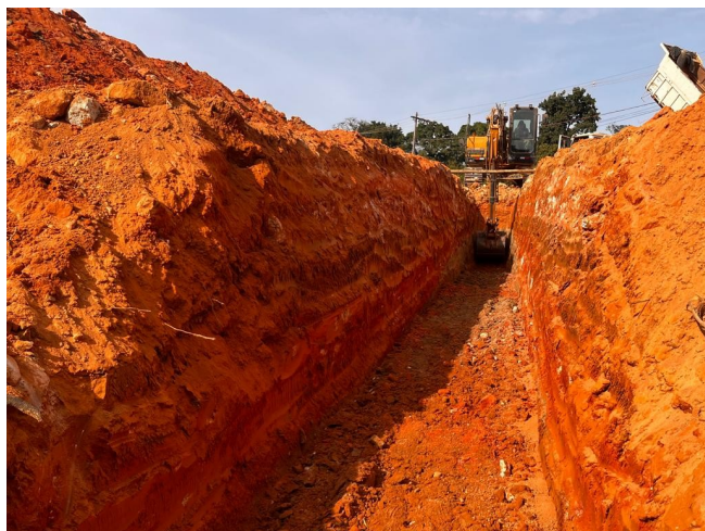
Foto 53 – Escavação para execução de rede de tubo de concreto DN 800 mm.
