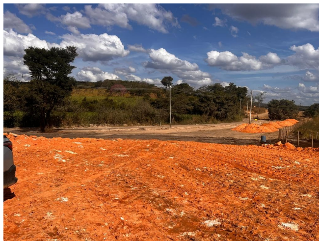
Foto 79 – Execução e compactação de aterro.
