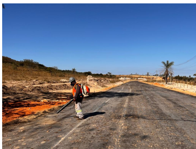
Foto 98 – Limpeza de base imprimada.
