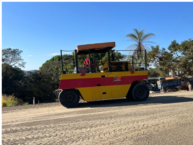
Foto 137 – Execução e compactação base.
