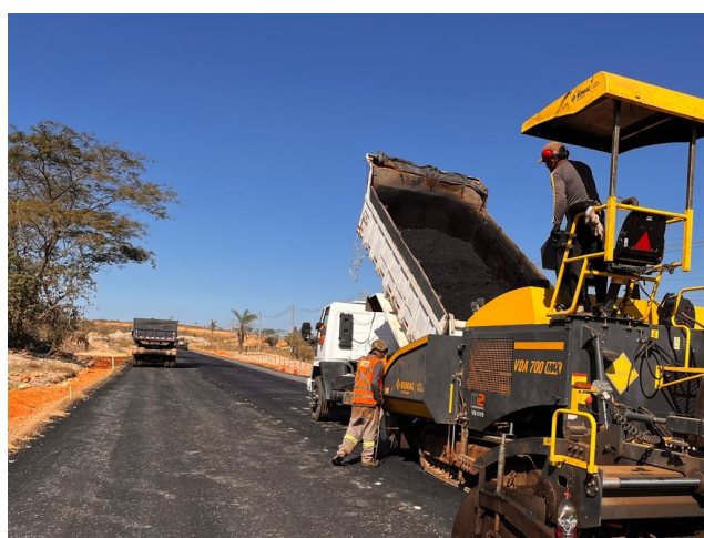
Foto 104 – Execução de pavimento com aplicação de concreto asfáltico. (Pista).
