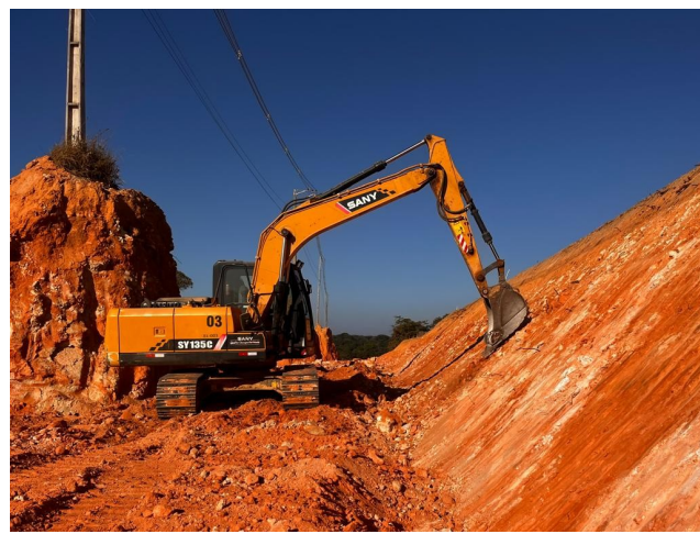
Foto 18 – Execução de rampa 1x1.
