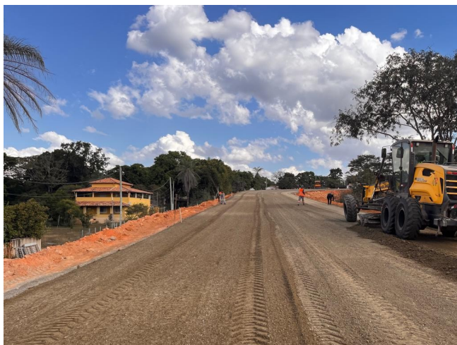
Foto 143 - Execução e compactação base.
