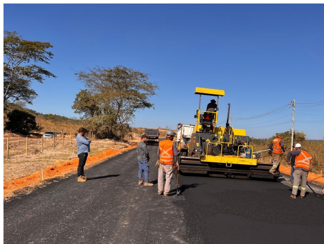
Foto 105 – Execução de pavimento com aplicação de concreto asfáltico. (Pista).
