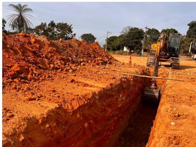
Foto 54 – Escavação para execução de rede de tubo de concreto DN 800 mm.
