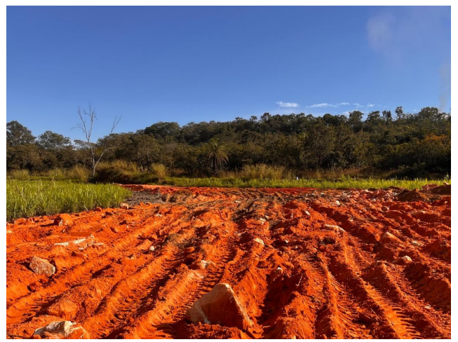
Foto 62 – Execução e compactação de aterro.
