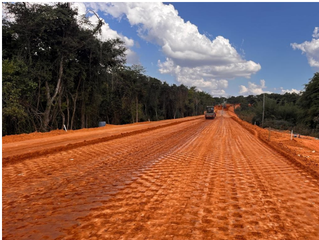
Foto 93 – Regularização e compactação de subleito.
