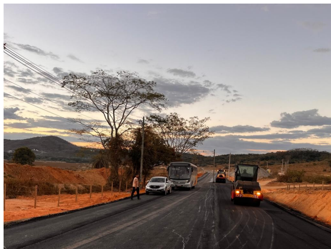
Foto 203 – Execução de pavimento com aplicação de concreto asfáltico.
