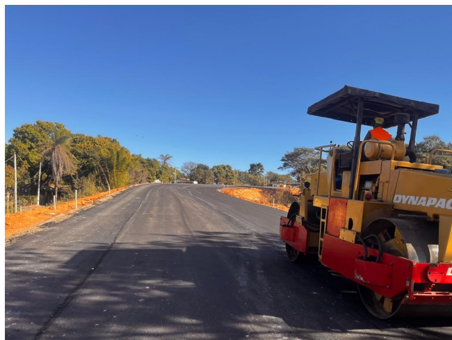
Foto 195 – Execução de pavimento com aplicação de concreto asfáltico.
