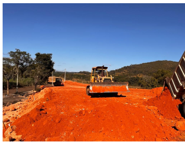
Foto 162 – Execução de camada final de aterro.
