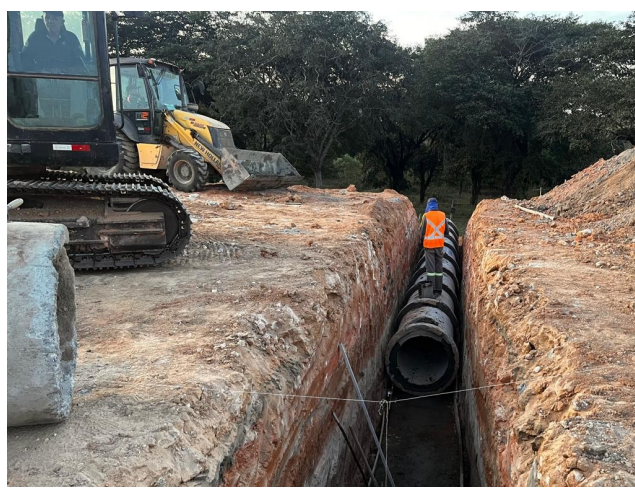
Foto 78 – Tubo de concreto DN 800 mm.
