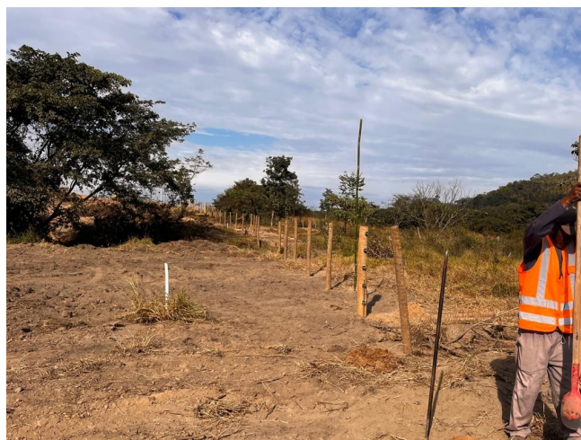
Foto 63 – Execução e remoção de cercas e mourões.
