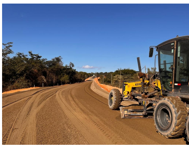
Foto 160 – Execução e compactação de base.
