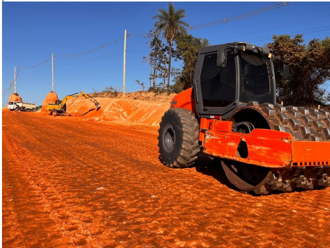
Foto 10 – Regularização e compactação de subleito.
