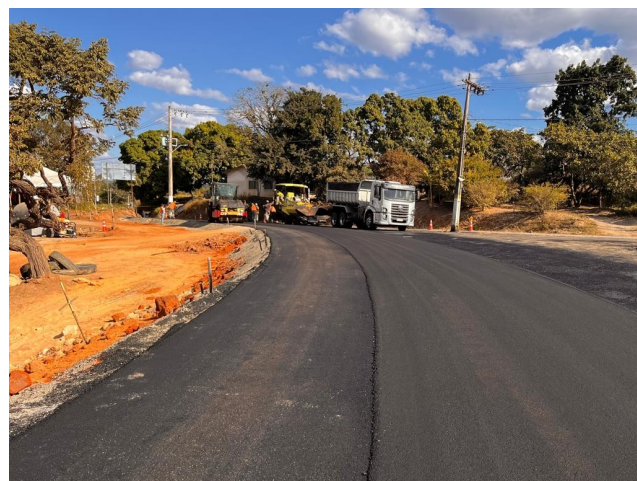
Foto 174 – Execução de pavimento com aplicação de concreto asfáltico.
