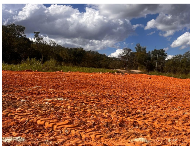
Foto 80 – Execução e compactação de aterro.
