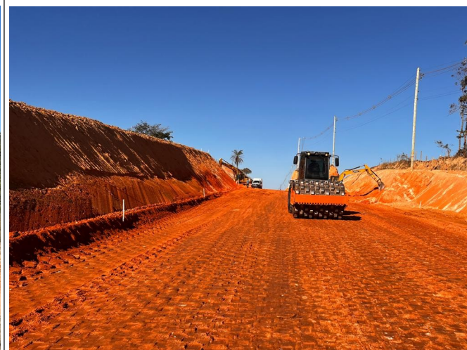
Foto 08 – Regularização e compactação de subleito.
