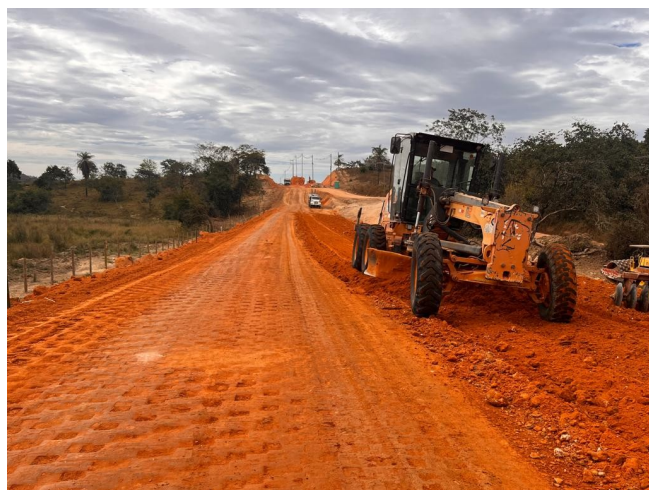
Foto 71 – Execução de camada final de aterro.
