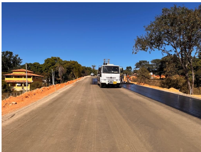
Foto 179 – Imprimação (Execução e Fornecimento do Material betuminoso).
