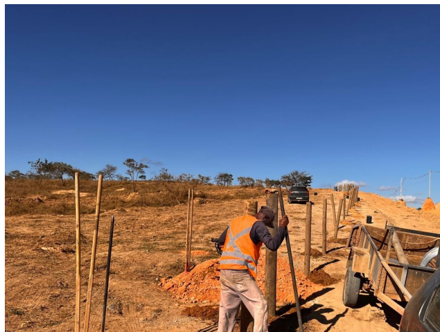
Foto 166 – Remoção e execução de cerca
