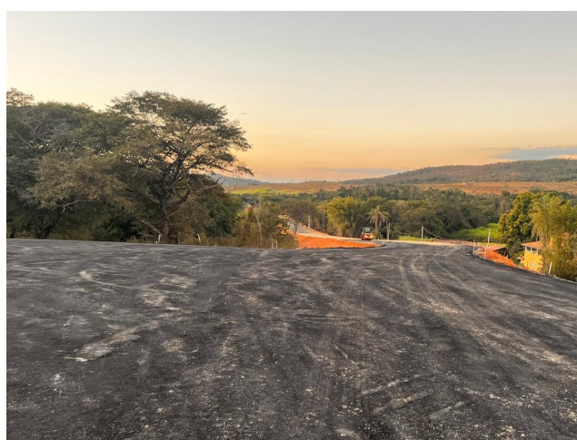
Foto 148 – Salgamento de Via
