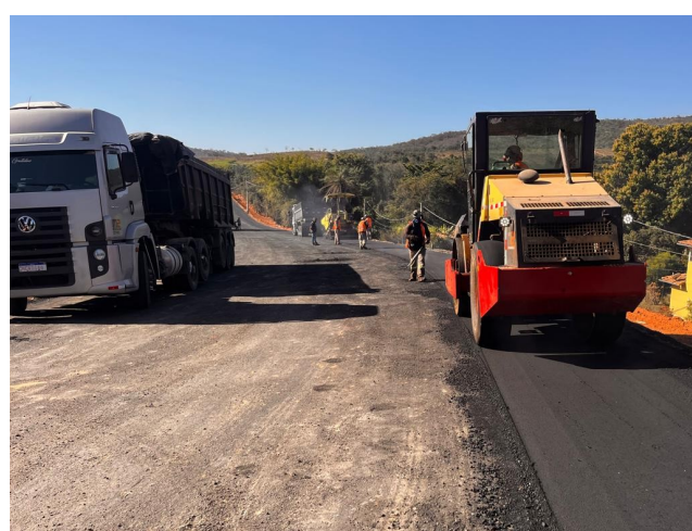
Foto 194 – Execução de pavimento com aplicação de concreto asfáltico.
