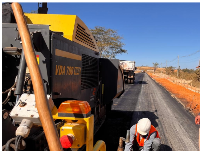
Foto 107 – Execução de pavimento com aplicação de concreto asfáltico. (Pista).
