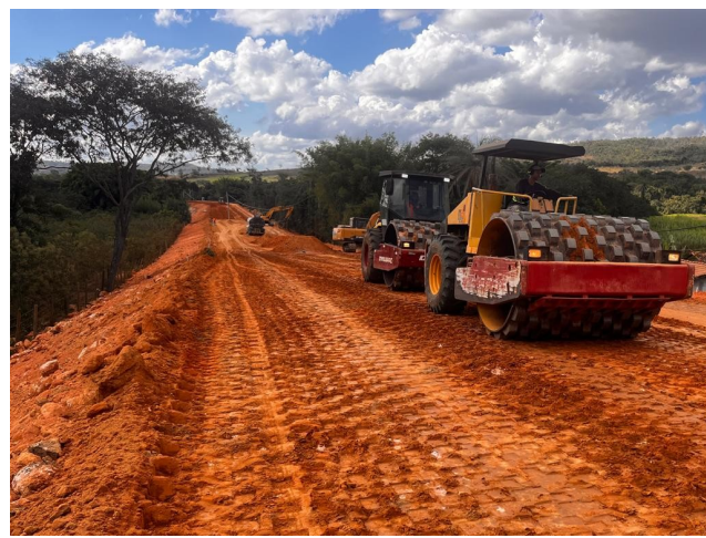
Foto 86 – Execução de camada final de aterro.
