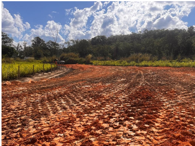
Foto 81 – Execução e compactação de aterro.
