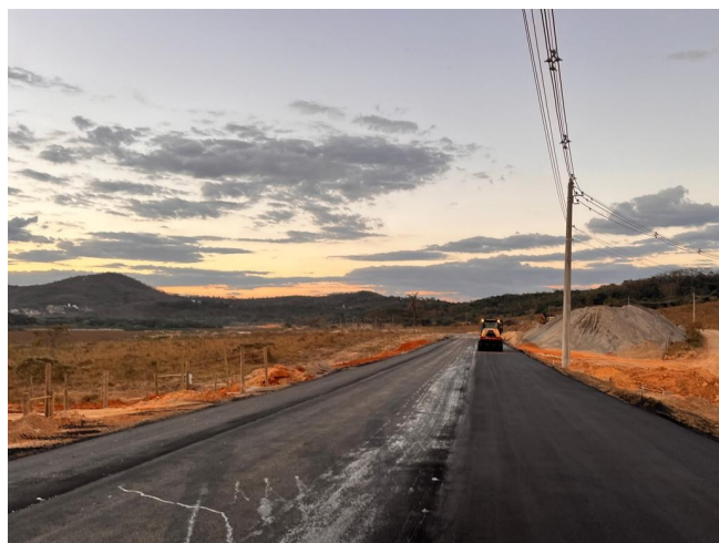
Foto 205 – Execução de pavimento com aplicação de concreto asfáltico.
