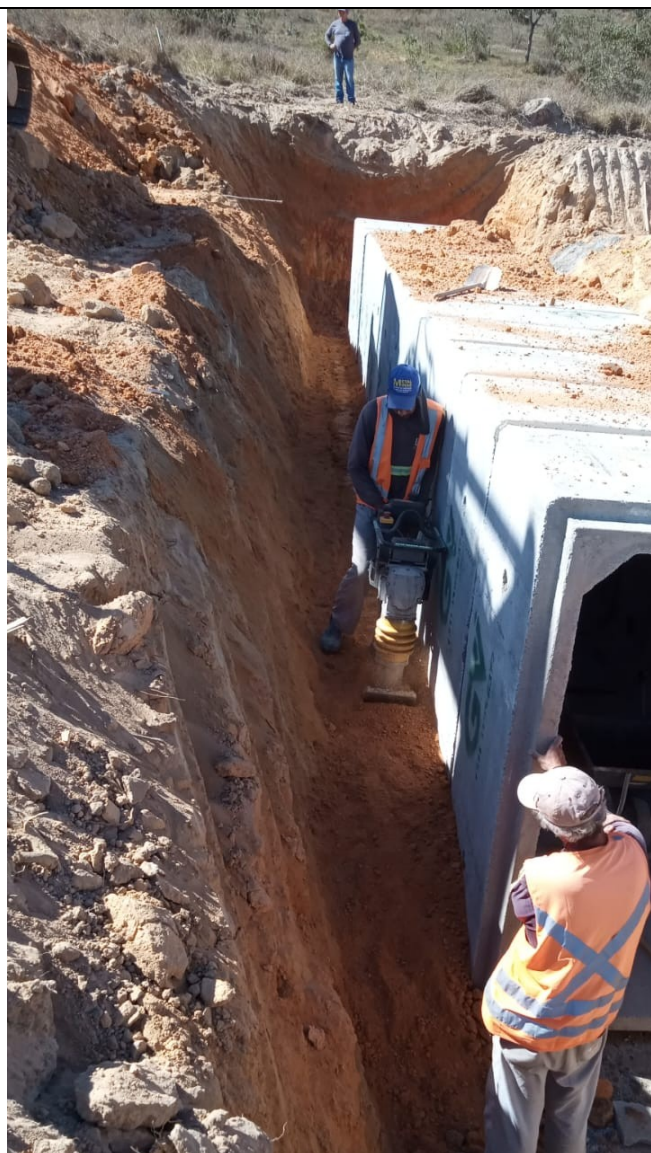
Foto 185 – Execução de Passa gado.
