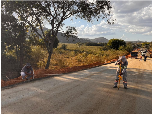
Foto 149 – Confêrencia e nivelamento feito pela fiscalização
