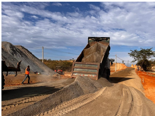
Foto 57 – Execução e compactação de base.
