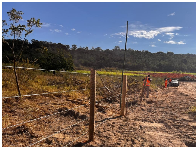
Foto 65 – Execução e remoção de cercas e mourões.
