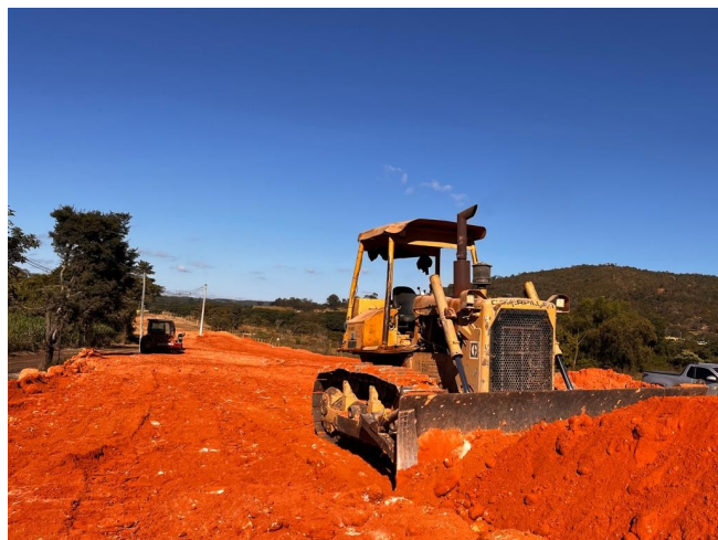
Foto 161 – Execução de camada final de aterro.
