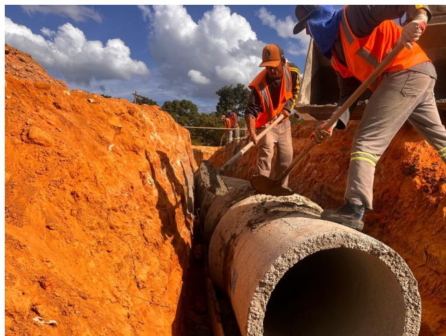
Foto 89 – Execução de contra-berço.
