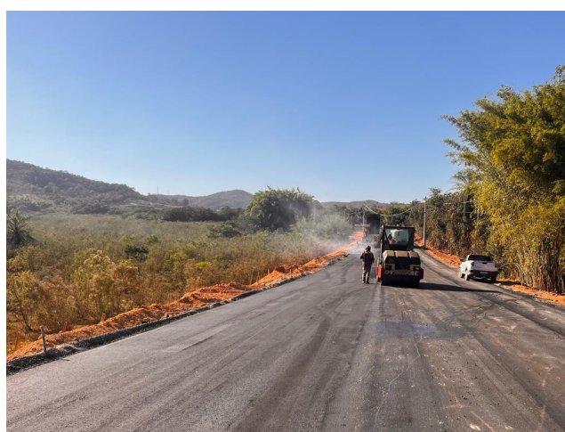
Foto 198 – Execução de pavimento com aplicação de concreto asfáltico.
