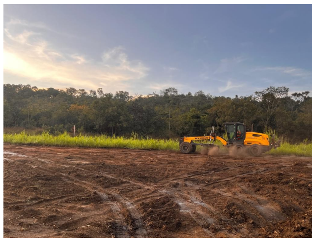
Foto 46 – Execução e compactação de aterro.
