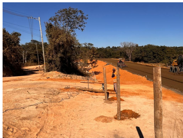
Foto 178 – Remoção e execução de cerca
