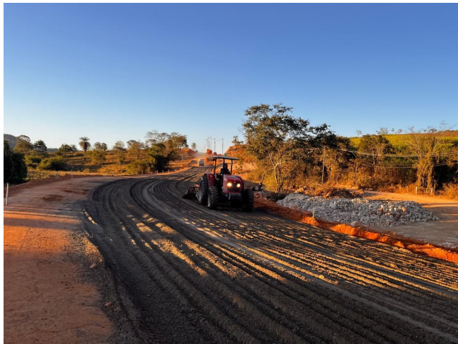
Foto 133 – Execução e compactação de sub-base.
