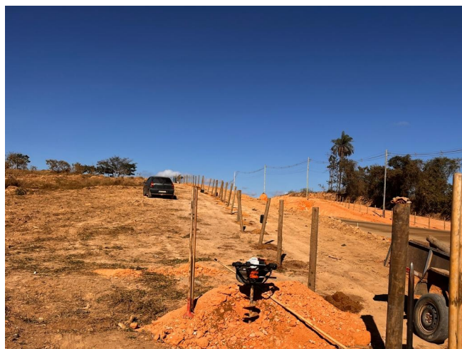
Foto 167 – Remoção e execução de cerca
