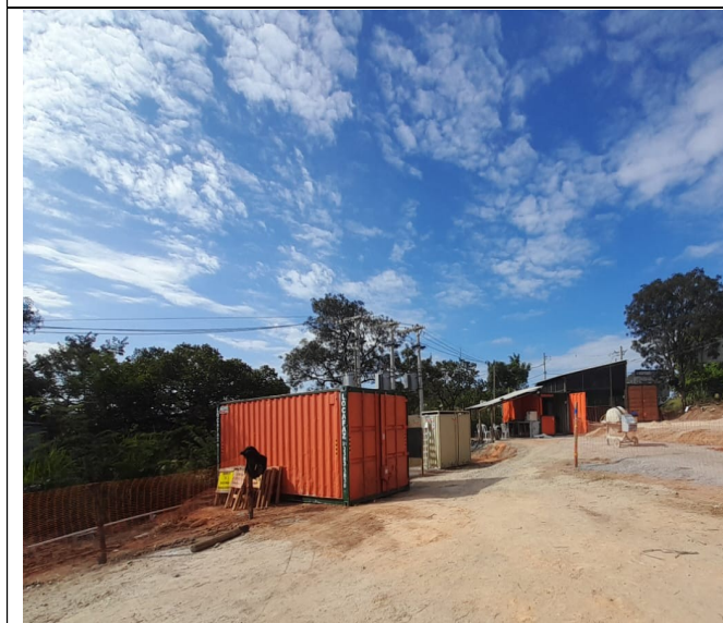
Foto 03 – Locação de Container.
