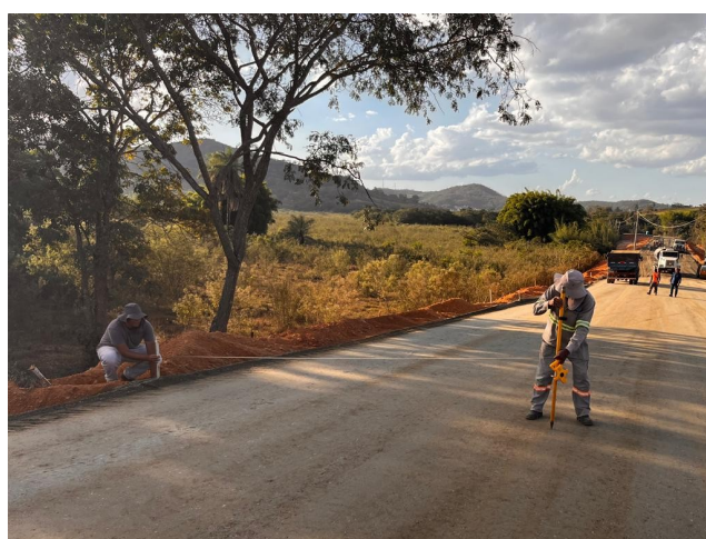
Foto 136 – Execução e compactação base.
