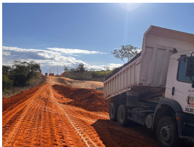
Foto 56 – Execução de camada final de aterro..
