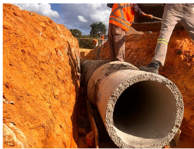
Foto 90 – Execução de contra-berço.
