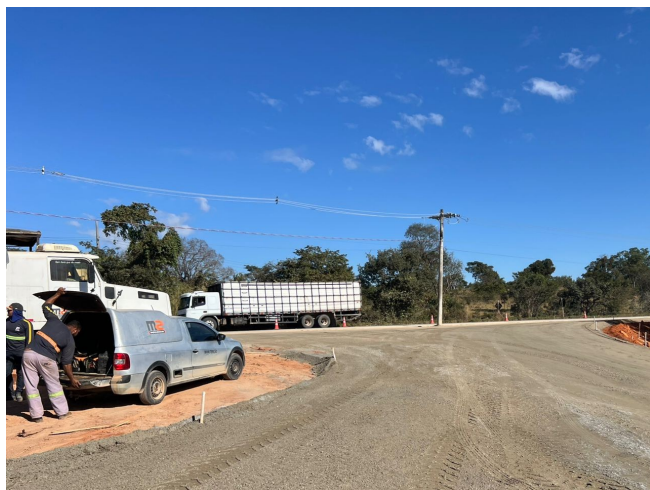
Foto 139 – Execução e compactação base.
