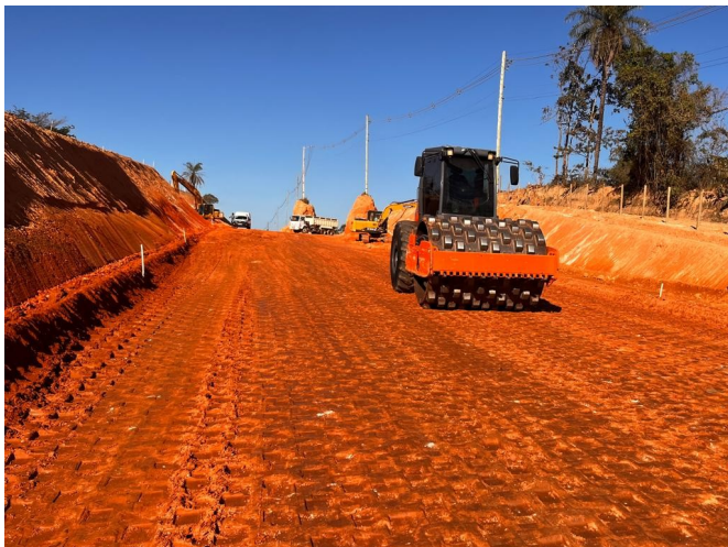
Foto 09 – Regularização e compactação de subleito.
