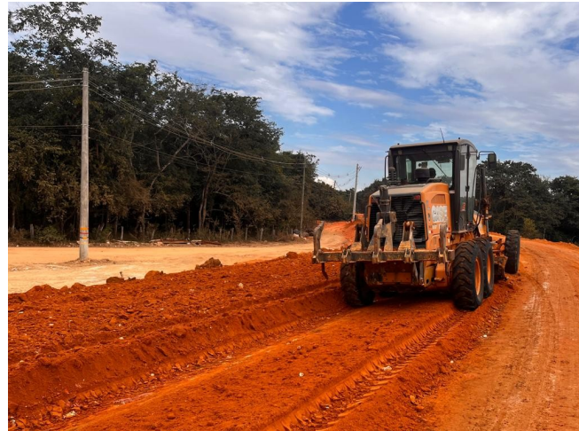
Foto 70 – Execução de camada final de aterro.
