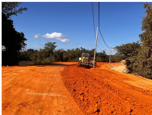
Foto 23 – Execução de camada final de aterro.
