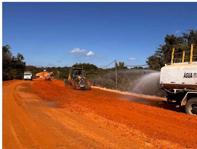
Foto 26 – Execução de camada final de aterro.
