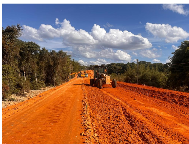
Foto 84 – Regularização e compactação de subleito.
