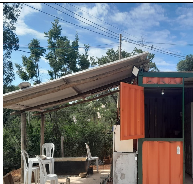
Foto 05 – Locação de Container.
