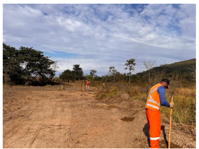
Foto 64 – Execução e remoção de cercas e mourões.
