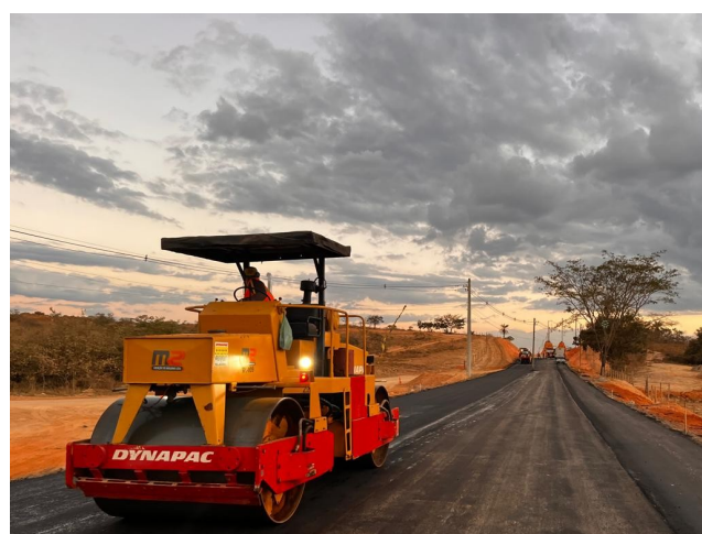
Foto 206 – Execução de pavimento com aplicação de concreto asfáltico.
