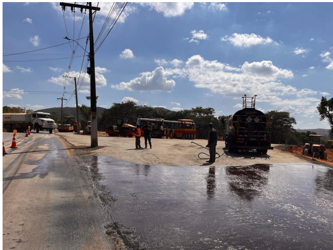
Foto 141 – Imprimação (Execução e Fornecimento do Material betuminoso).
