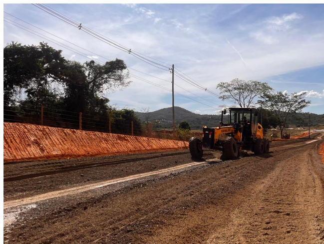
Foto 39 – Execução e compactação de sub-base.
