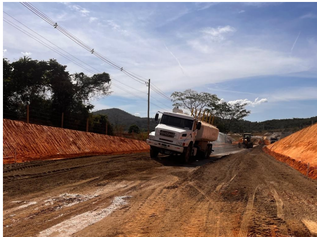
Foto 37 – Execução e compactação de sub-base.
