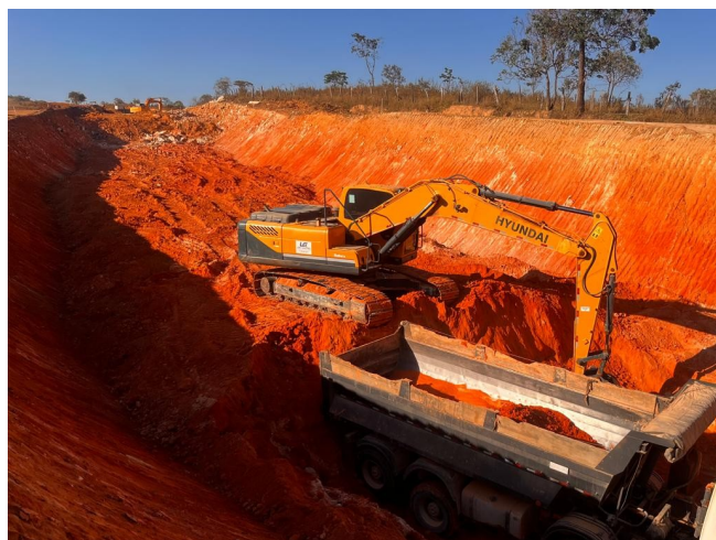
Foto 19 – Escavação, carga e transporte de material de 2ª categoria.
