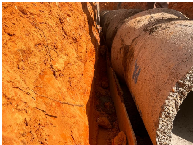
Foto 91 – Execução de contra-berço.
