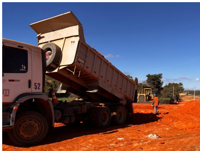
Foto 163 – Execução de camada final de aterro.
