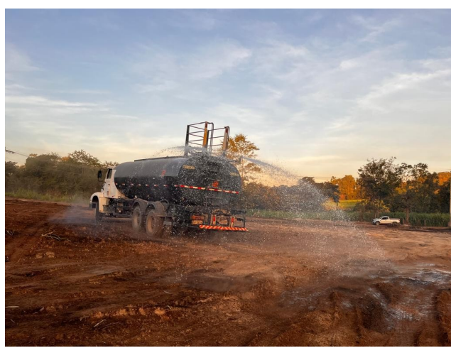
Foto 48 – Execução e compactação de aterro
