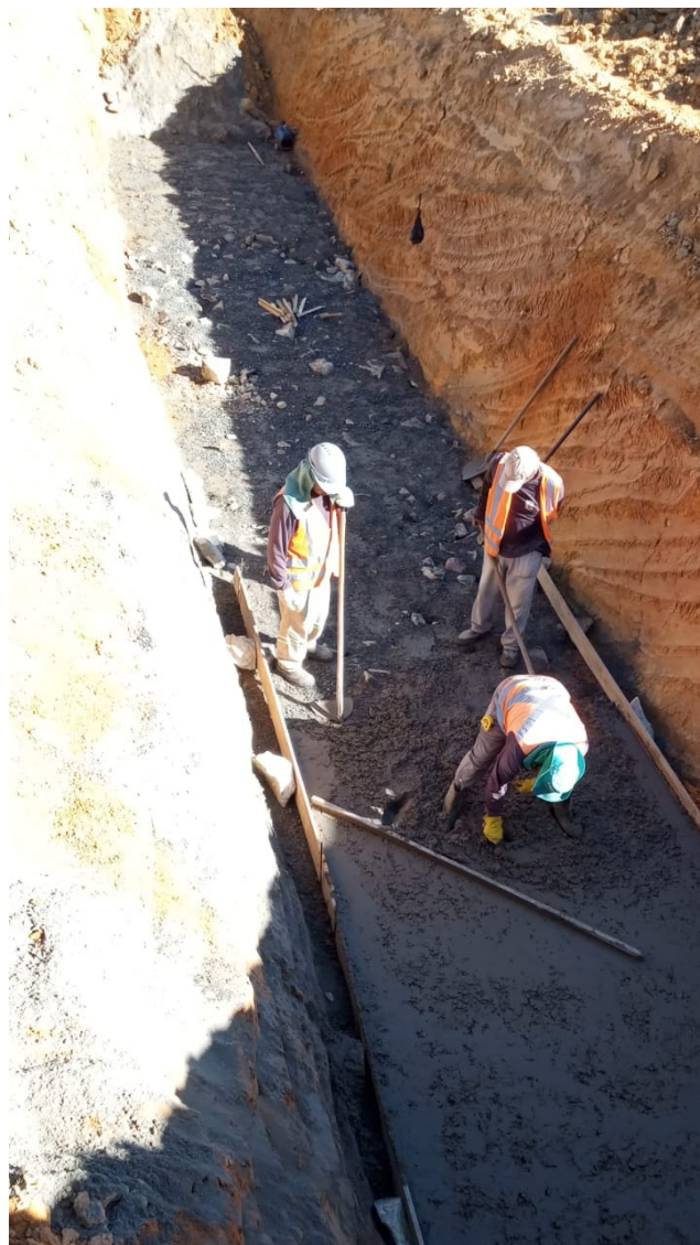
Foto 154 – Lastro de concreto para execução de passa gado
