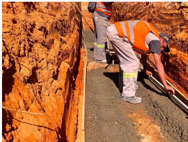
Foto 68 – Forma e concreto para berço tubular.
