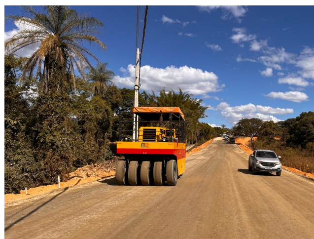
Foto 170 – Execução e compactação de base.
