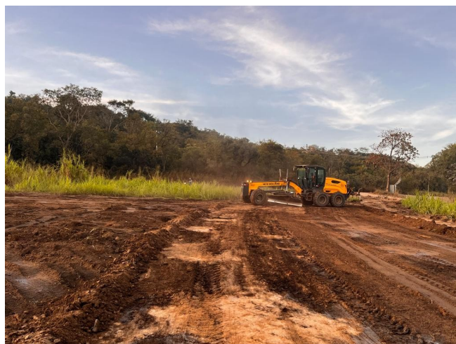
Foto 47 – Execução e compactação de aterro.
