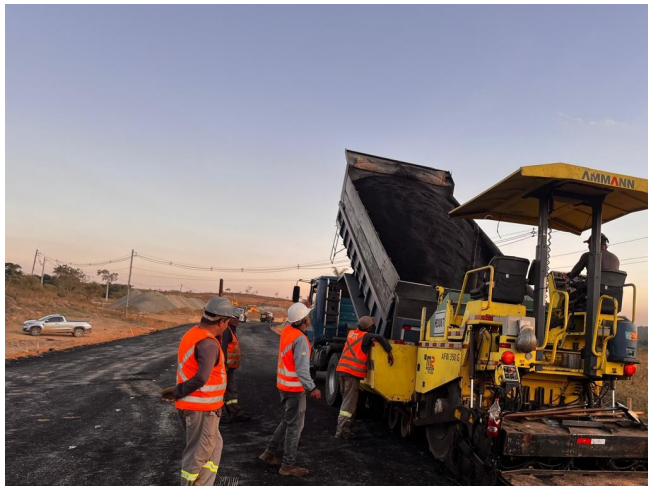
Foto 101 – Execução de pavimento com aplicação de concreto asfáltico. (Pista de Caminhada).
