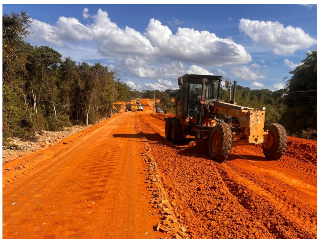
Foto 83 – Regularização e compactação de subleito.
