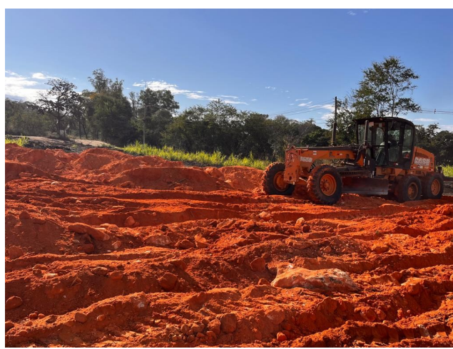
Foto 60 – Execução e compactação de aterro.
