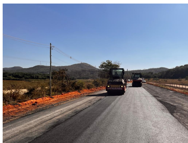
Foto 108 – Execução de pavimento com aplicação de concreto asfáltico. (Pista).
