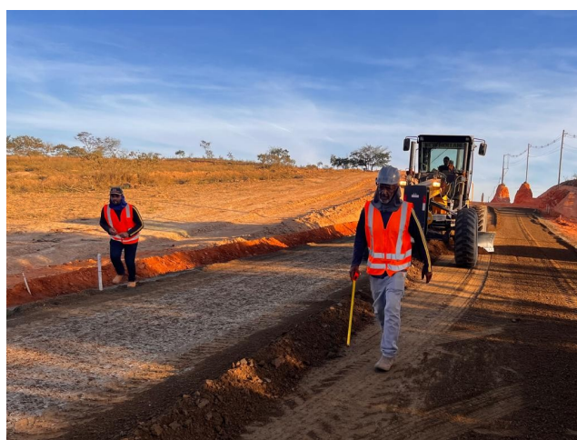
Foto 42 – Execução e compactação de sub-base.
