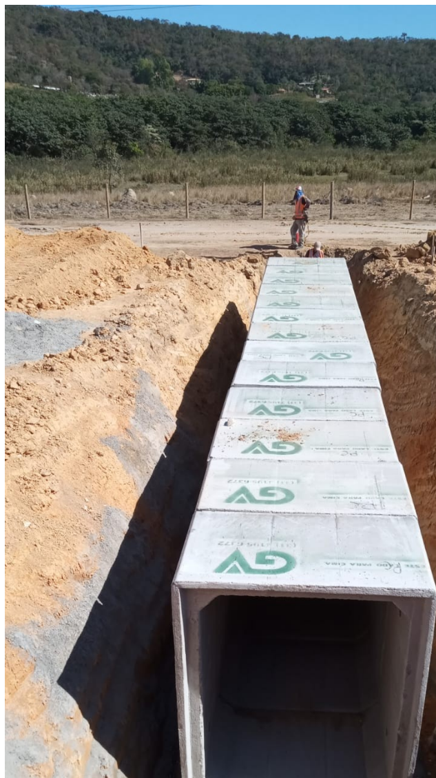
Foto 186 – Execução de Passa gado.
