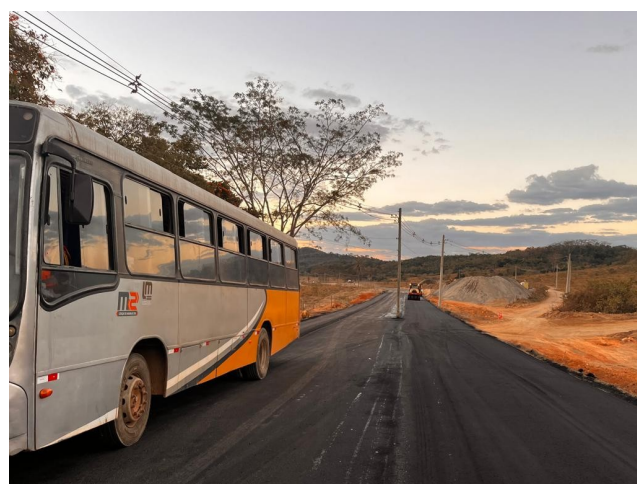
Foto 204 – Execução de pavimento com aplicação de concreto asfáltico.
