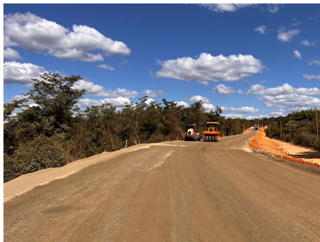
Foto 171 – Execução e compactação de base.
