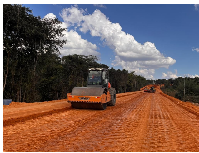
Foto 92 – Regularização e compactação de subleito.
