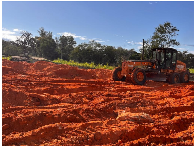
Foto 61 – Execução e compactação de aterro.
