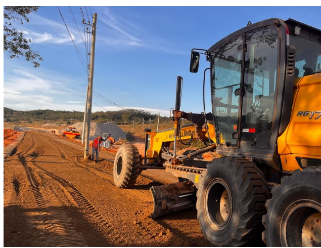
Foto 44 – Execução e compactação de sub-base.
