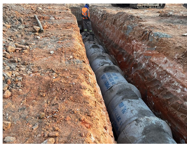
Foto 76 – Tubo de concreto DN 800 mm.
