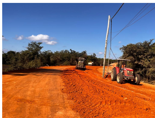
Foto 24 – Execução de camada final de aterro..
