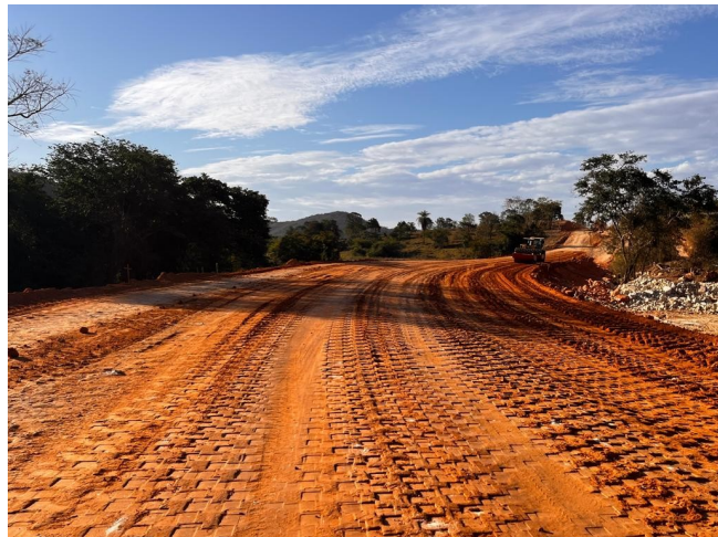
Foto 69 – Execução de camada final de aterro.
