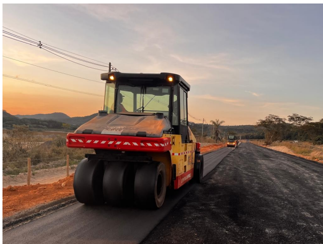
Foto 103 – Execução de pavimento com aplicação de concreto asfáltico. (Pista de Caminhada).
