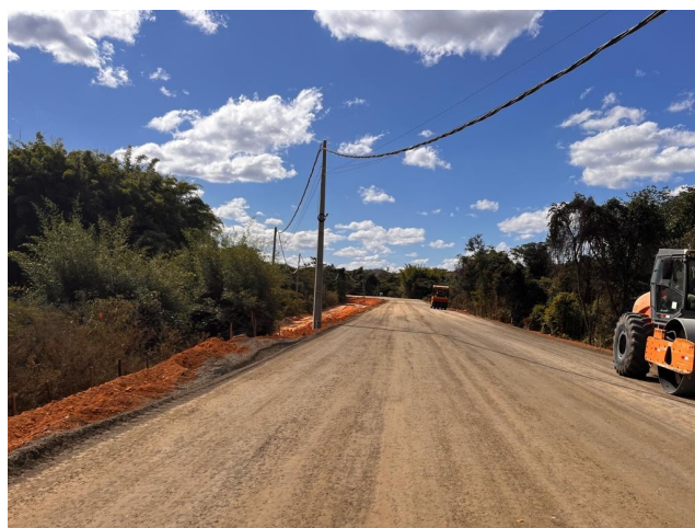
Foto 168 – Execução e compactação de base.
