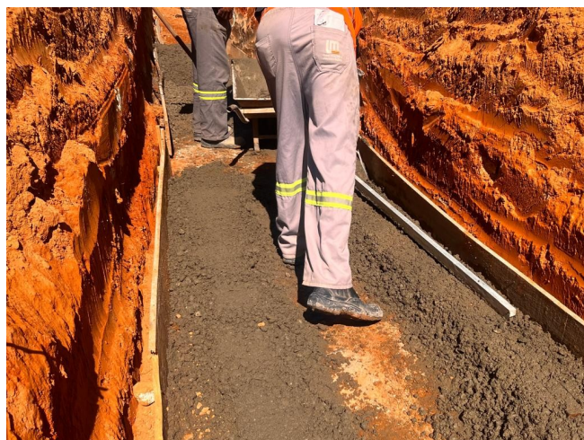
Foto 67 – Forma e concreto para berço tubular.
