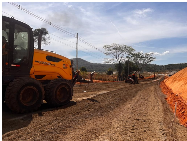
Foto 40 – Execução e compactação de sub-base.
