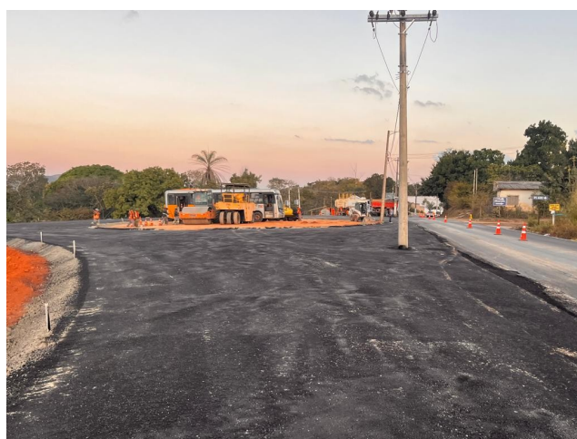
Foto 146 – Salgamento de Via
