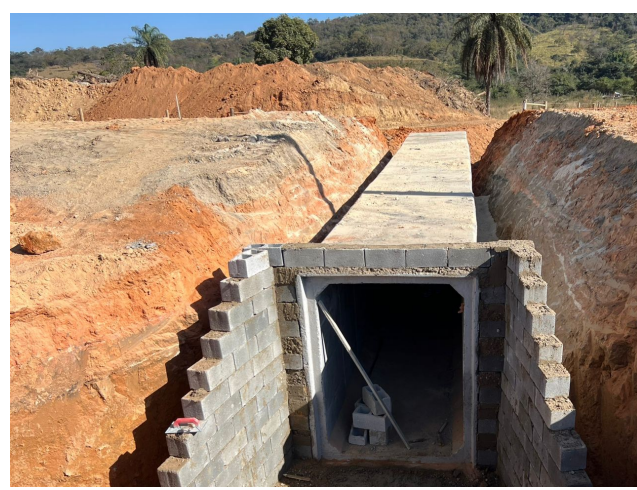
Foto 140 – Execução Ala para passa gado.
