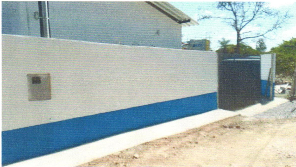
Figura 1 - Fachada da ETE
