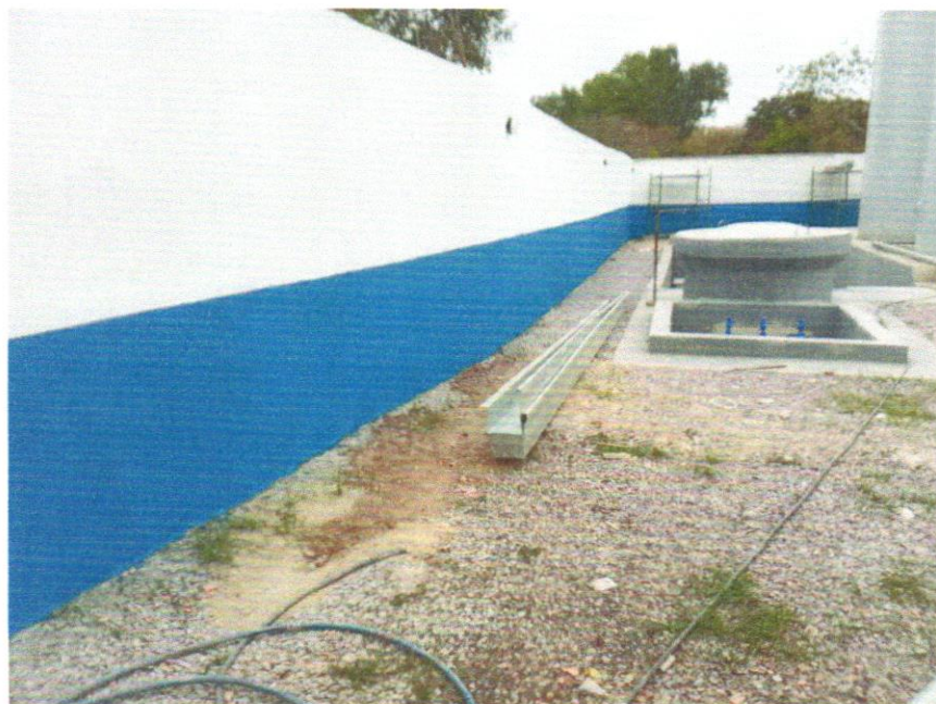
Figura 6 - Muro interno 3 e 4
