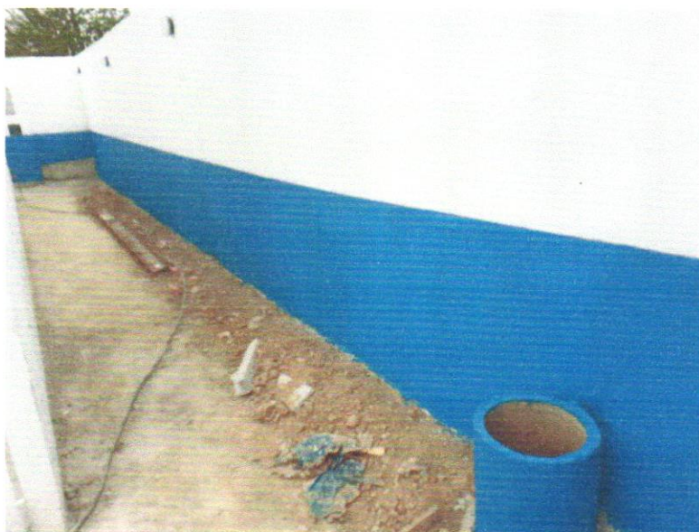
Figura 7 - Muro interno 3 - vista 2
