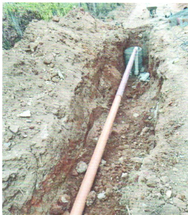
Figura 10 - Execução de rede de esgoto
