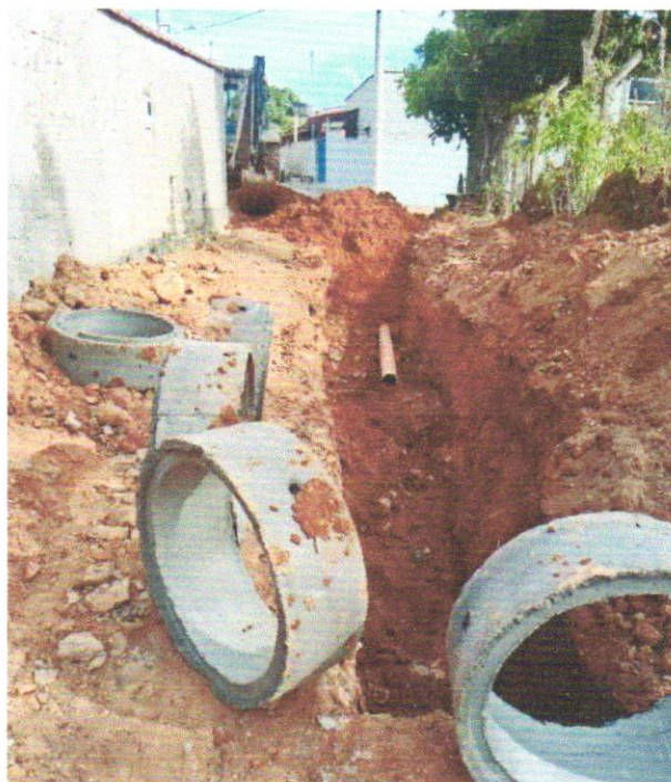
Figura 9 - Execução de rede de esgoto
