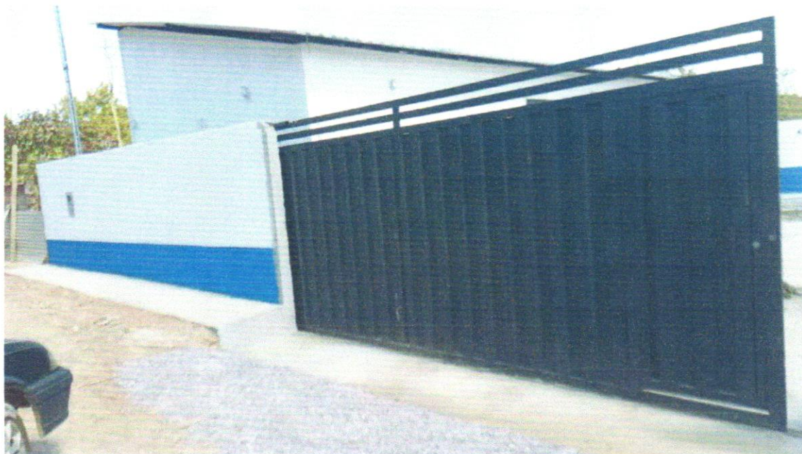
Figura 2 - Fachada da ETE vista 2
