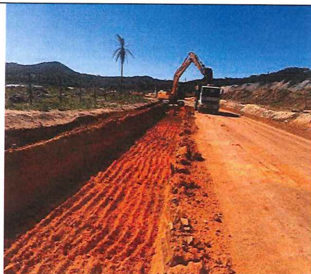
Foto 22 – Escavação mecânica em solo mole.
