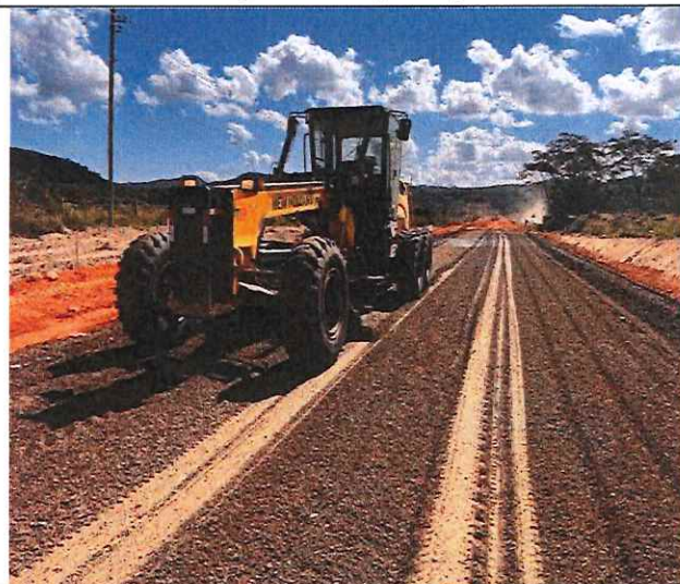
Foto 72 – Execução e compactação de sub-base.
