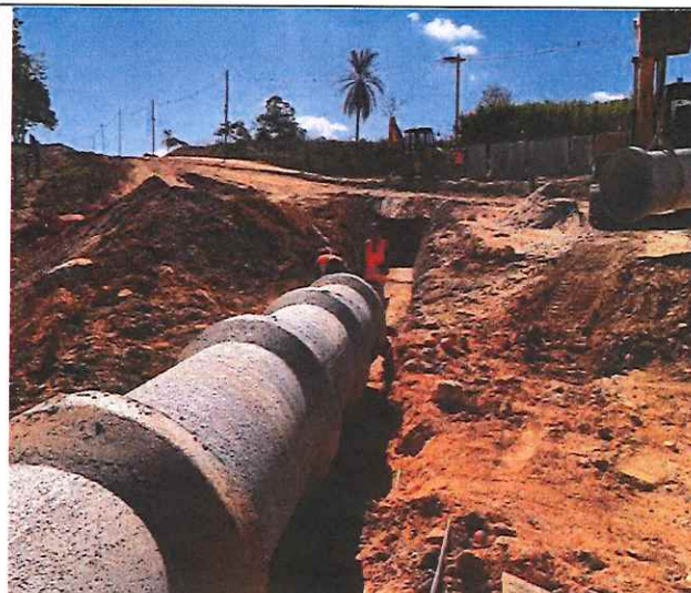
Foto 97 – Tubo de concreto DN 800 mm.
