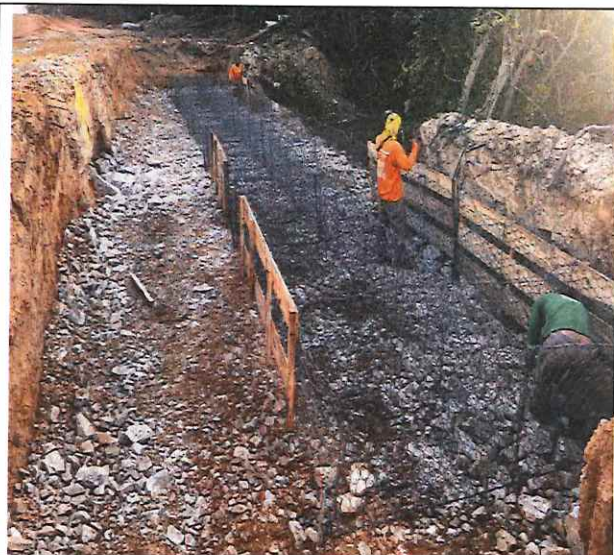
Foto 30 – Execução de arrimo em gabião tipo caixa.
