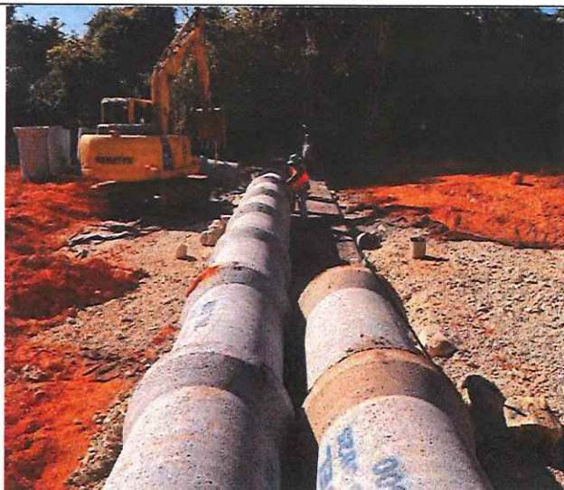
Foto 99 – Tubo de concreto duplo DN 800 mm.
