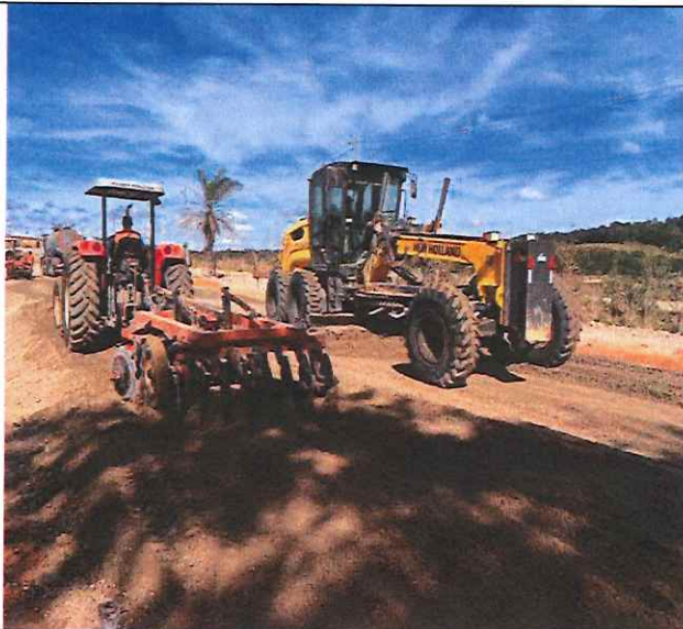
Foto 67 – Execução e compactação de sub-base.
