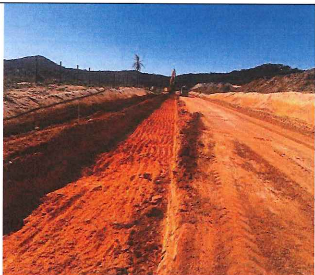
Foto 23 – Escavação mecânica em solo mole.
