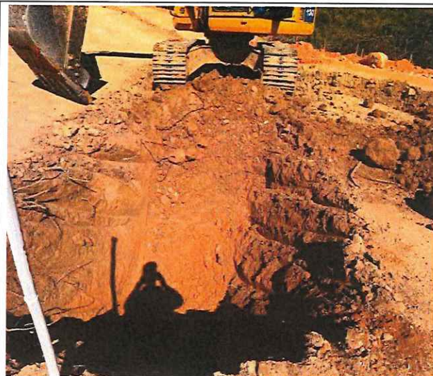
Foto 90 – Escavação mecanizada de vala.
