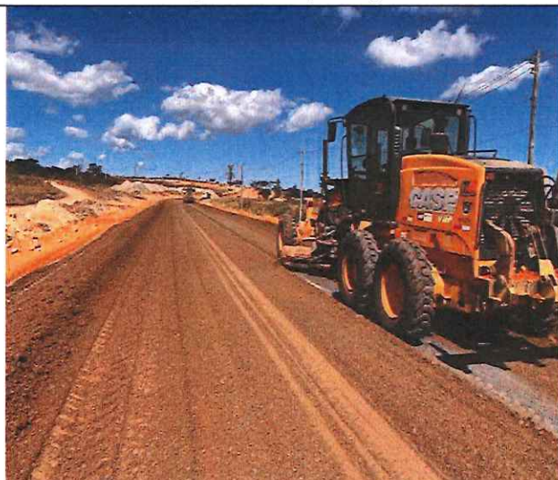
Foto 71 – Execução e compactação de sub-base.
