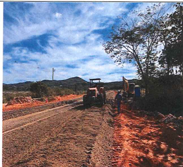
Foto 68 – Execução e compactação de sub-base.
