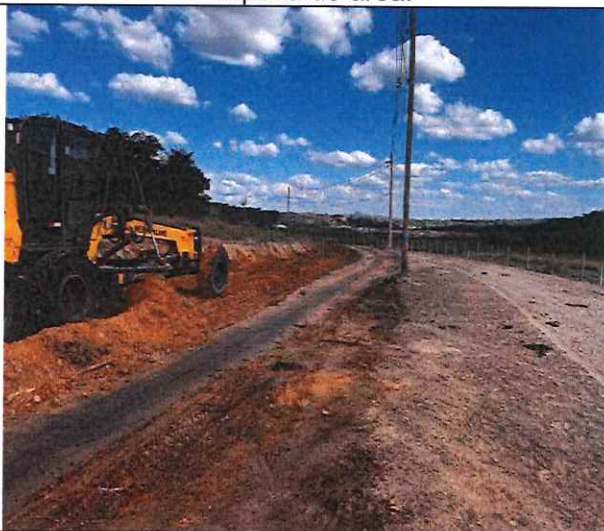
Foto 12 – Desmatamento, destocamento, limpeza de área.
