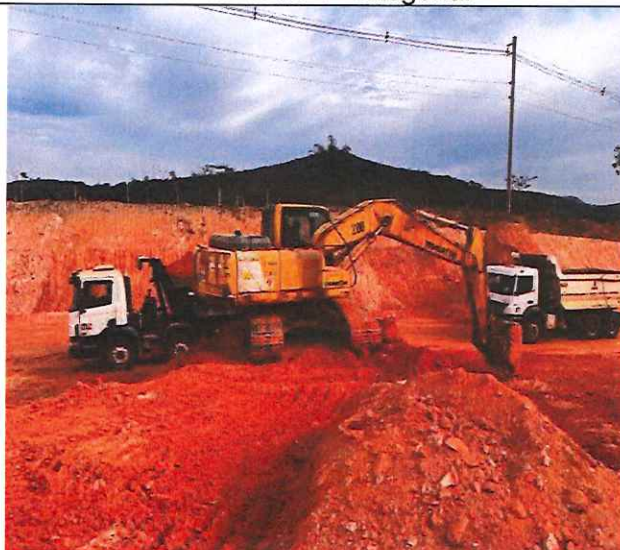
Foto 43 – Escavação, carga e transporte de material de 2ª categoria.
