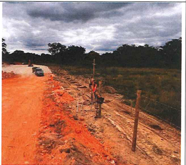
Foto 20 – Remoção de cercas e mourões.
