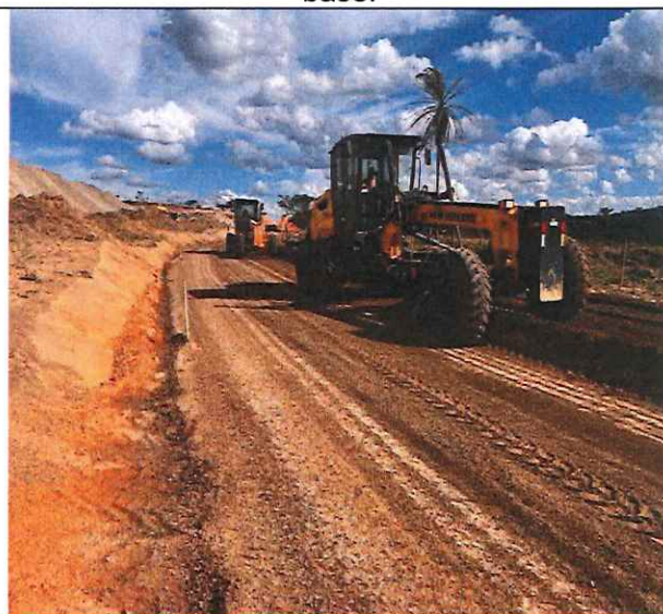
Foto 76 – Execução e compactação de base.
