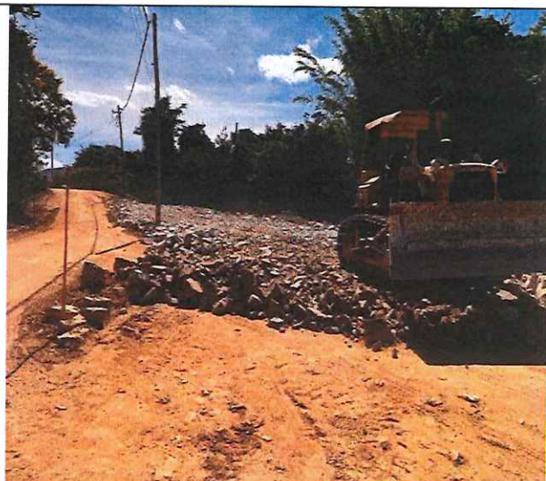
Foto 26 – Enrocamento com pedra de mão.
