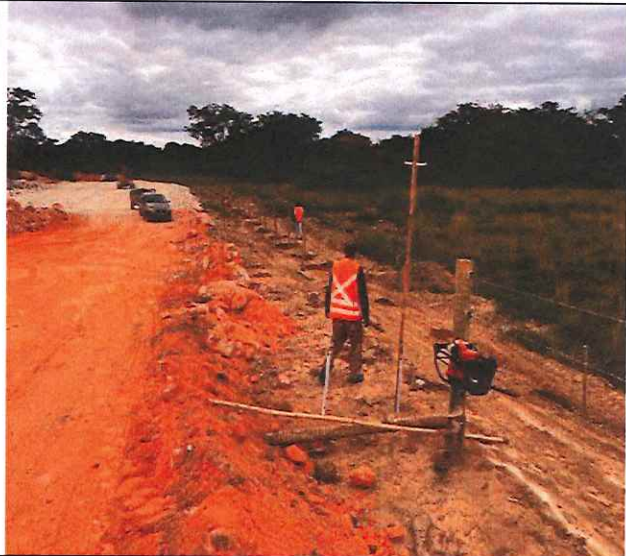
Foto 19 – Remoção de cercas e mourões.
