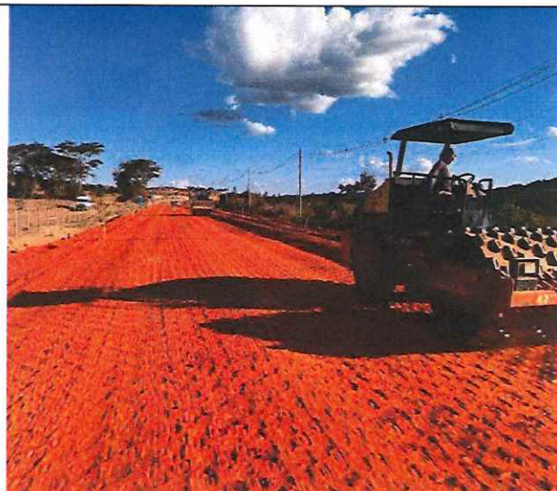
Foto 62 – Regularização e compactação de subleito.
