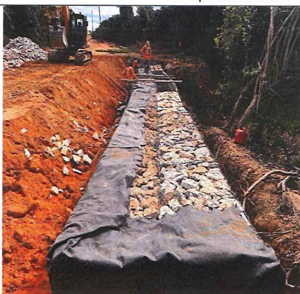
Foto 28 – Execução de arrimo em gabião tipo caixa.
