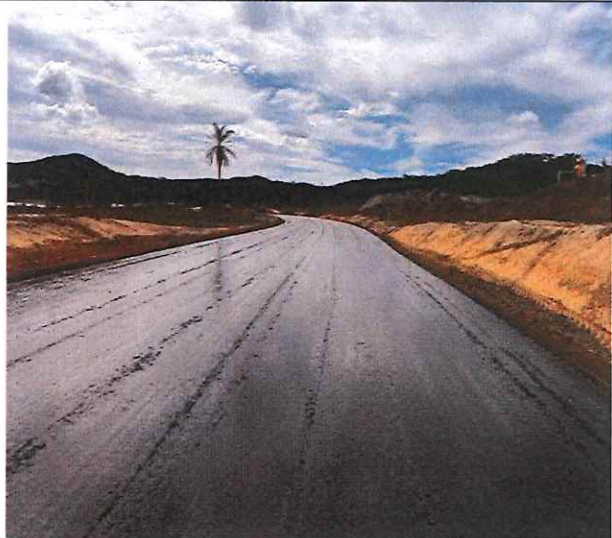
Foto 84 – Imprimação asfáltica.
