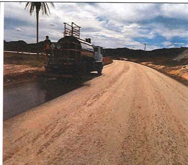
Foto 82 – Imprimação asfáltica.
