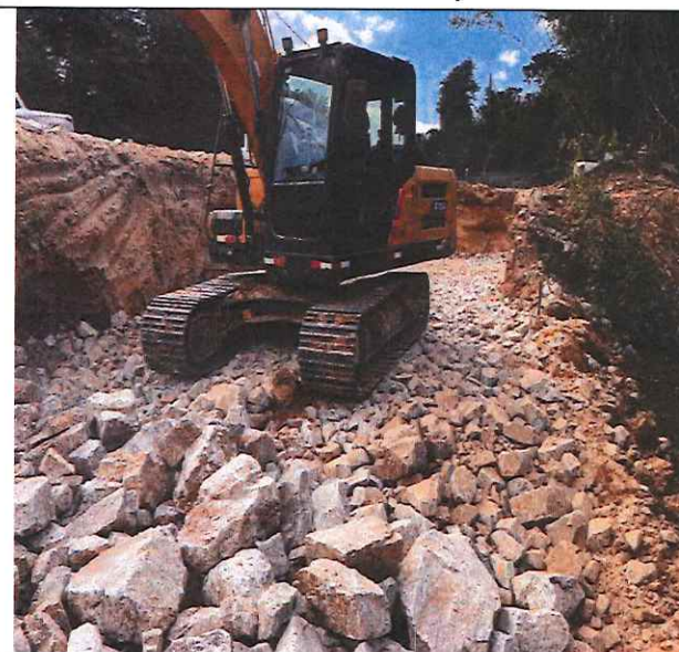
Foto 27 – Enrocamento fundo de gabião.
