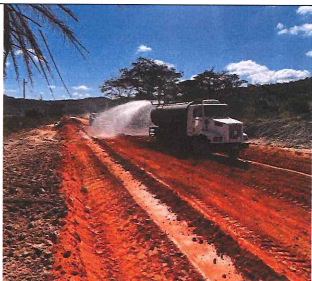
Foto 59 – Regularização e compactação de subleito.
