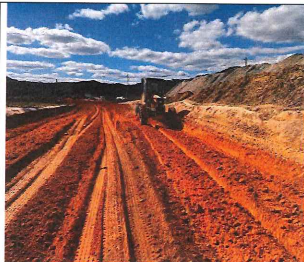
Foto 58 – Regularização e compactação de subleito.
