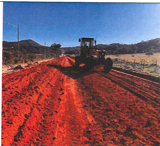
Foto 53 – Execução de camada final de aterro.
