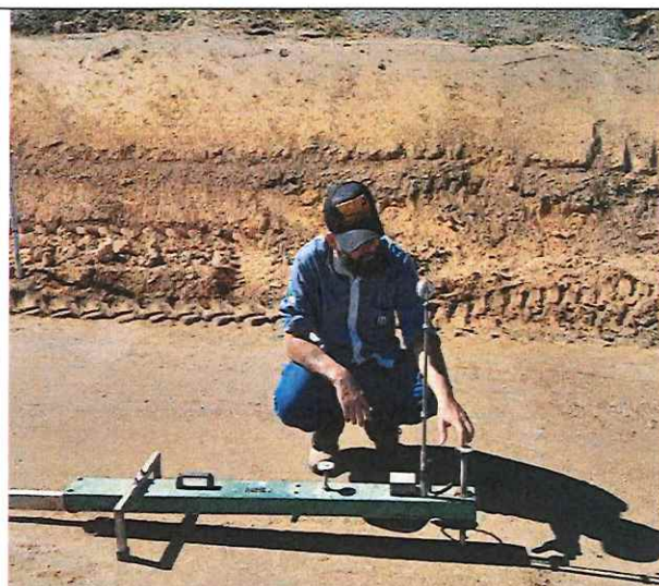
Foto 106 – Liberação camada de sub-base
