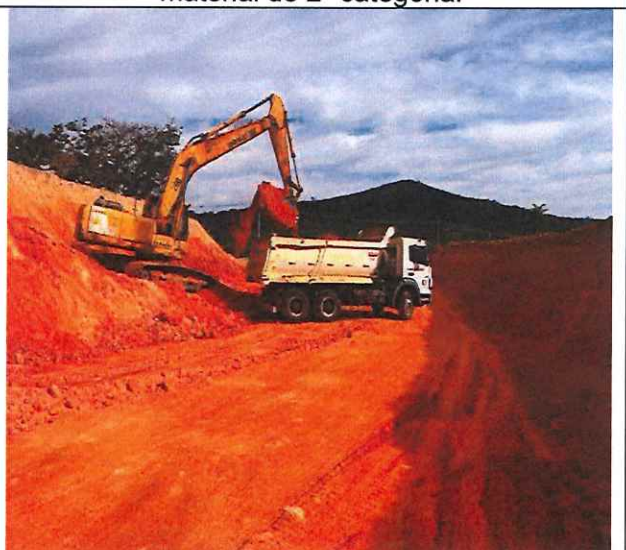
Foto 44 – Escavação, carga e transporte de material de 2ª categoria.
