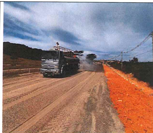
Foto 78 – Execução e compactação de base.
