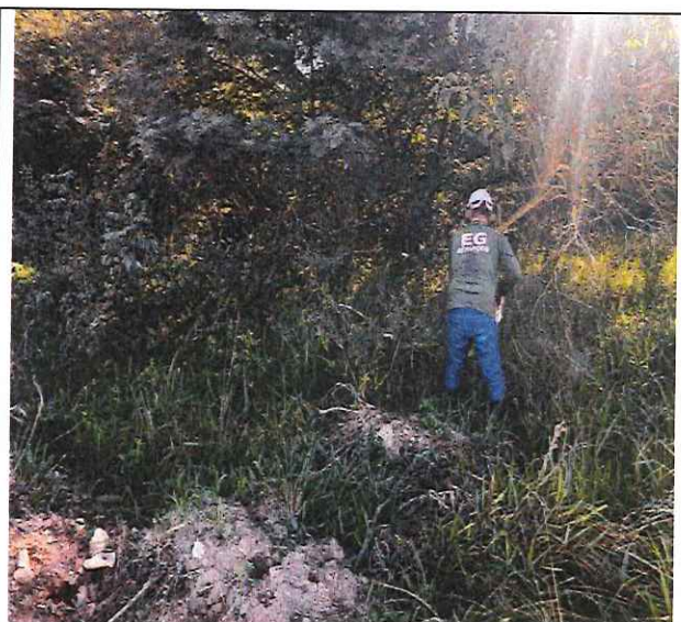
Foto 10 – Desmatamento, destocamento, limpeza de área.
