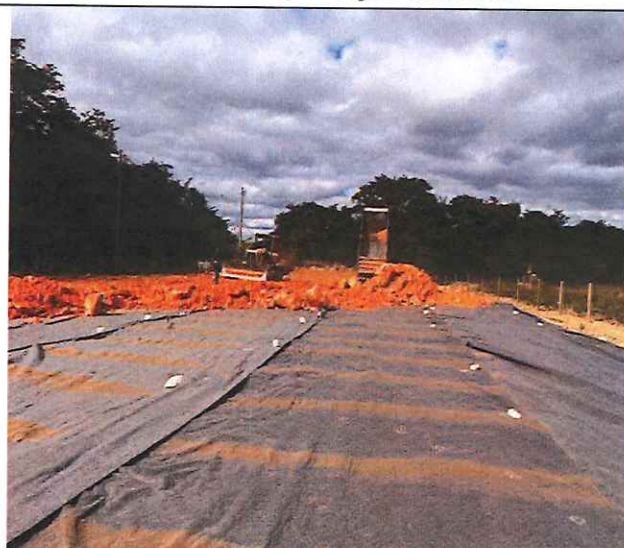
Foto 87 – Instalação de manta bidim na camada de enrocamento.
