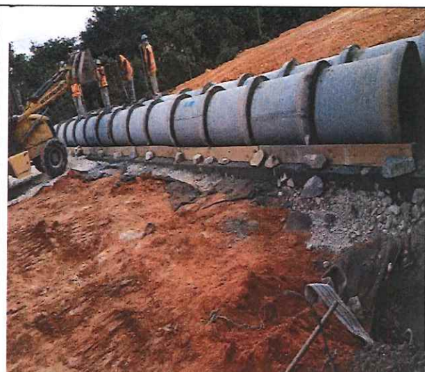
Foto 98 – Tubo de concreto duplo DN 800 mm.
