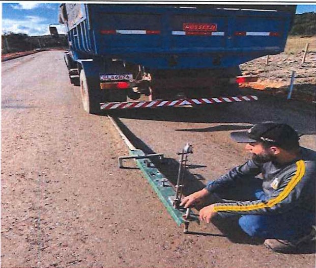
Foto 103 – Ensaio de viga benkelman, liberação de base em BGS.
