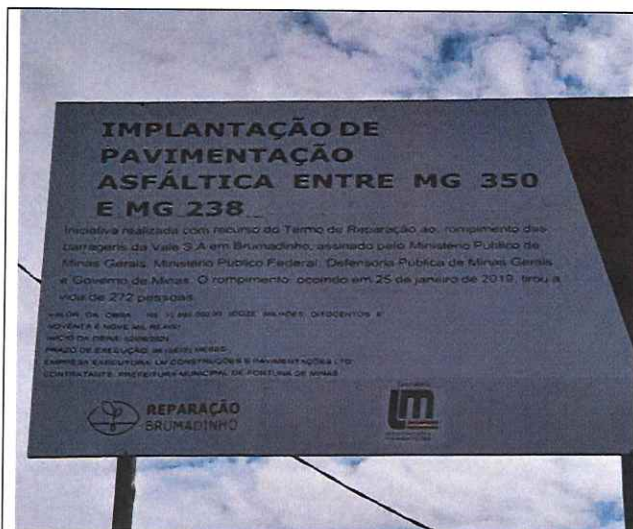
Foto 01 – Placa da Obra
