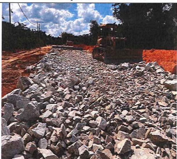
Foto 24 – Enrocamento com pedra de mão.
