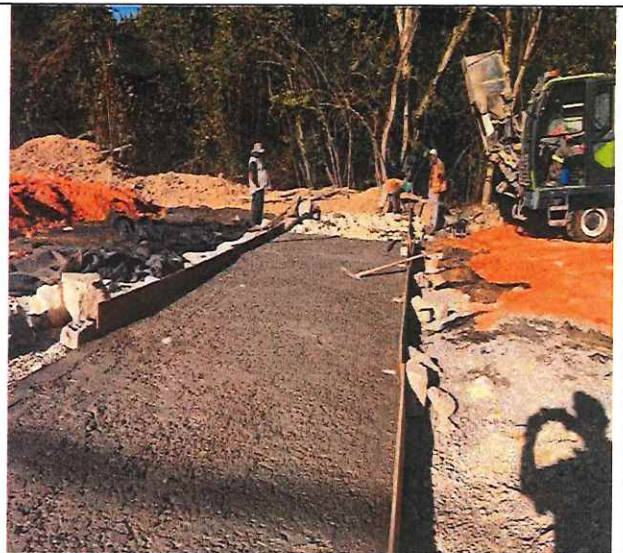
Foto 94 – Forma e concreto para berço tubular.
