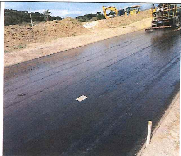
Foto 86 – Imprimação asfáltica.
