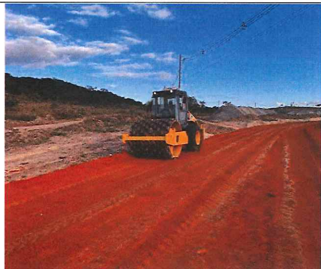
Foto 63 – Regularização e compactação de subleito.
