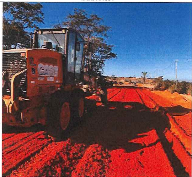
Foto 60 – Regularização e compactação de subleito.
