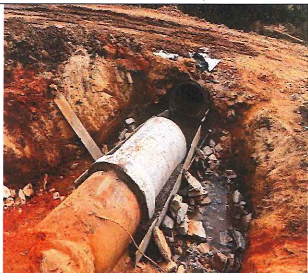
Foto 100 – Prolongamento de rede tubo DN 800 mm.
