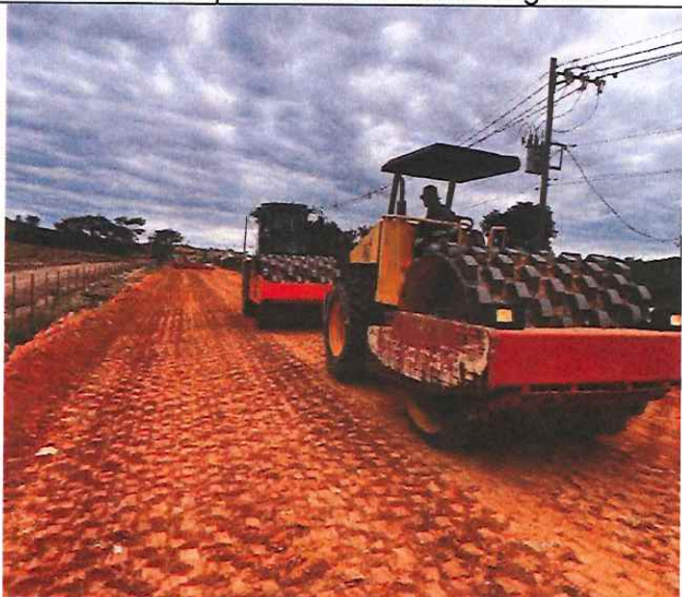
Foto 47 – Execução e compactação de aterro com solo predominantemente argiloso.
