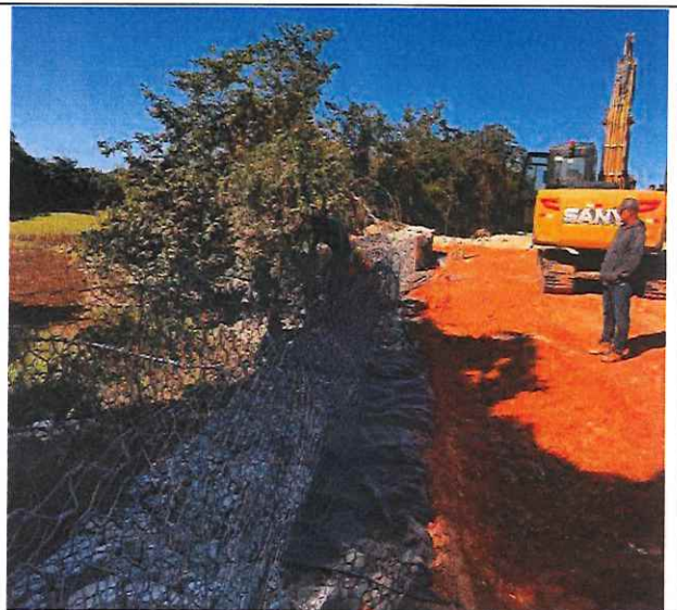
Foto 34 – Execução de arrimo em gabião tipo caixa.
