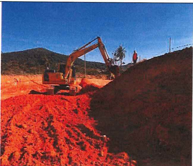
Foto 55 – Execução de rampa 1x1.
