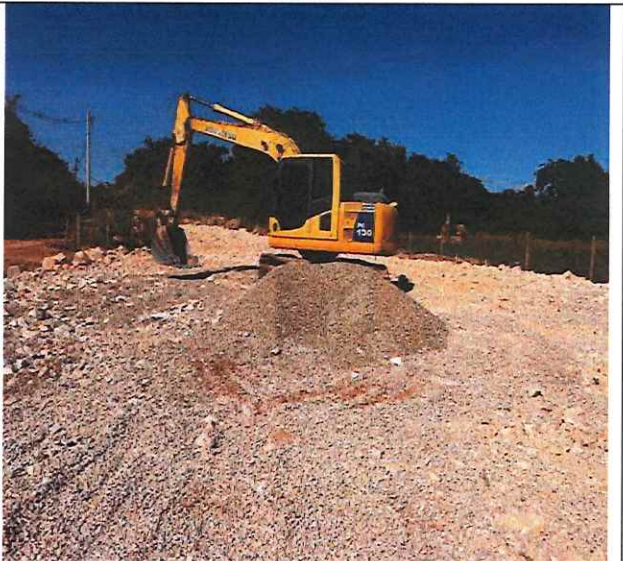
Foto 36 – Transição de enrocamento.
