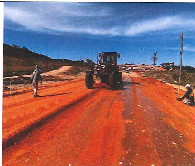
Foto 65 – Regularização e compactação de subleito.
