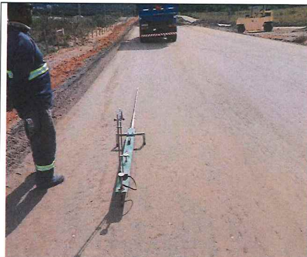
Foto 109 – Liberação camada de base.
