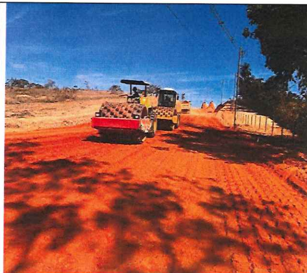
Foto 46 – Execução e compactação de aterro com solo predominantemente argiloso.
