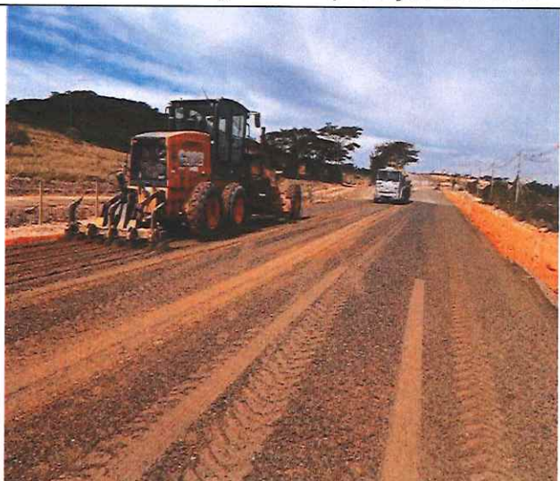
Foto 79 – Execução e compactação de base.
