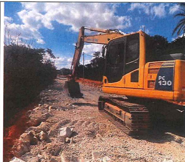
Foto 37 – Transição de enrocamento.
