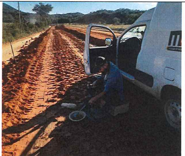
Foto 104 – Liberação camada de aterro escalonamento
