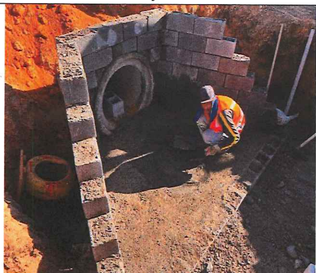
Foto 111 – Execução de ala.
