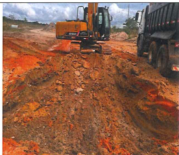
Foto 26 – Escavação e espalhamento de solo mole.
