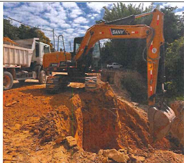
Foto 51 – Escavação mecanizada de vala para execução do muro de arrimo em gabião.
