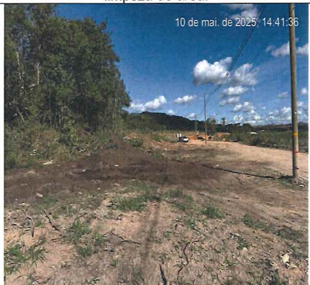
Foto 12 – Desmatamento, destocamento, limpeza de área.
