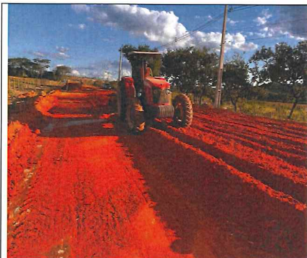
Foto 41 – Execução de camada de reforço de subleito.
