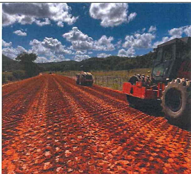
Foto 48 – Execução e compactação de aterro com solo predominantemente argiloso. Estaca 90 a 100.
