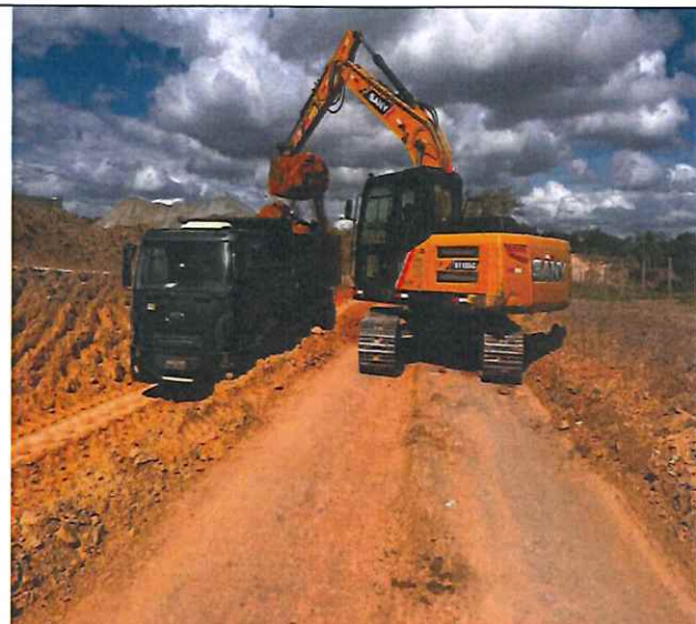
Foto 37 – Escavação vertical a céu aberto em solo de 1ª categoria.
