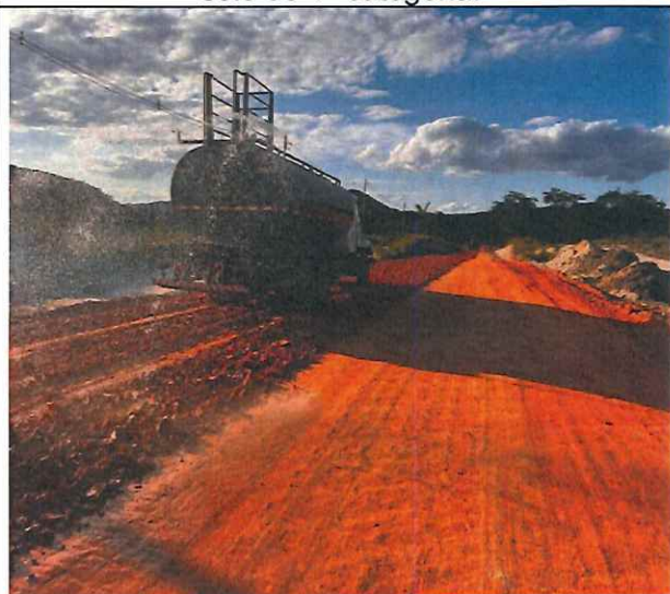
Foto 40 – Execução de camada de reforço de subleito.
