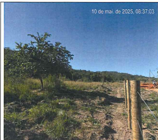
Foto 09 – Desmatamento, destocamento, limpeza de área.
