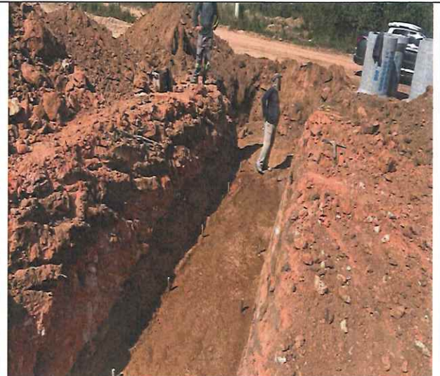
Foto 58 – Preparo e compactação de fundo de vala.
