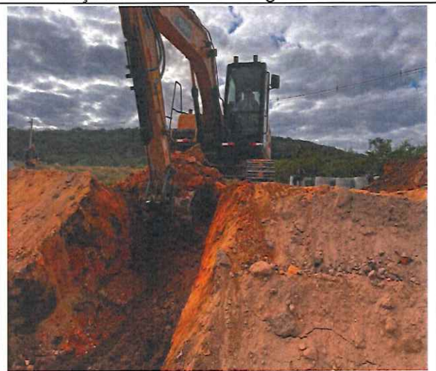
Foto 56- Escavação mecanizada de vala para execução de rede de drenagem. Estaca 89.
