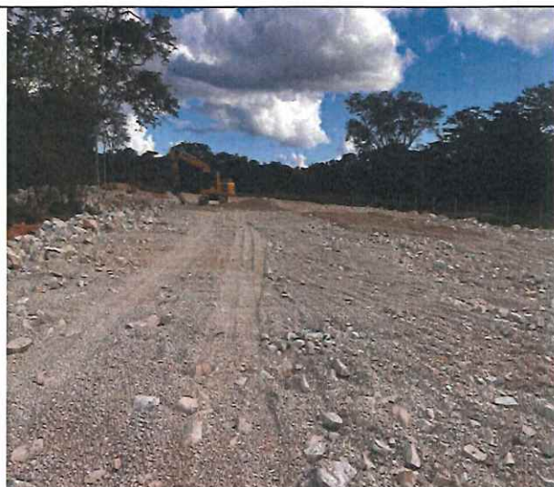
Foto 32 – Transição de material para execução de enrocamento.
