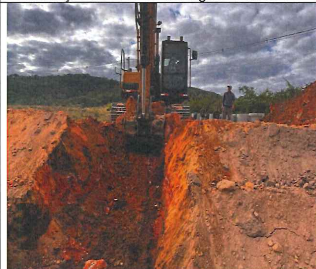
Foto 55 – Escavação mecanizada de vala para execução de rede de drenagem. Estaca 89.
