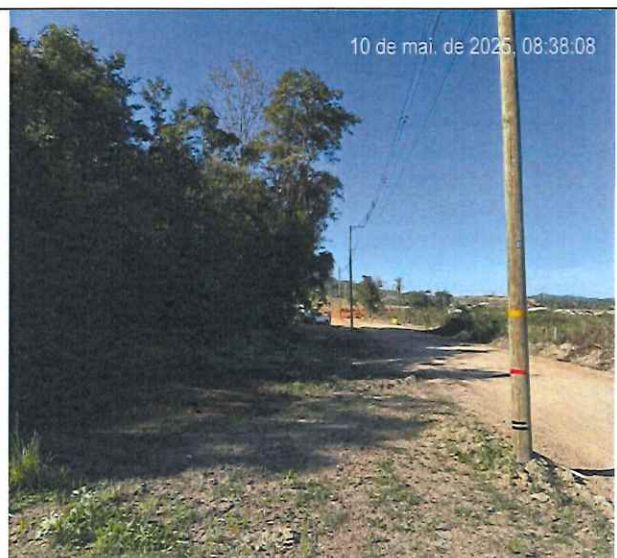
Foto 10 – Desmatamento, destocamento, limpeza de área.
