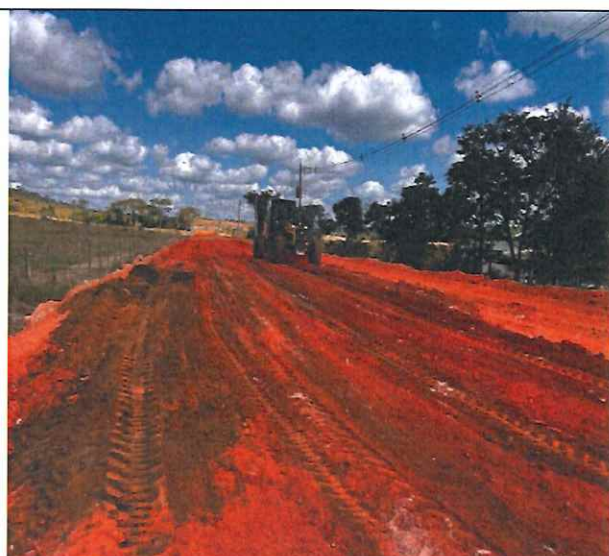
Foto 46 – Regularização de camada de aterro.
