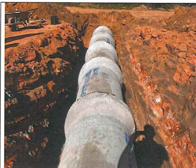
Foto 61 – Tubo de concreto DN 800 mm.
