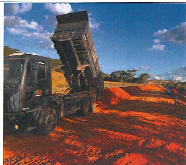
Foto 45 – Lançamento de material para execução de aterro.
