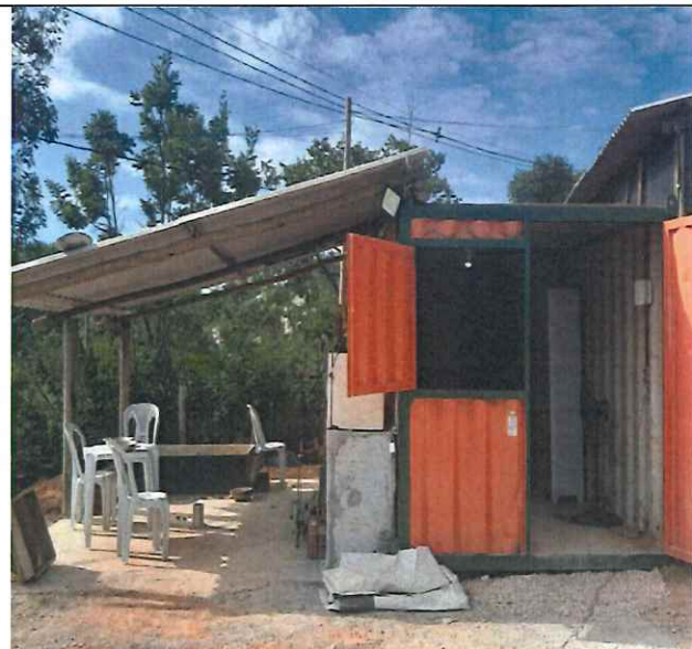
Foto 05 – Locação de Container
