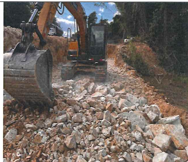
Foto 29 – Enrocamento do Gabião com pedra de mão.
