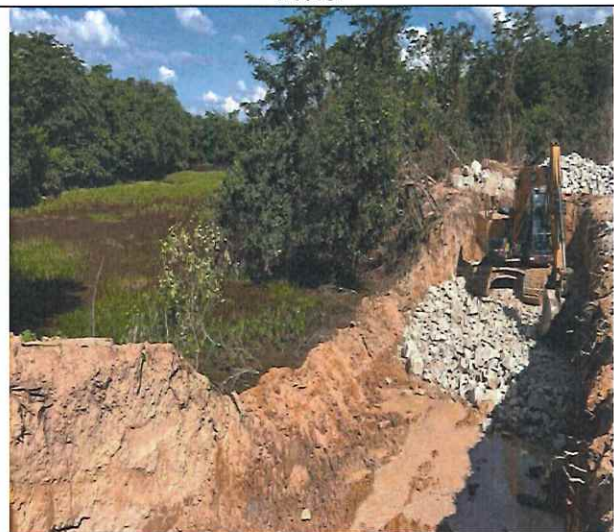
Foto 28 – Enrocamento do Gabião com pedra de mão.
