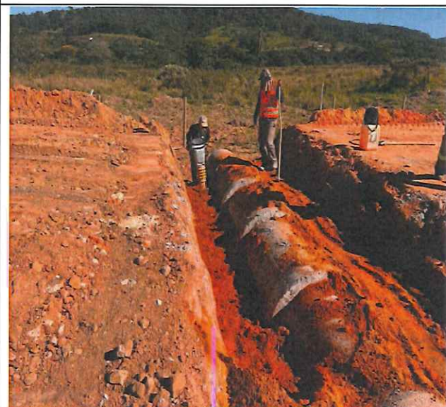
Foto 63 – Reaterro de valas com compactação mecanizada.
