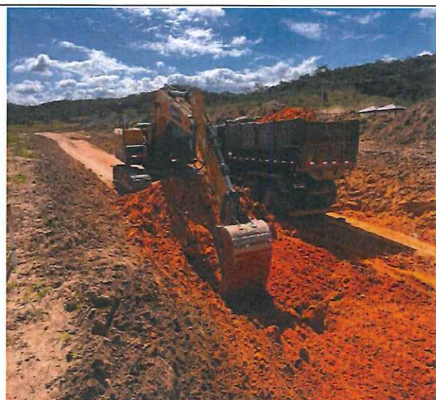
Foto 38 – Escavação vertical a céu aberto em solo de 1ª categoria.
