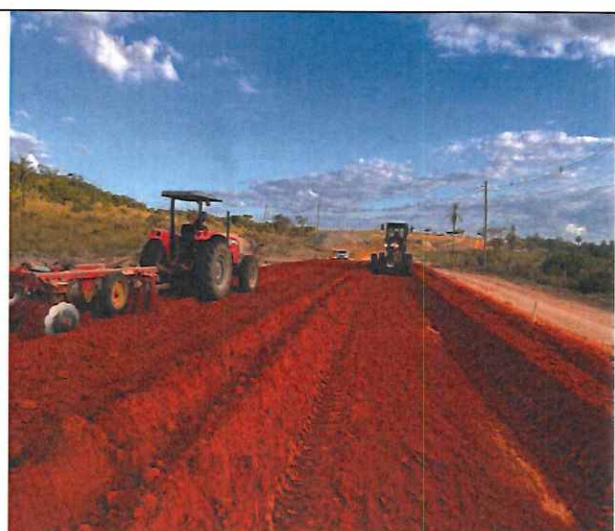
Foto 42 – Execução de camada de reforço de subleito.
