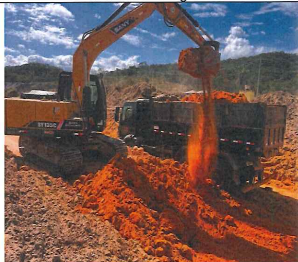
Foto 36 – Escavação vertical a céu aberto em solo de 1ª categoria.
