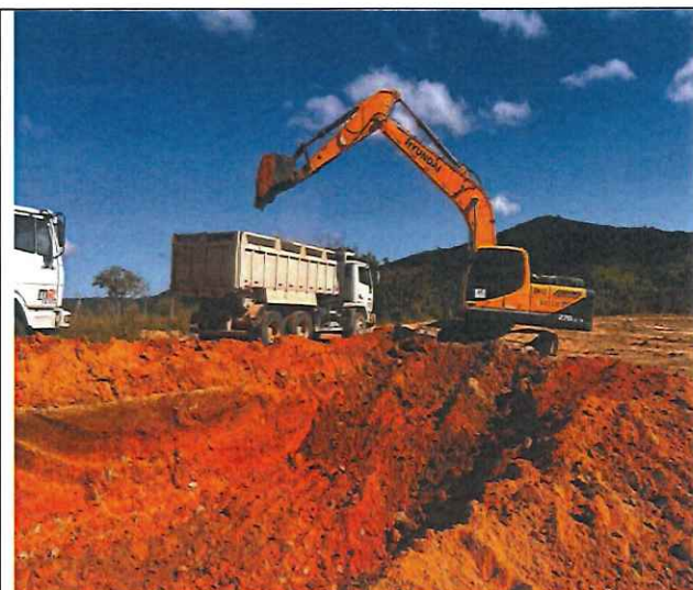
Foto 33 – Escavação vertical a céu aberto em solo de 1ª categoria.
