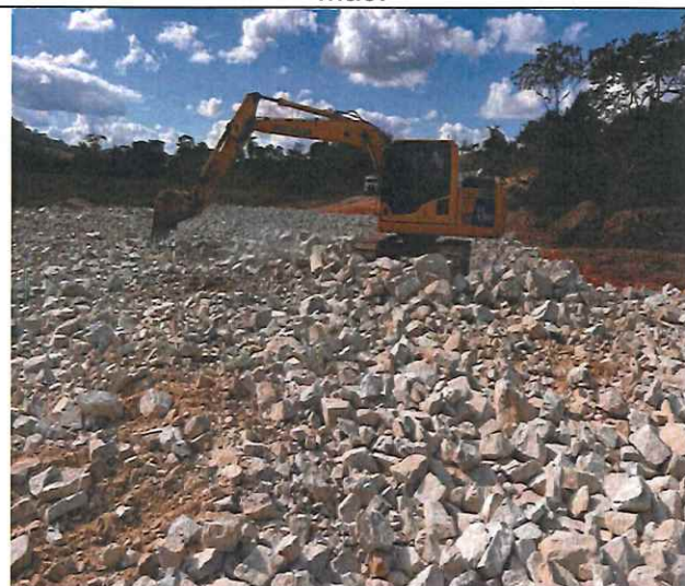
Foto 31 – Enrocamento com pedra de mão.
