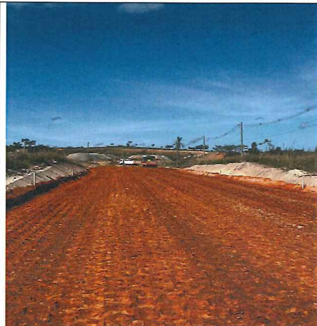
Foto 49 – Execução e compactação de aterro com solo predominantemente argiloso. Estaca 80 a 85.
