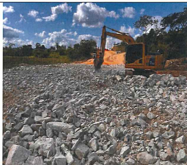
Foto 30 – Enrocamento com pedra de mão.
