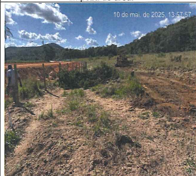
Foto 11 – Desmatamento, destocamento, limpeza de área.
