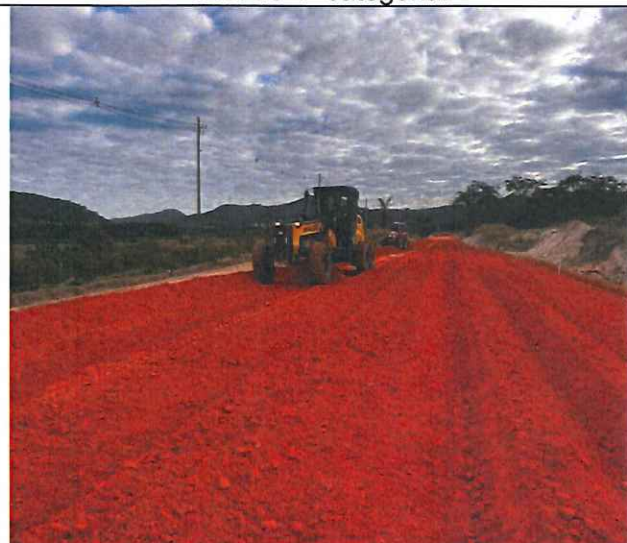
Foto 39 – Execução de camada de reforço de subleito.
