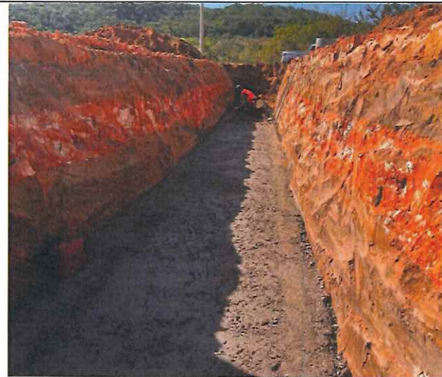
Foto 59 – Concreto para berço tubular.
