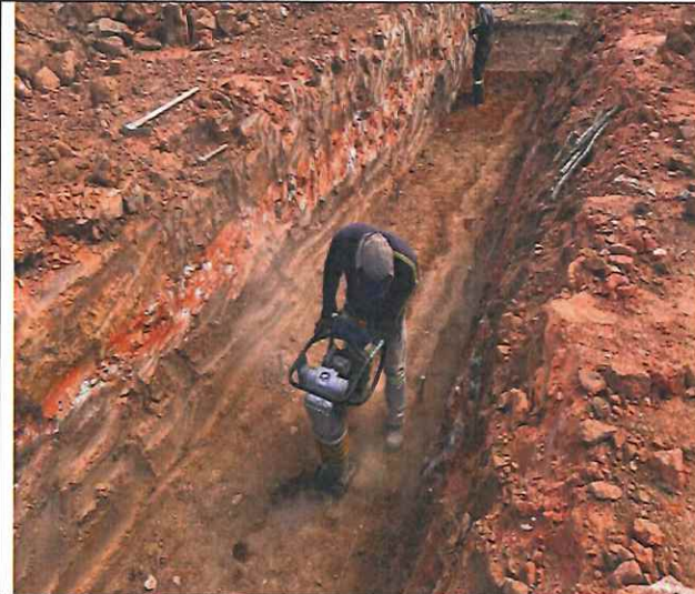
Foto 57 – Preparo e compactação de fundo de vala.
