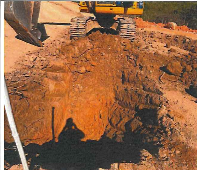
Foto 53 – Escavação mecanizada de vala para execução de rede de drenagem. Estaca 44.
