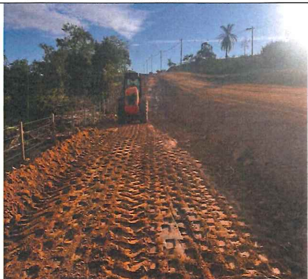
Foto 52 – Compactação de fundo de vala para execução do muro de arrimo em gabião.
