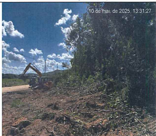
Foto 08 – Desmatamento, destocamento, limpeza de área.
