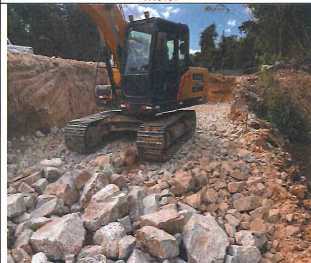
Foto 27 – Enrocamento do Gabião com pedra de mão.
