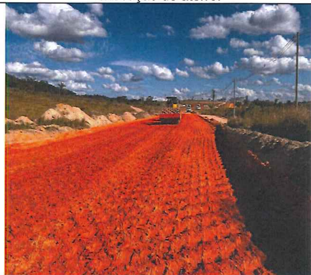
Foto 47 – Execução e compactação de aterro com solo predominantemente argiloso. Estaca 80.
