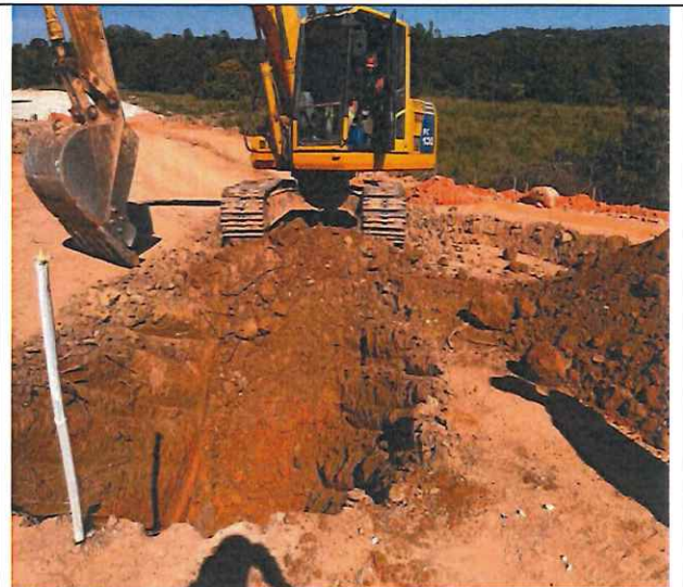
Foto 54 – Escavação mecanizada de vala para execução de rede de drenagem. Estaca 44.
