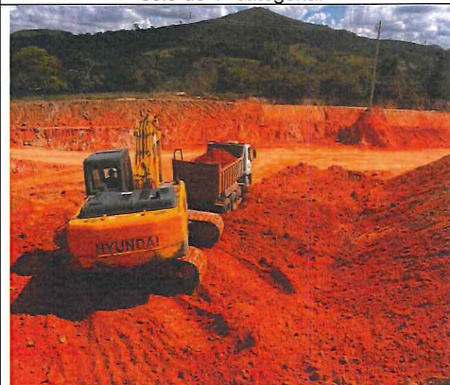
Foto 35 – Escavação vertical a céu aberto em solo de 1ª categoria.
