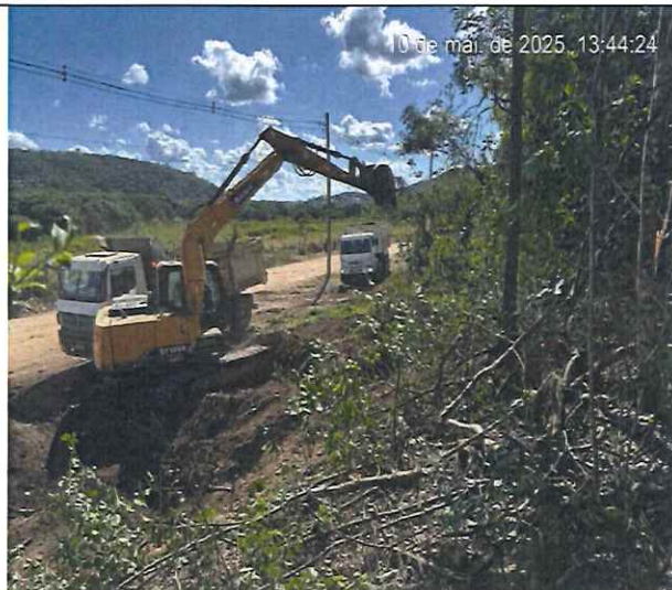
Foto 13 – Desmatamento, destocamento, limpeza de área.
