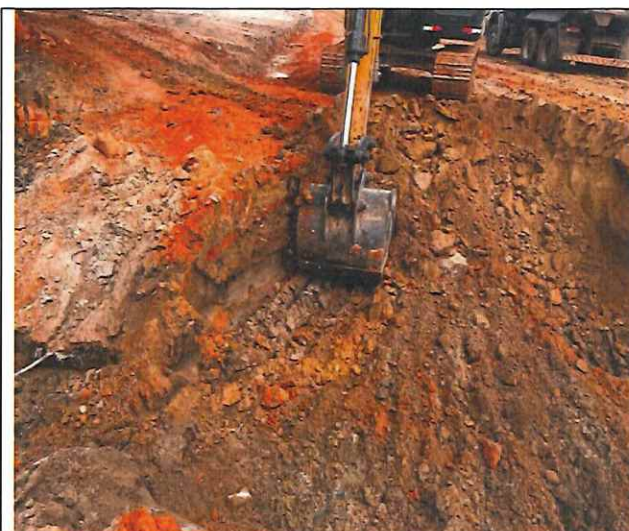
Foto 25 – Escavação e espalhamento de solo mole.
