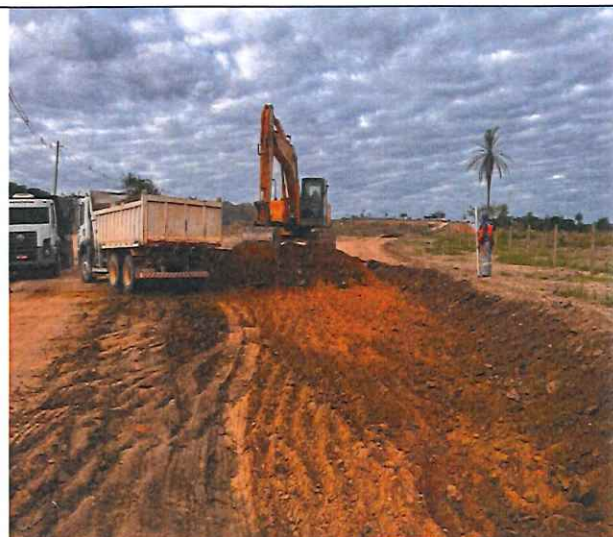
Foto 34 – Escavação vertical a céu aberto em solo de 1ª categoria.
