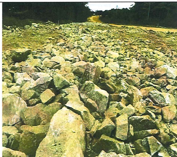
Foto 28 – Enrocamento com pedra de mão.
