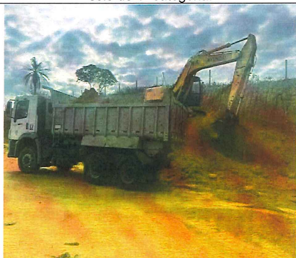
Foto 40 – Escavação vertical a céu aberto em solo de 1ª categoria.
