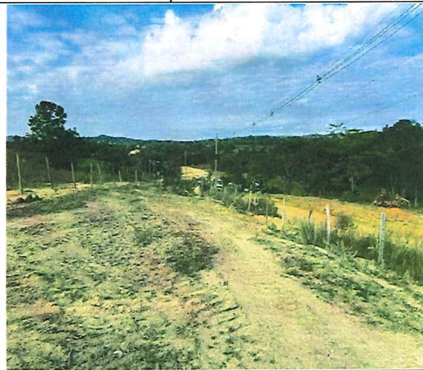
Foto 12 – Desmatamento, destocamento, limpeza de área.
