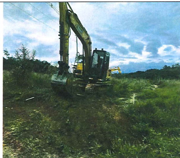
Foto 10 – Desmatamento, destocamento, limpeza de área.
