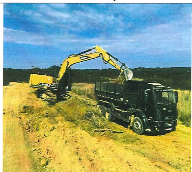
Foto 24 – Limpeza para bota fora.
