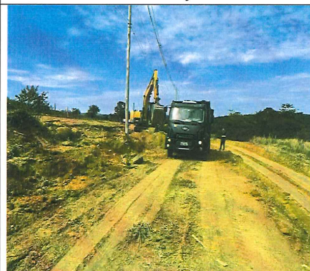
Foto 23 – Limpeza para bota fora.
