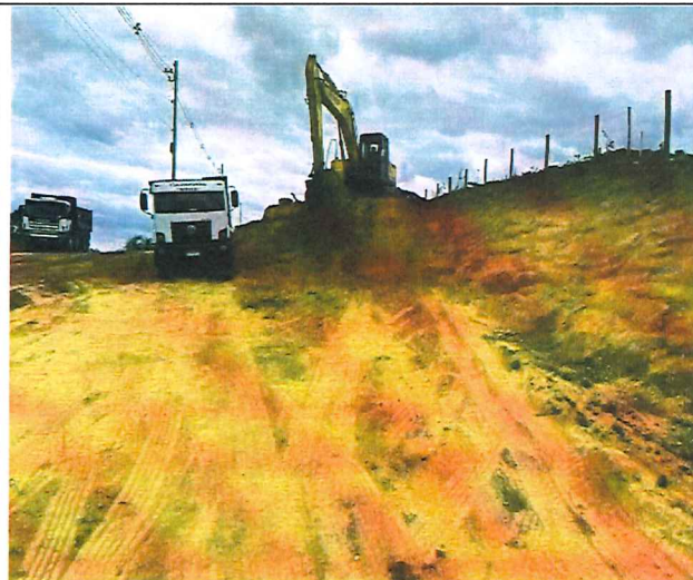
Foto 37 – Escavação vertical a céu aberto em solo de 1ª categoria.
