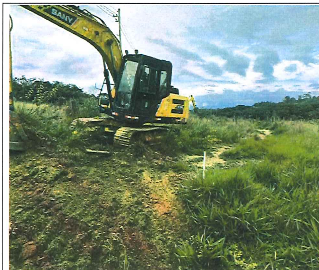
Foto 09 – Desmatamento, destocamento, limpeza de área.
