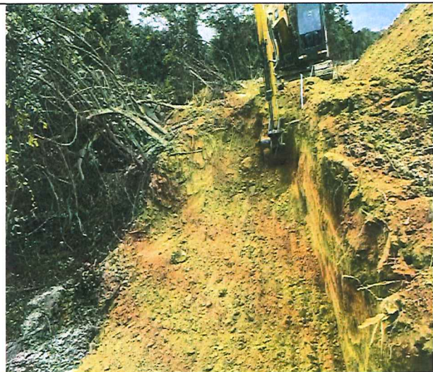
Foto 59 – Escalonamento para execução de gabião.
