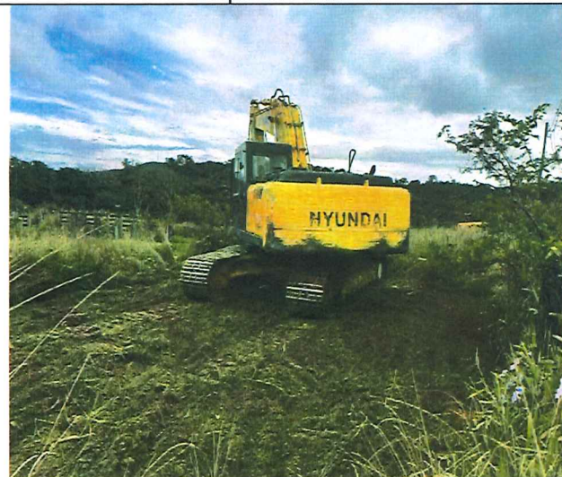
Foto 11 – Desmatamento, destocamento, limpeza de área.
