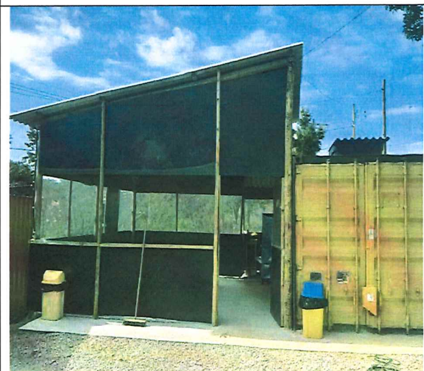
Foto 04 – Locação de Container
