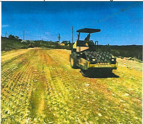
Foto 52 – Execução e compactação de aterro com solo predominantemente argiloso.
