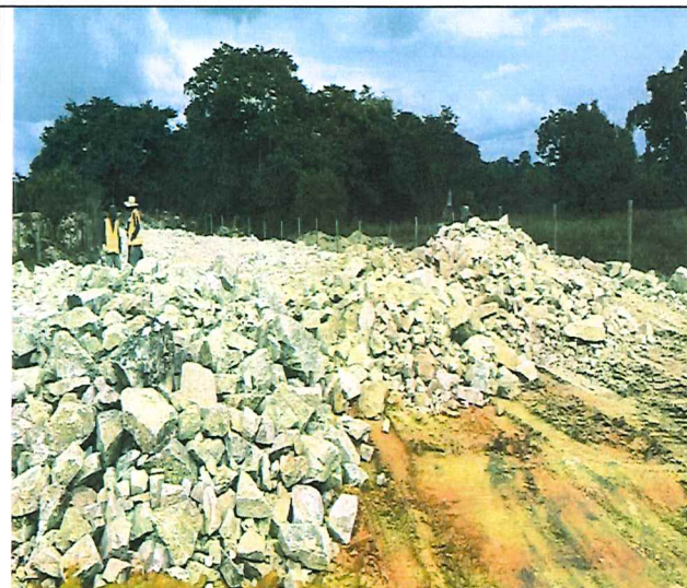
Foto 25 – Enrocamento com pedra de mão.
