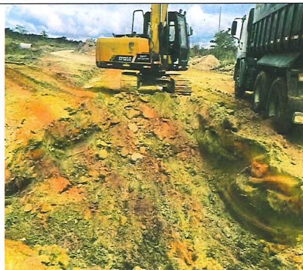
Foto 31 – Escavação mecânica em solo mole.
