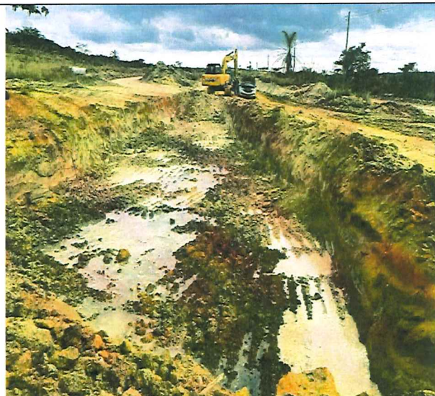
Foto 32 – Escavação mecânica em solo mole.
