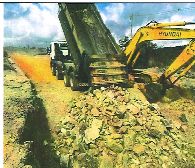
Foto 27 – Enrocamento com pedra de mão.
