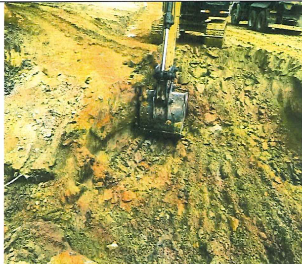
Foto 30 – Escavação mecânica em solo mole.
