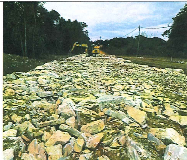
Foto 29 – Enrocamento com pedra de mão.
