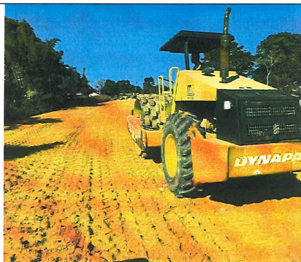
Foto 46 – Execução e compactação de aterro com solo predominantemente argiloso.
