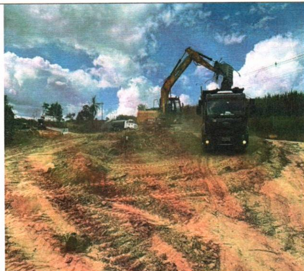
Foto 17 – Desmatamento, destocamento, limpeza de área.
