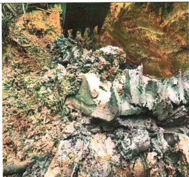
Foto 38 – Escavação mecânica em solo mole.
