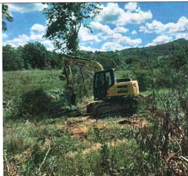
Foto 14 – Desmatamento, destocamento, limpeza de área.
