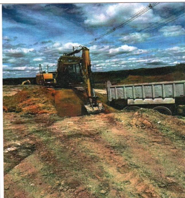
Foto 43 – Escavação vertical a céu aberto em solo de 1ª categoria.
