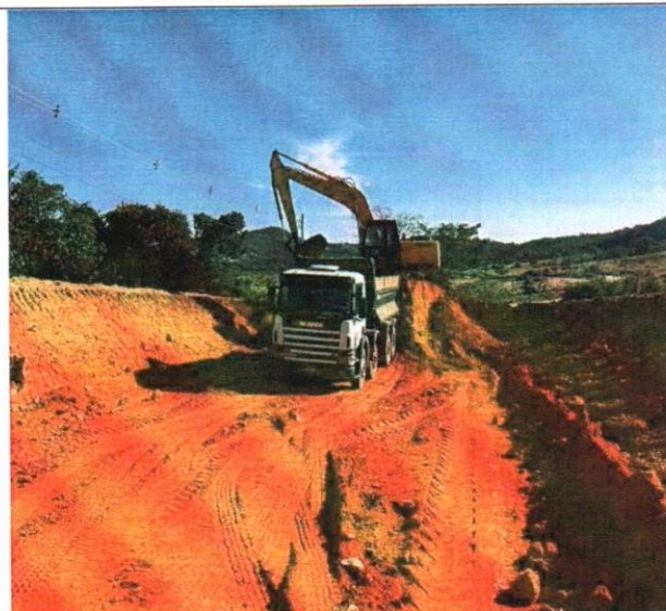
Foto 45 – Escavação vertical a céu aberto em solo de 1ª categoria.
