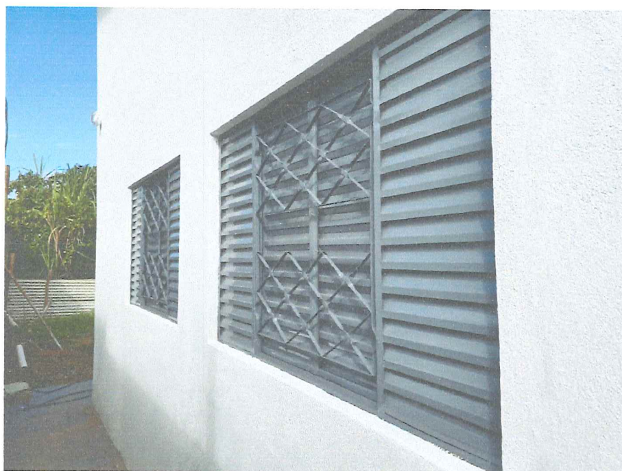
Figura 8 – Lateral da casa de apoio
