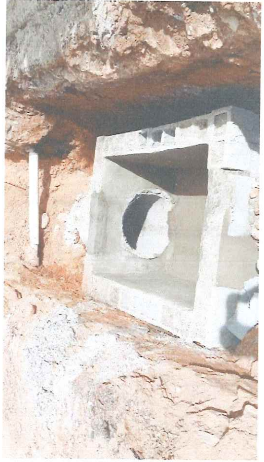
EXECUÇÃO DE PV
