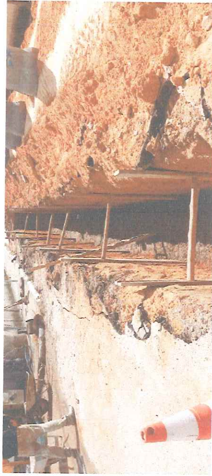
CONCRETAGEM DE BERÇO
