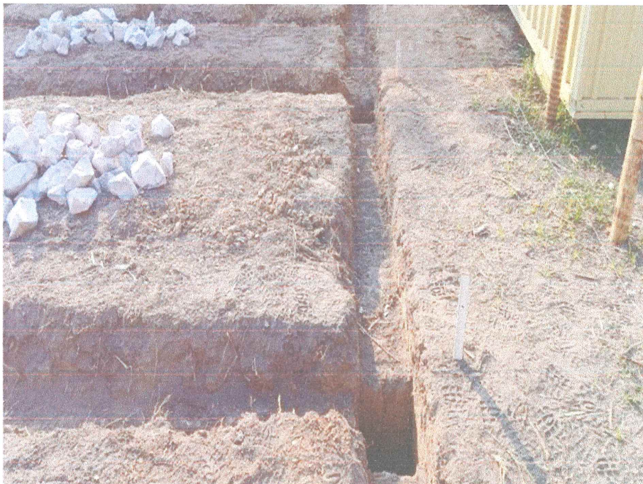
Figura 4 - Execução cintas casa de operações
