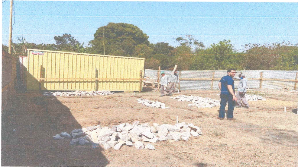
Figura 5 - Execução cintas casa de operações
