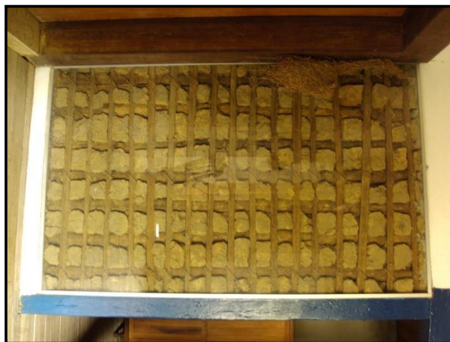
Parede de taipa - Fazenda dos Macacos.
